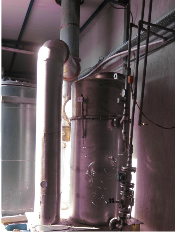
Şekil 5.5. Uygulanan gövde borulu ısı deęiřtiricisi.
