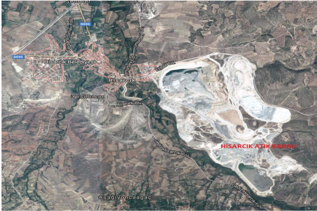
Şekil 4.1. Eti Maden İşletmeleri Hisarcık atık barajı konumu.
