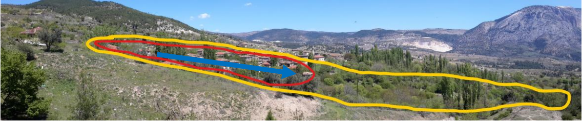
Şekil 8.6. Gölpazarı Üzümlü köyünde meydana gelen heyelana ait bir görüntü. (Kırmızı çizgi 1. analiz için kapama yapılan alanı, sarı çizgi 2. analiz için kapatılan alanı, mavi ok heyelan yönünü göstermektedir) (kuzeydoğu yönüne doğru çekilmiştir).
