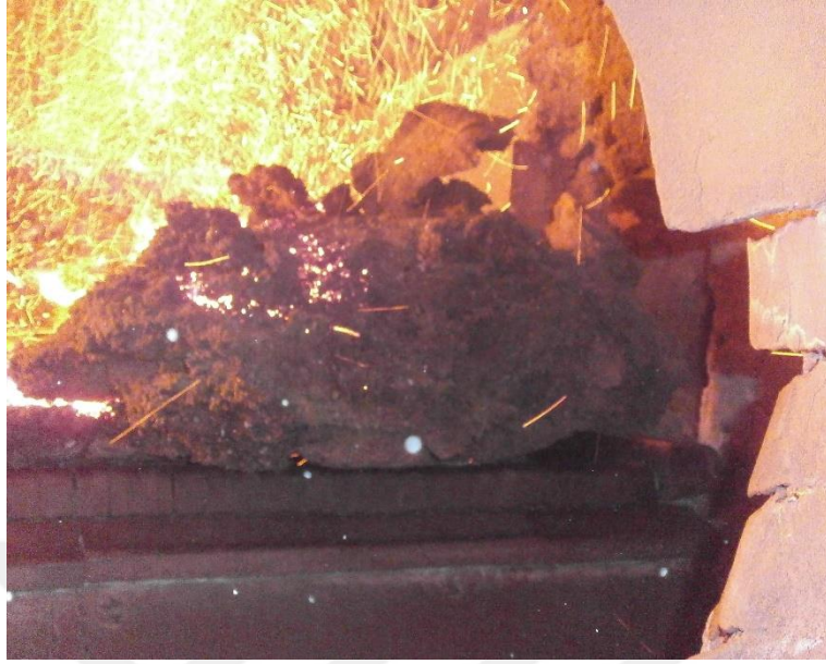
Şekil 5.4. Kazanın külhan bölgesinde meydana gelen cüruf.
