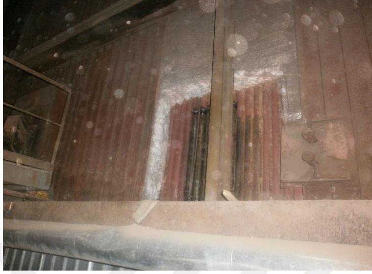
Şekil 5.5. Kazanın ekran duvarlarında bulunan yalıtım.
