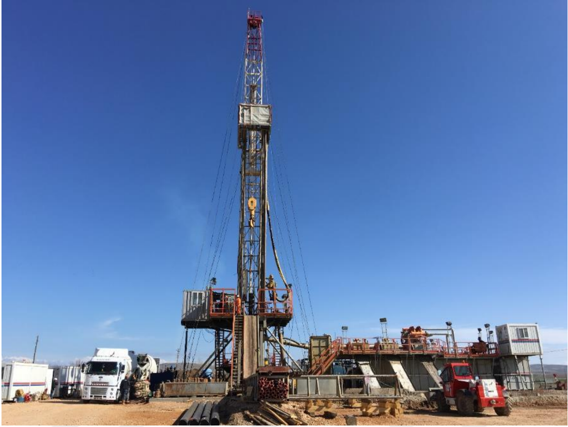
Şekil 5.16. EMT-2016/2 jeotermal araştırma sondajından bir görünüm.
