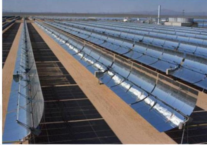
Şekil 4.4. Parabolik oluk tip YGE sistemi şematik gösterimi.
