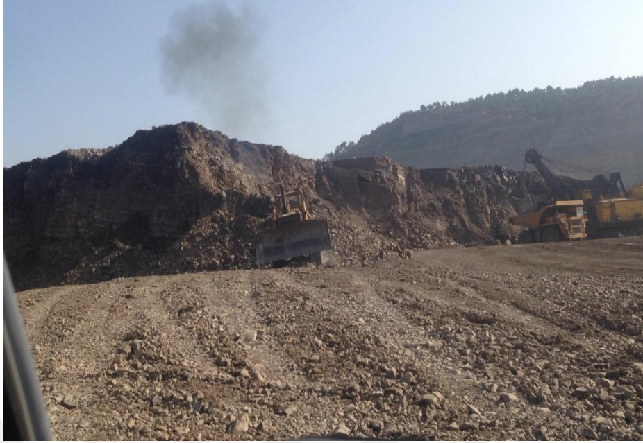
Şekil 5.4. Tırnağın dozerle ripelenmesi görüntüsü.
