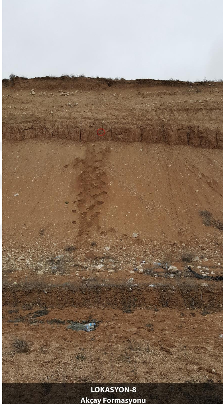
Şekil 3.14. Lokasyon-8, Eskişehir-Kütahya yolu üzeri (Yeniakçayır Mah.-Tepebaşı İlçesi-Eskişehir)-D230 Karayolu.
