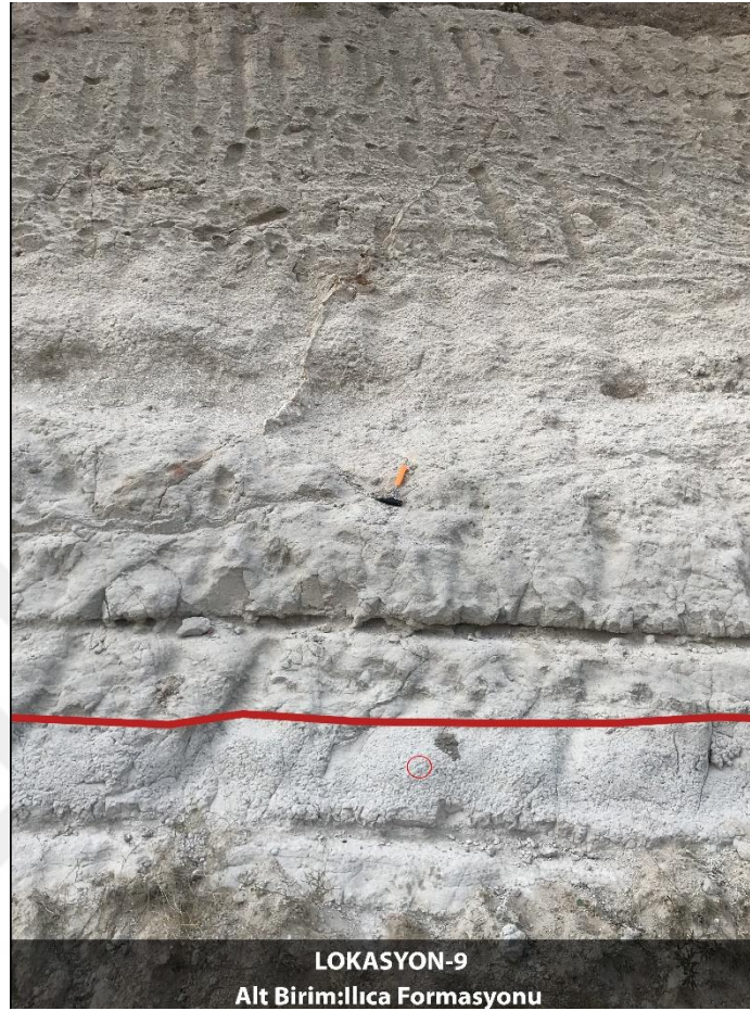
Şekil 3.13. Lokasyon-9, Eskişehir- Afyonkarahisar yolu üzeri (Sarayören Mah. Seyitgazi İlçesi- Eskişehir)-D665 karayolu.
