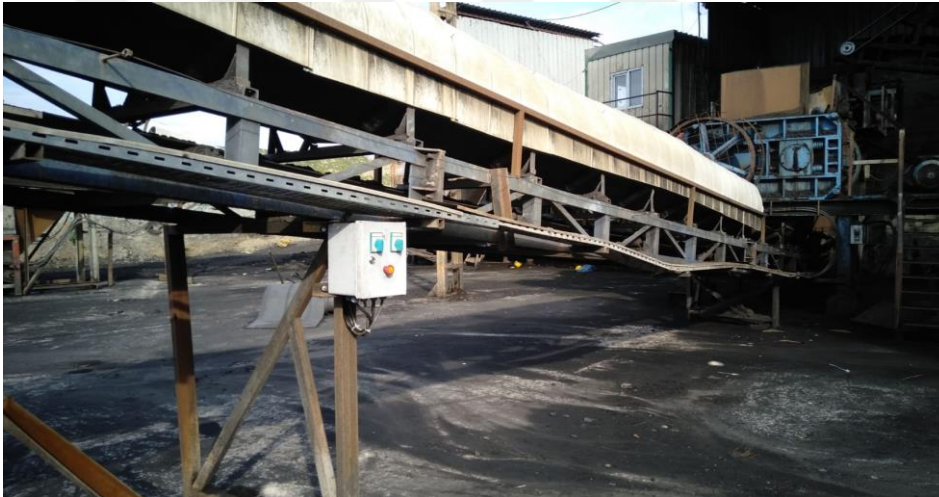
Şekil 5.15. Tesis içi kömür nakliye bantları.
