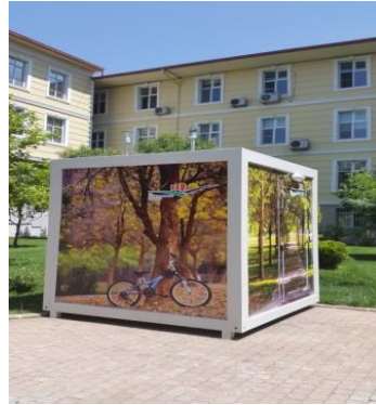
Şekil 4.3. Hava kalitesi izleme istasyonu.
