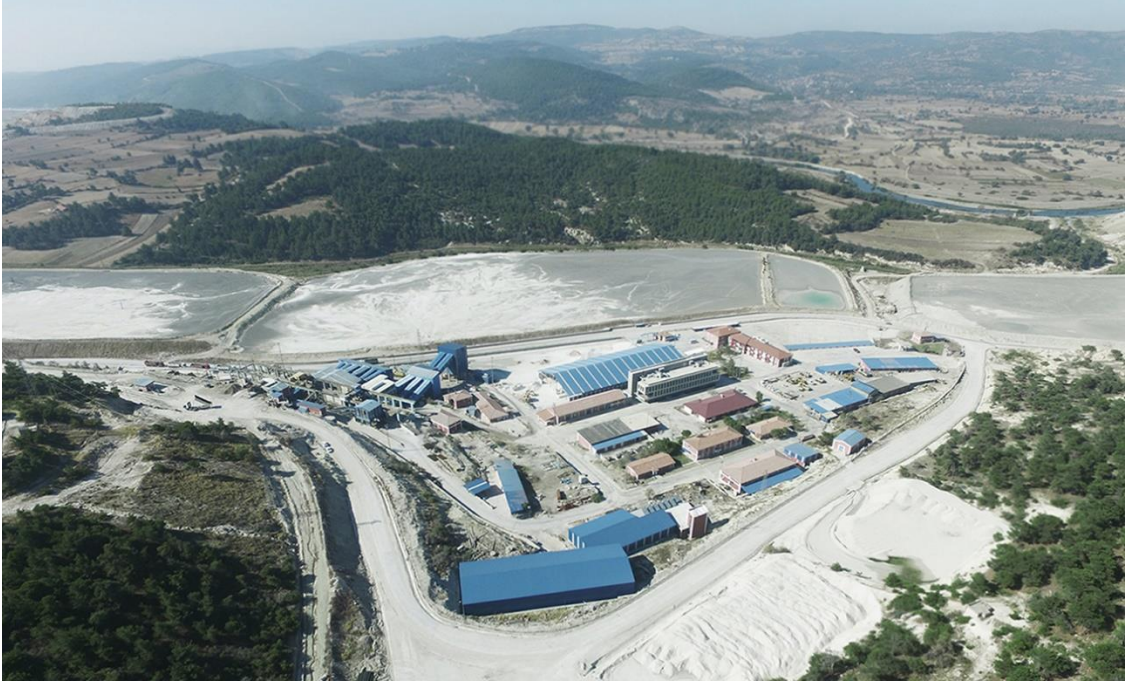
Şekil 3.3. Kırka Bor İşletme Müdürlüğü (Eti Maden Web Sitesi, 2019).
