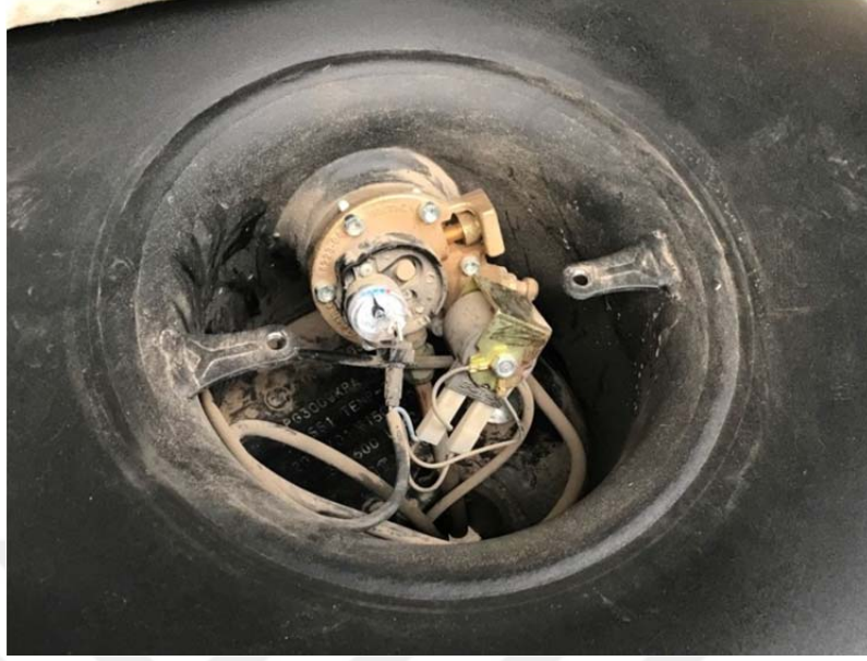
Şekil 4.36. Cıvatalarla uygun bir şekilde montajı yapılmış tank örneği (MMO, 2017).
