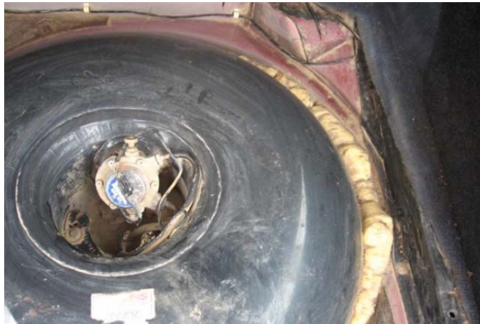
Şekil 4.56. Tank ile metal arası köpükle yalıtılmış tank montajı örneği (MMO, 2017).
