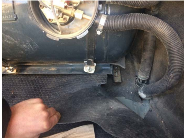
Şekil 4.37. Cıvataları yeterince sıkılmamış, uygunsuz silindirik tank örneği.
