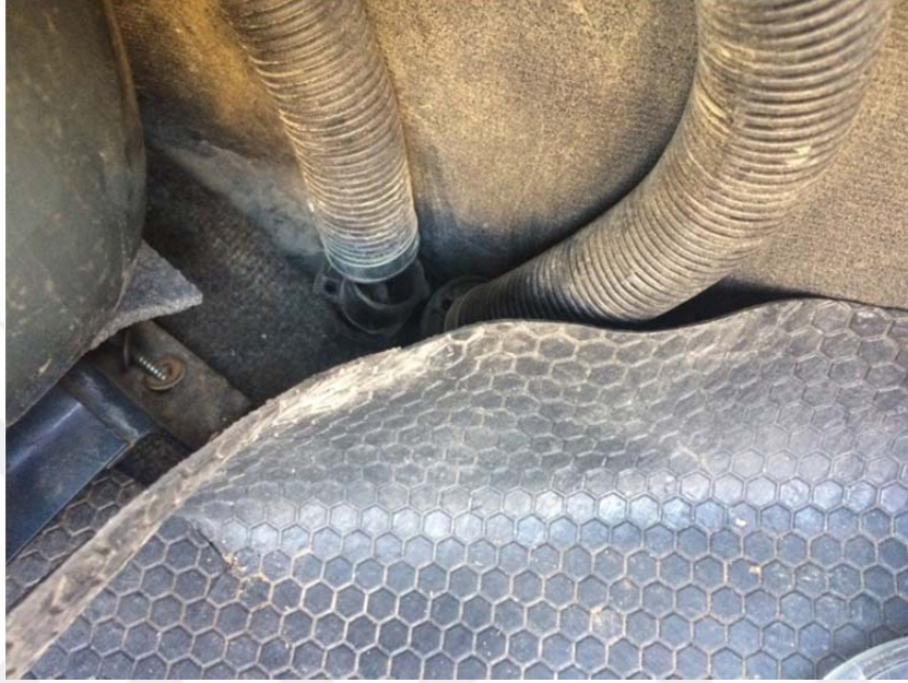
Şekil 4.87. Kırık havalandırma bacası montajı örneği.
