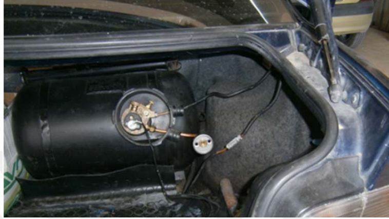
Şekil 4.91. Bagaj içine montajı yapılmış, uygunsuz dolum ağızı örneği (MMO, 2017).
