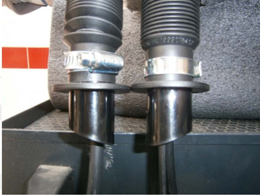
Şekil 4.79. Silindirik tank uygun havalandırma hortum bacası örneği (MMO, 2017).
