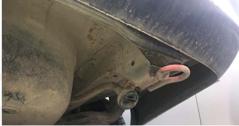
Şekil 4.97. Dolun ağızı aracın altında bulunan uygunsuz montaj örneđi.
