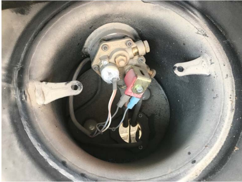
Şekil 4.39. Araç taban sacına 2 adet cıvatayla sabitlenmiş uygun tank montajı örneği.
