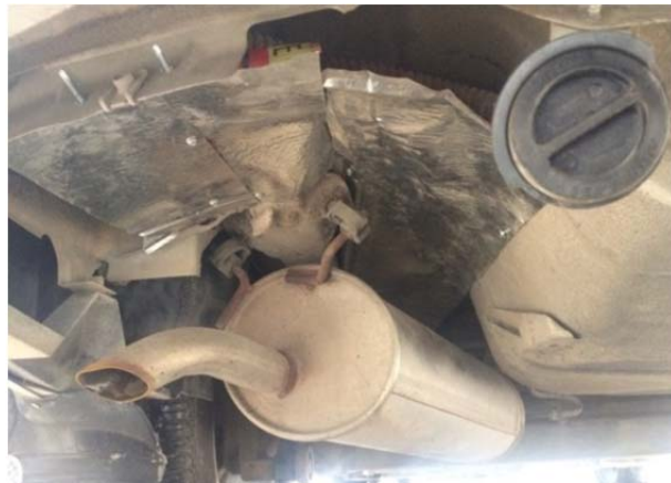
Şekil 4.82. Egzozu yakın olan LPG boruları arasına koyulan yalıtım malzemesi örneği.
