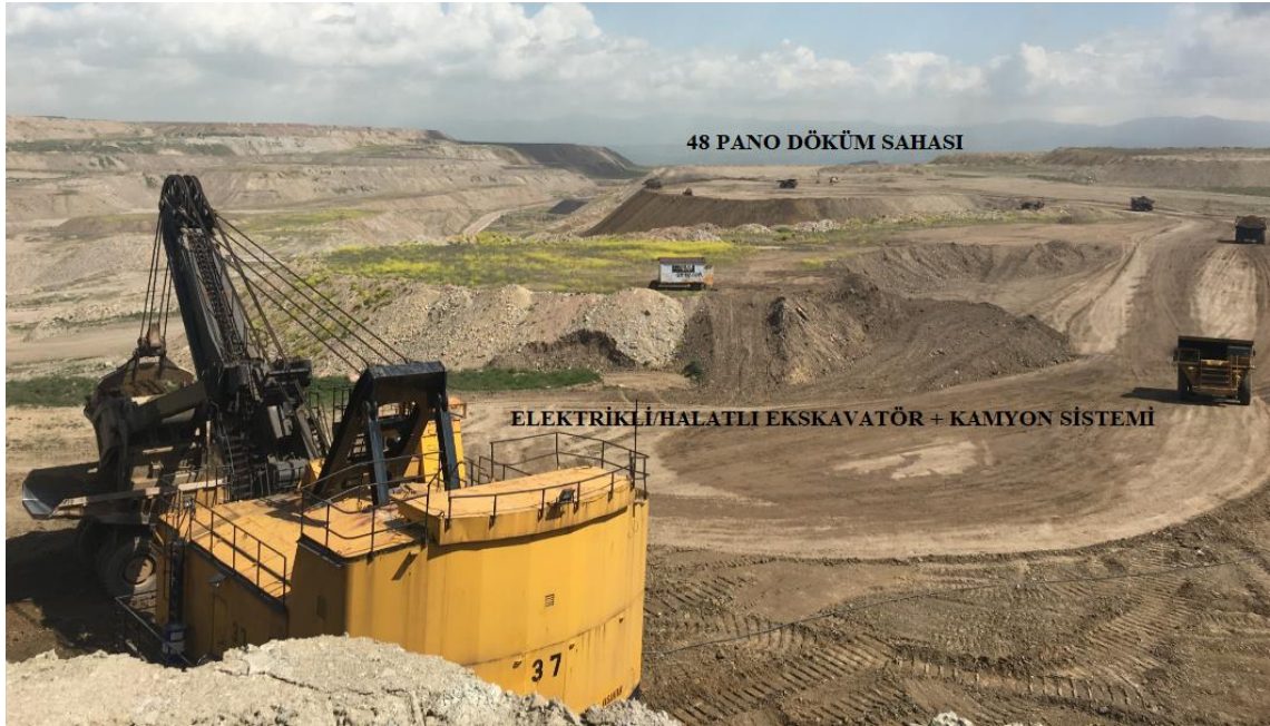
Şekil 3.1. 2017 Yılı 48 pano elektrikli/halatlı ekskavatör + kamyon çalışma sistemi ve harman görüntüsü.
