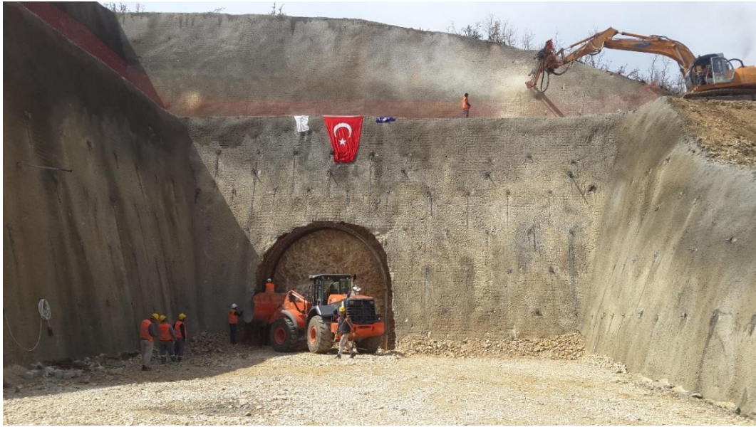
Şekil 5.23. Düzbağ giriş tüneli portal iksalarının kurulumu (Kahramanmaraş- Helete).
