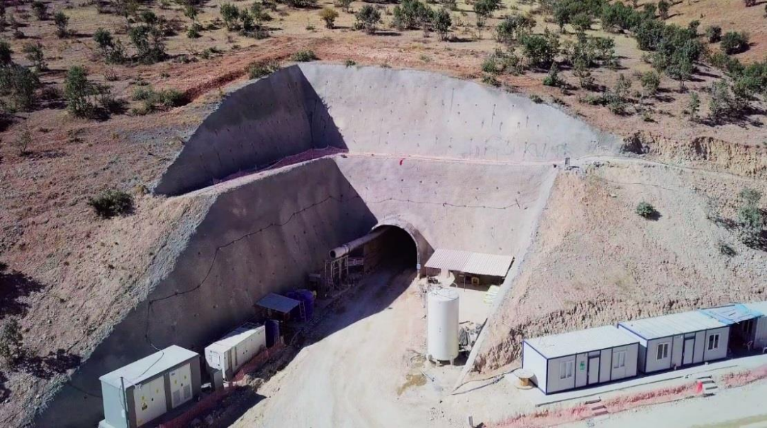
Şekil 5.27. Düzbağ çıkış tüneli portal kazısı.
