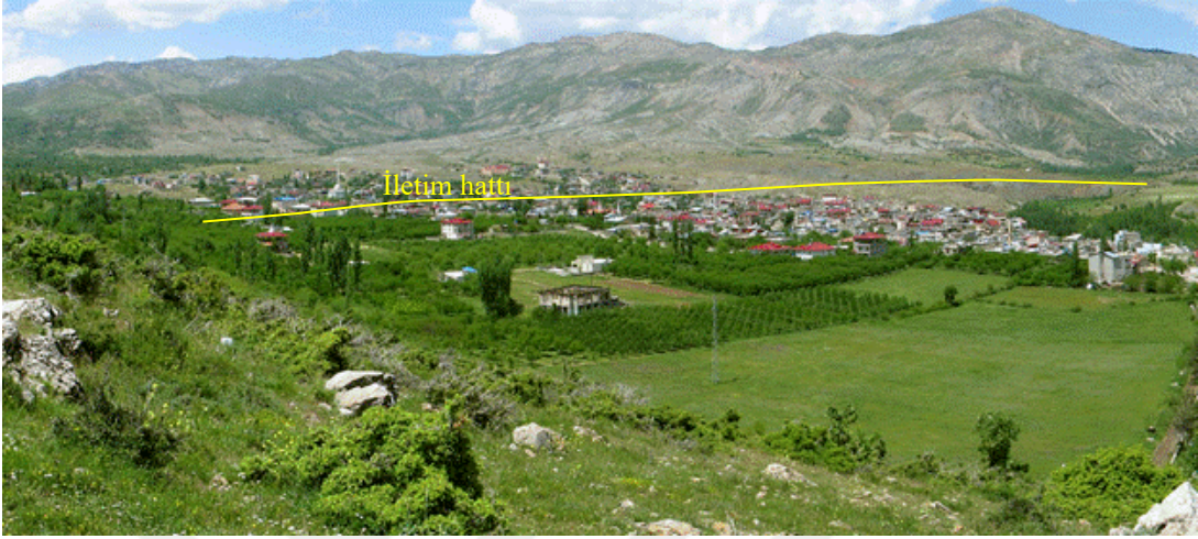
Şekil 5.3. Düzbağ yerleşim merkezi ve I. kısım iletim hattı (iletim hattı yaklaşık olarak sarı çizgi ile gösterilmiştir).
