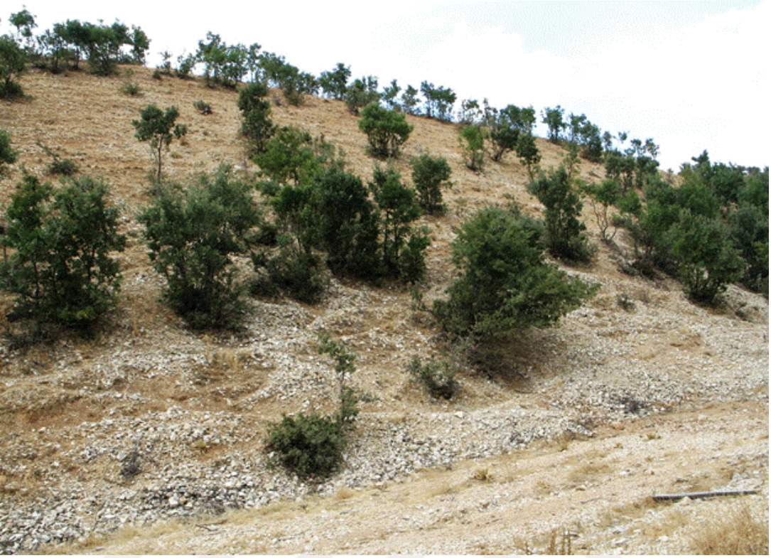
Şekil 5.26. Düzbağ tüneli (Kahramanmaraş- Helete) çıkış kazısının yapılacağı yamacın görünümü.
