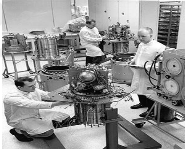
Şekil 2.4. Pratt&Whitney teknisyenlerinin apollo uzay aracının servis modülüne alkali yakıt pili hücrelerini ekleme görüntüsü (americanhistory, 2004).
