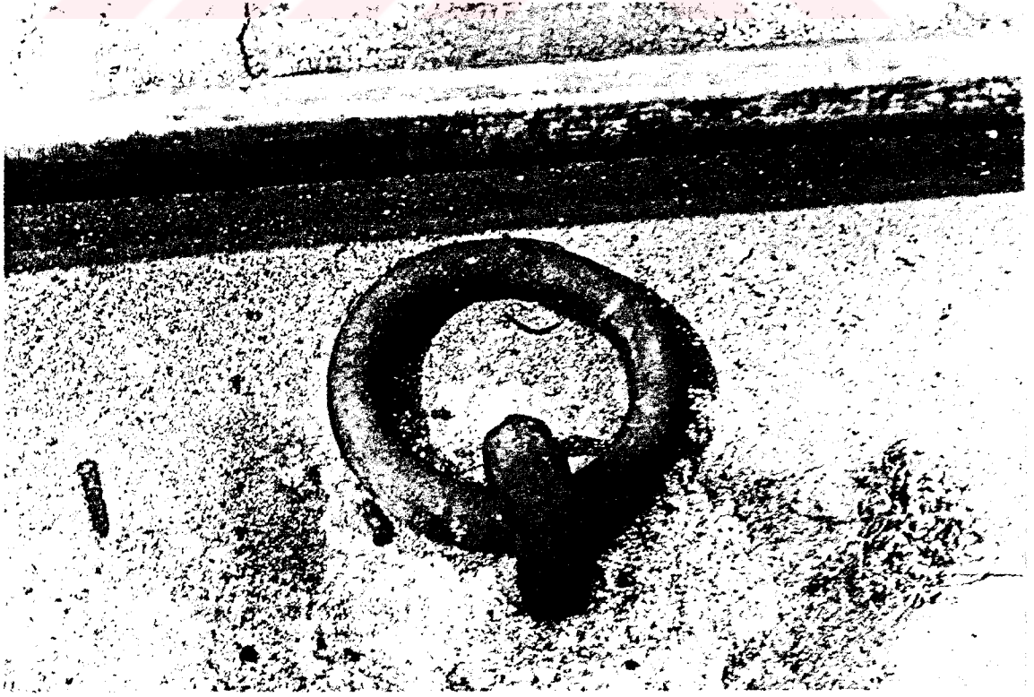
Şekil 3.46. 2 no'lu kuruhavuz etrafında zemindeki demir halkalardan bir örnek (1995).
