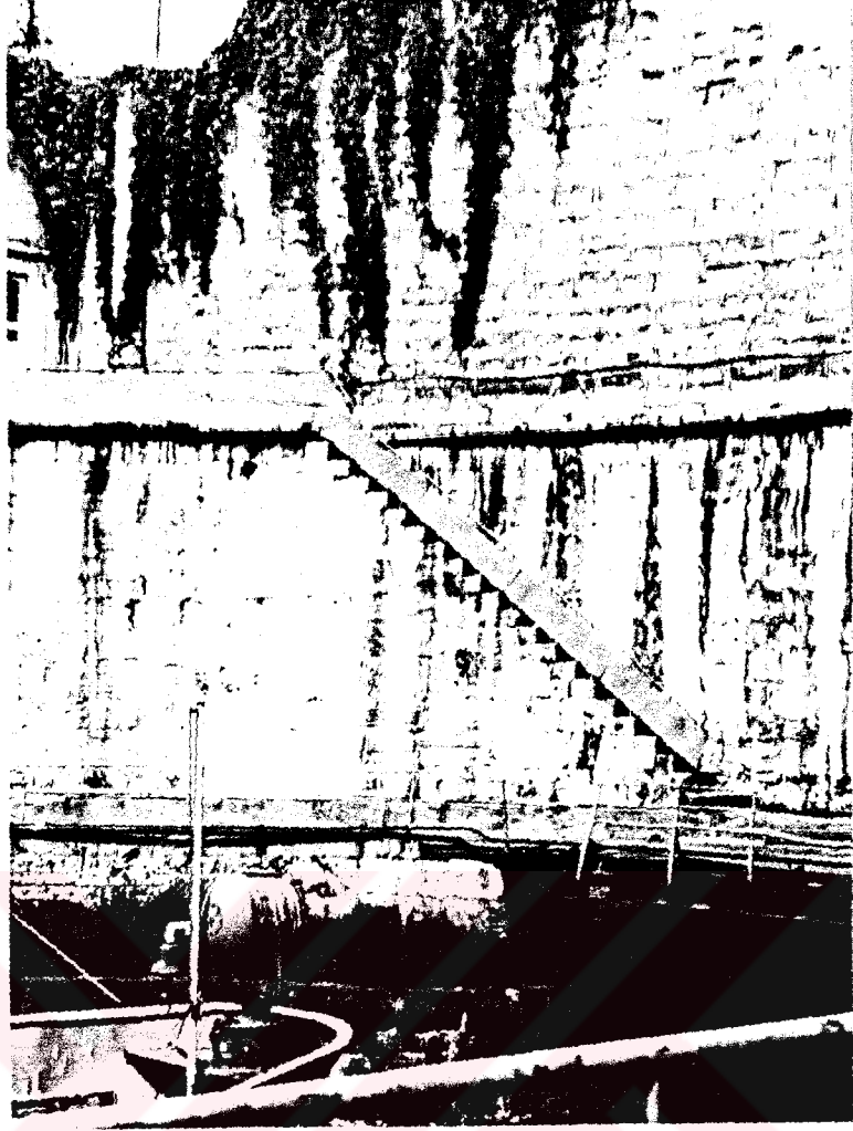
Şekil 3.45. 2 no'lu kuruhavuzun sonradan eklenen merdiveni (1995).
