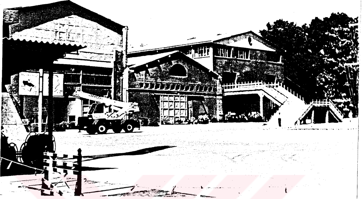
Şekil 4.22. Taşkızak Tersanesi'nde motor fabrikası ve yemekhane binası (1995).
