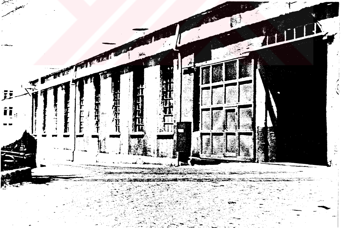
Şekil 4.21. Taşkızak Tersanesi'nde dökümhane girişi, yapı içinde halen kullanılan iki tane orijinal yer ocağı vardır (1995).
