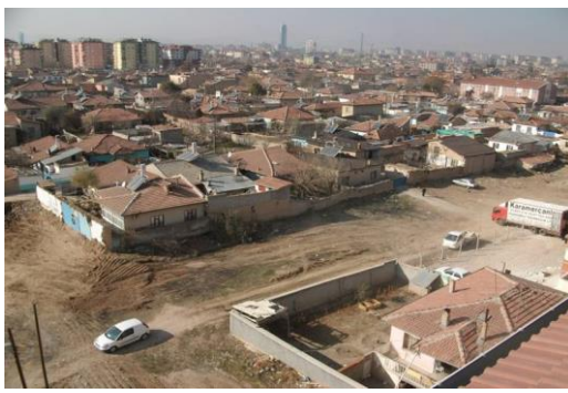
Yıkım yapılmadan önceki doku(Karatay Belediyesi arşivi)
