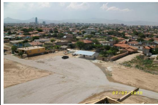
Yıkım yapılmadan önceki doku(Karatay Belediyesi arşivi)
