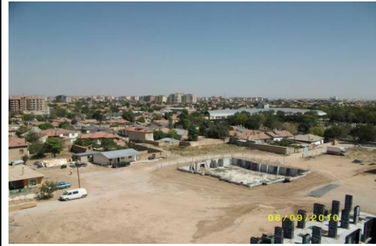
Yıkım yapılmadan önceki doku(Karatay Belediyesi arşivi)
