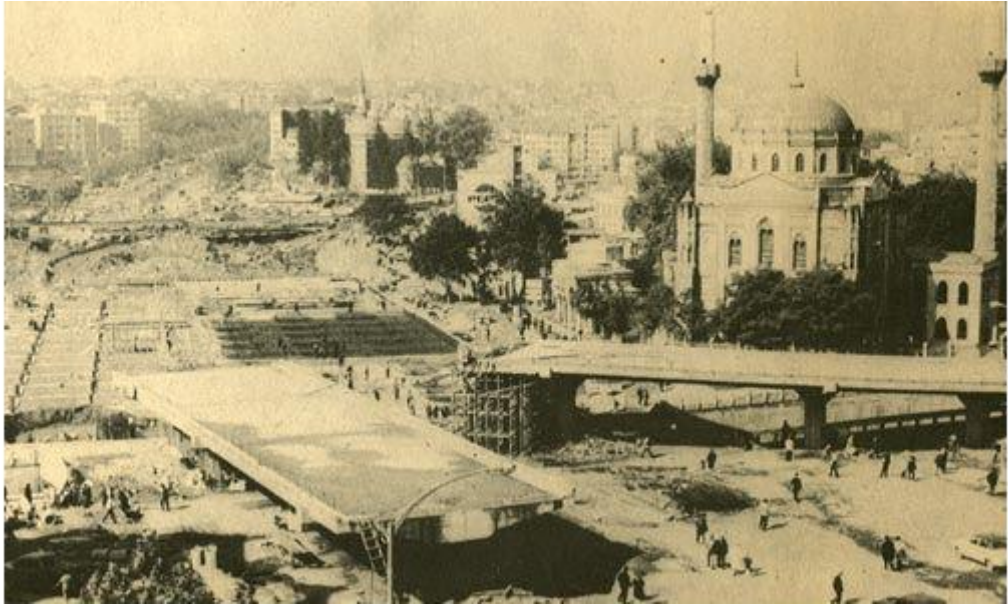
Şekil 3.3 Vatan Caddesi yapımında yıkılan yapılar(Aksaray Valide Sultan Cami Meydanı) (96)
