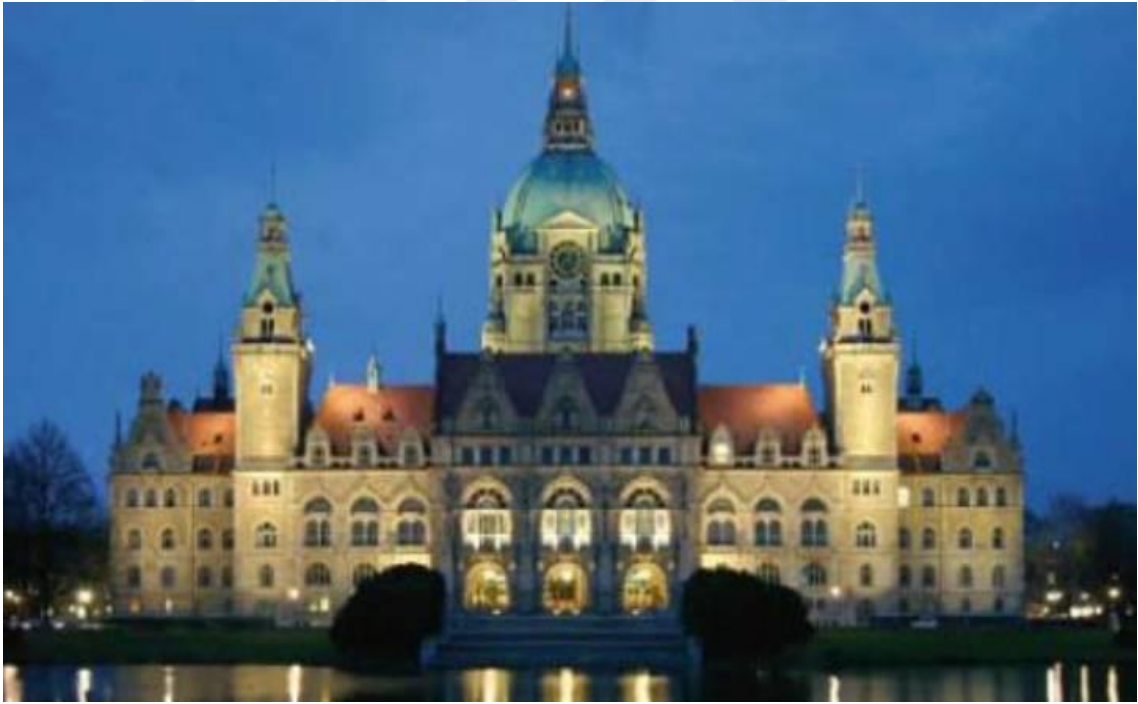
Şekil 3.9: Örnek dış cephe aydınlatma uygulaması (28) (32)
