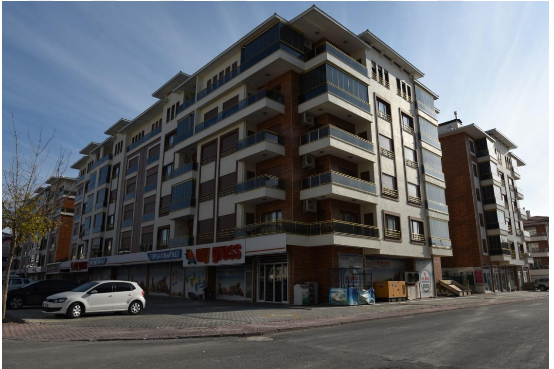
Çetnevir Sokak görünümü (Kuzey - Batı Cephesi)
