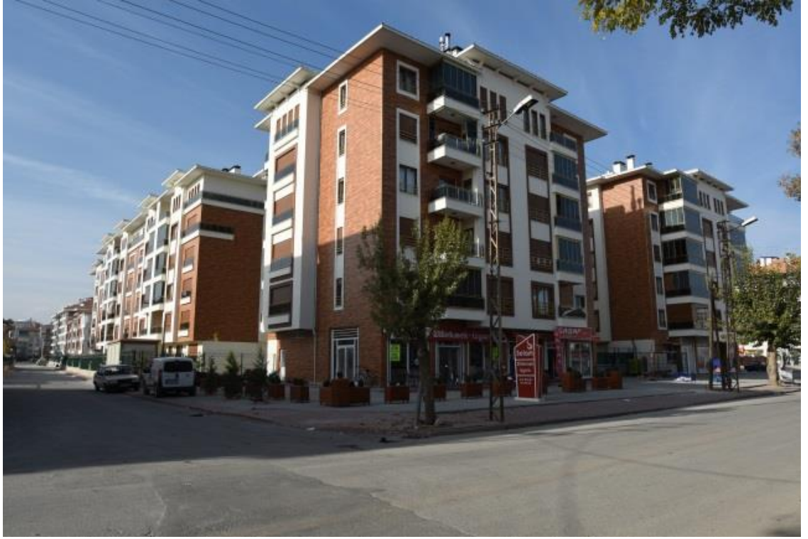
Araplar Caddesi'den görünümü (Güney - Doğu Cephesi)
