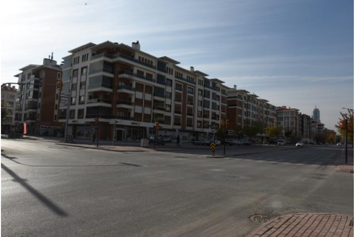
Ali Ulvi Caddesi'den görünümü (Kuzey - Doğu Cephesi)
