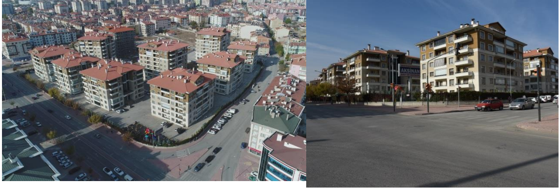
Şekil 4.15. Aksinan Toplu Konutların dronla çekilmiş hava ve yer fotoğrafları (59)
