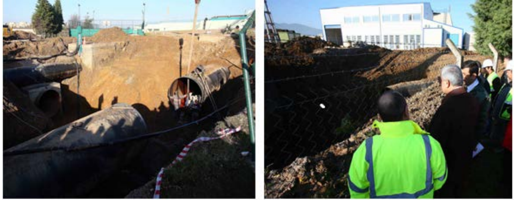
Şekil 1.3. Yuvacık HES Boru Hattı Çalışması Görüntüsü [12]
