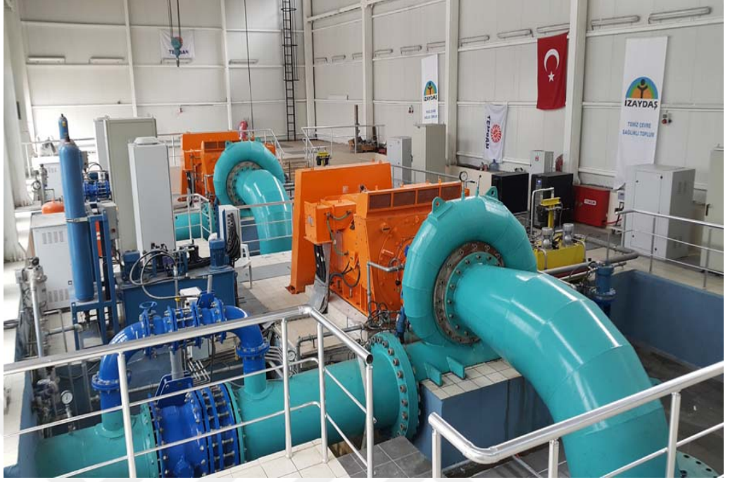
Şekil 1.6. Yuvacık HES'teki Türbinler [13]
