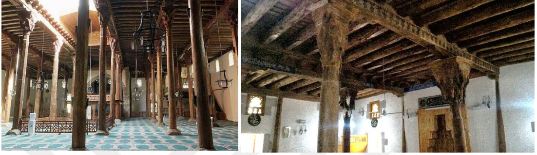
Şekil 4. 16: (sol) Eşrefoğlu Cami ve (sağ) Köşk Cami, harim alanlarındaki ahşap kirişli tavanları
