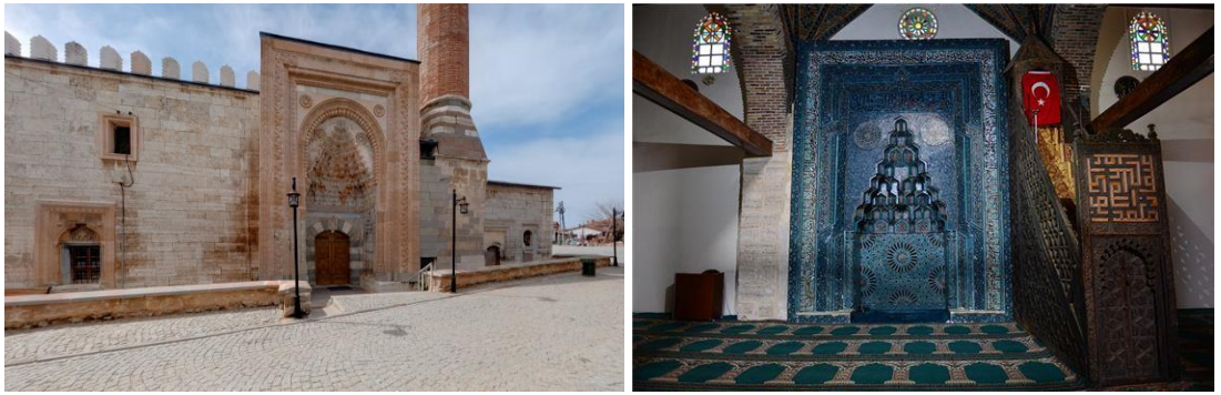
Şekil 4. 12: Eşrefoğlu Süleyman Bey Camii, (sol) Taç Kapısı ve (sağ) Mihrabı
