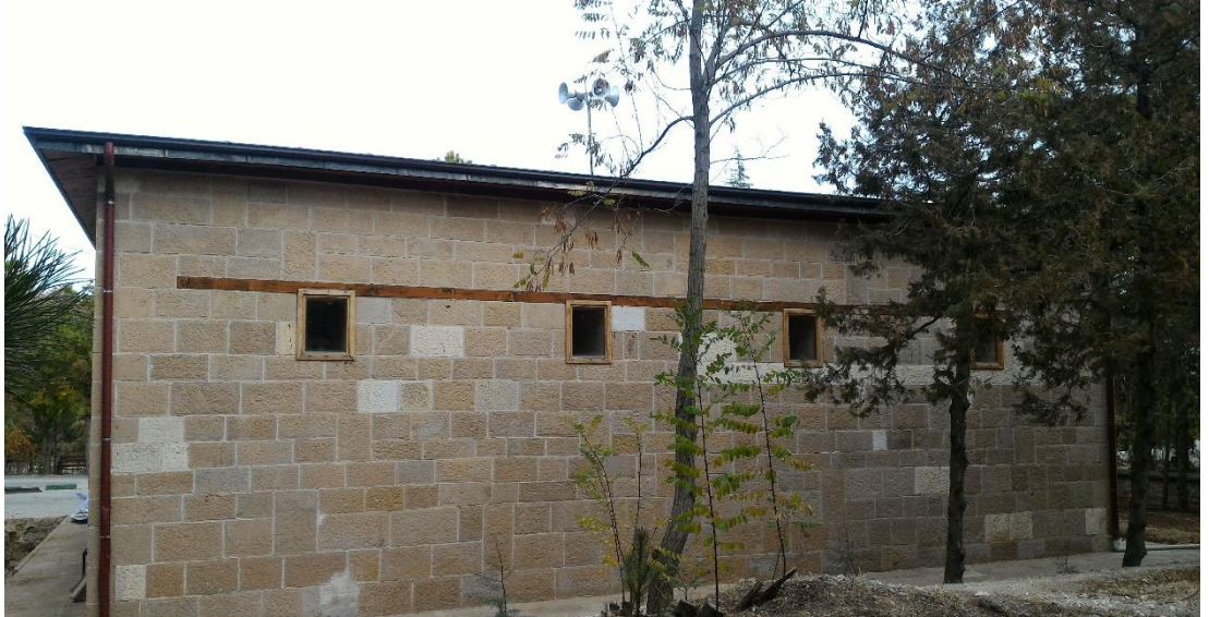
44: Köşk Camii, Batı Cephesi
