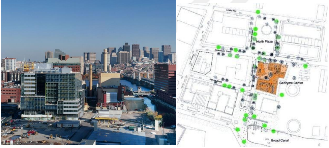
Şekil 2. 15: Genzyme Merkezi yeşil binası Cambridge/Massachusetts/US [URL19], (sağ) Vaziyet Planı, [URL20]
