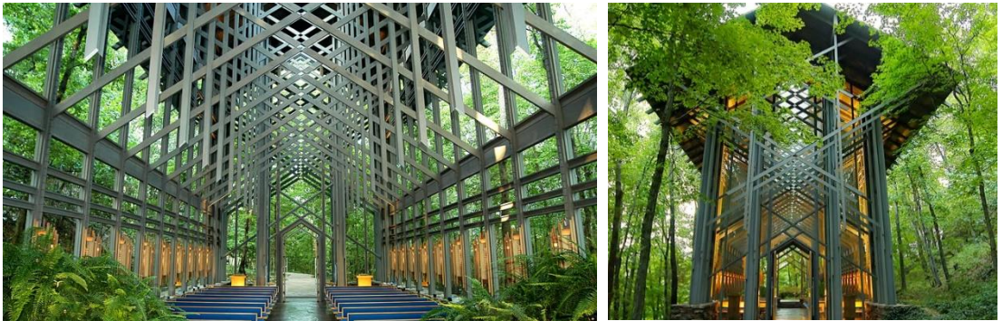
Şekil 2. 7: Thorncrown Şapeli, Arkansas/USA (1980), [URL7]
