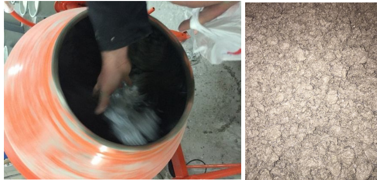
Şekil 3.5 Betonyerle beton karışım hazırlanması
