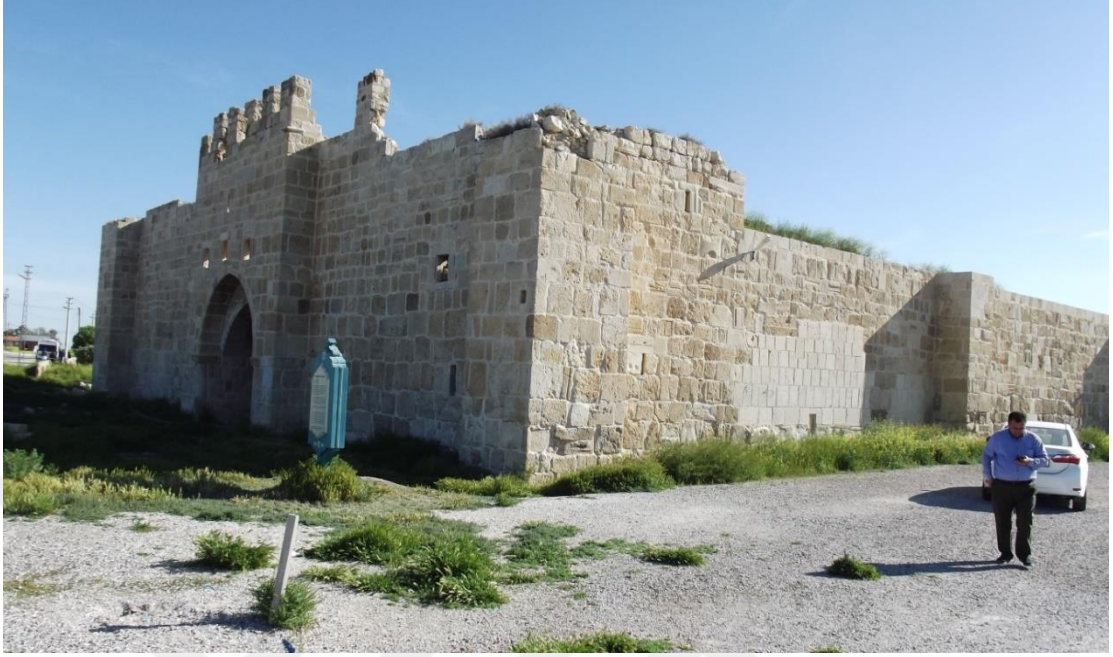
Şekil 3.7. Obruk Han'ın güneybatı görünümü
