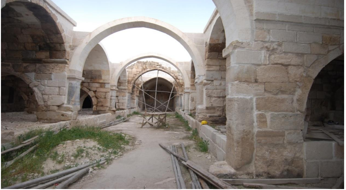
Şekil 3.20. Obruk Han kemer onarımı
