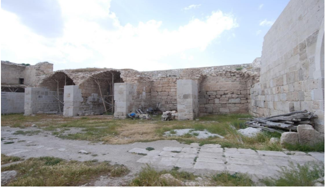
Şekil 3.16. Obruk Han avlu kuzey cephesi
