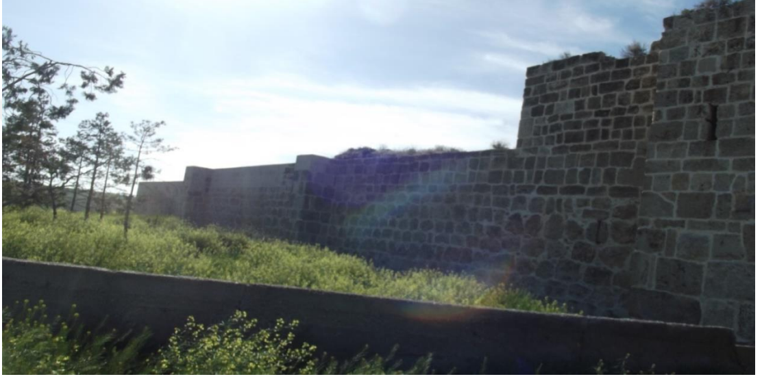
Şekil 3.10. Obruk Han'ın kuzey cephesinden görünümü
