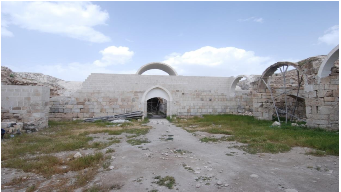
Şekil 3.19. Obruk Han avlu doğu cephesi bölme duvarı
