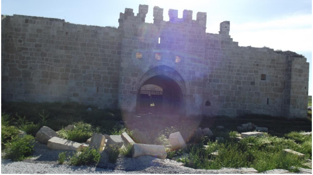
Şekil 3.4. Obruk Han'ın batı cephesinden görünümü
