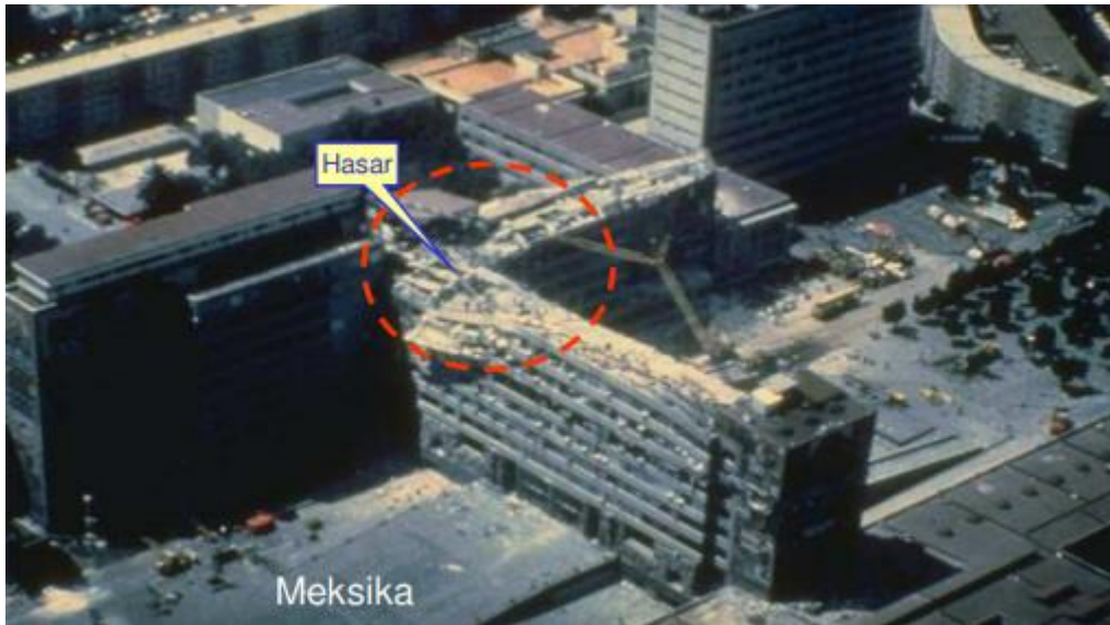
Şekil 3. 10. Bozuk Geometriden Dolayı Hasar Almış Yapı [15]
