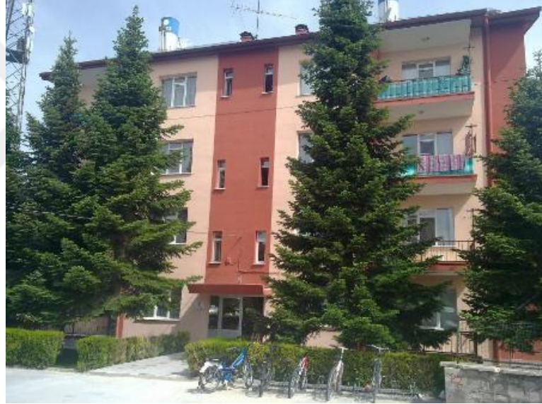
Şekil 4.48 DSİ Meram Kampüs Alanı Katlı Lojmanlar E Blok [40]
