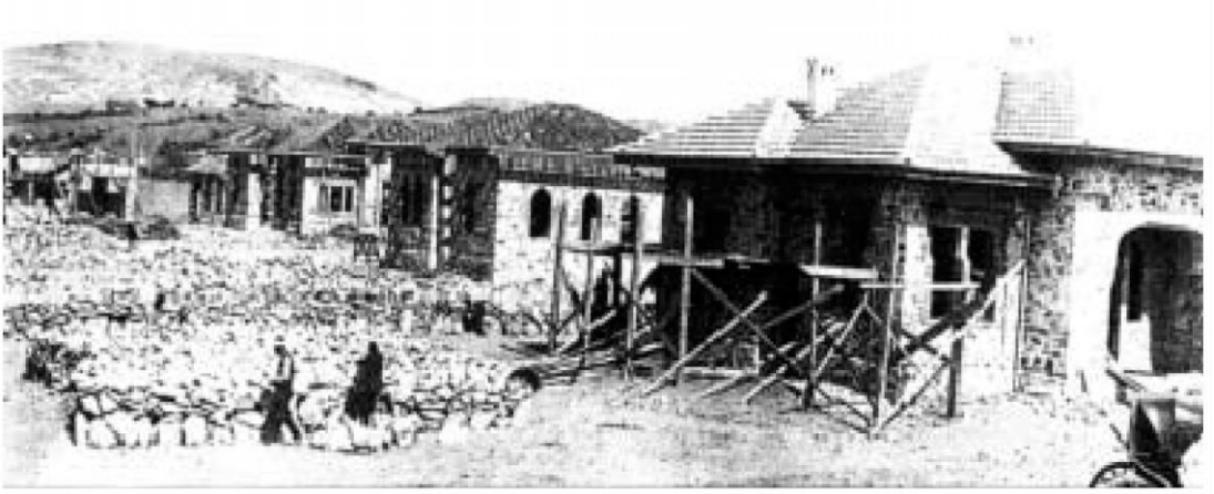
Şekil 3.1 Yapım Aşamasında Yenişehir Memur Evleri [21]
