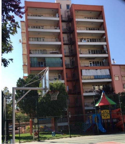
Şekil 3.31 Karayolları Konevi Lojmanları D Blok
