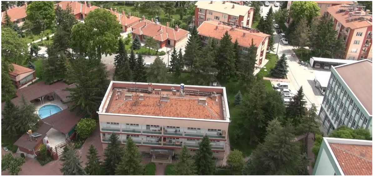
Şekil 4.34 DSİ Meram Kampüs Alanı Katlı Lojmanlar A Blok [40]
