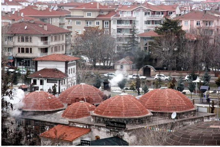
Şekil 6.27. Ali Paşa Hamamı ve Eski Vali Konağı Kaynak: İl Kültür ve Turizm Müdürlüğü Arşivi
