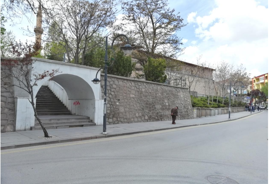
Şekil 6.21. Ulu Cami Doğu Duvarı
