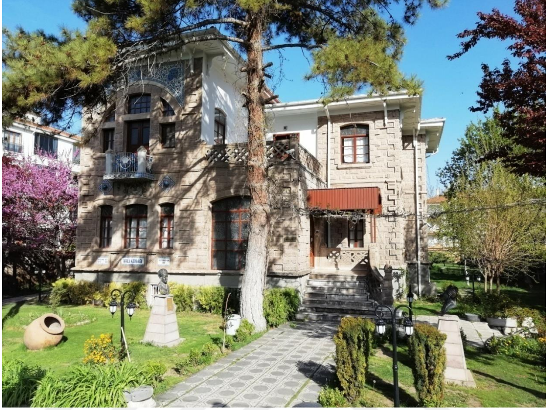
Şekil 6.39. Eski Vali Konağı
