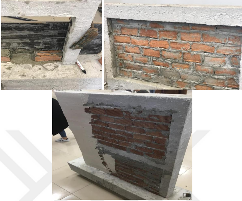
Şekil 3.10. Çelik tel kafes ile güçlendirilmiş tuğla dolgu duvarlı numunenin üretim fotoğrafları
