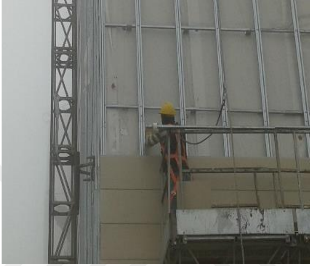
Şekil 3.5. Yapılan Çalışmada M-J-L Ankraj Uygulamaları
