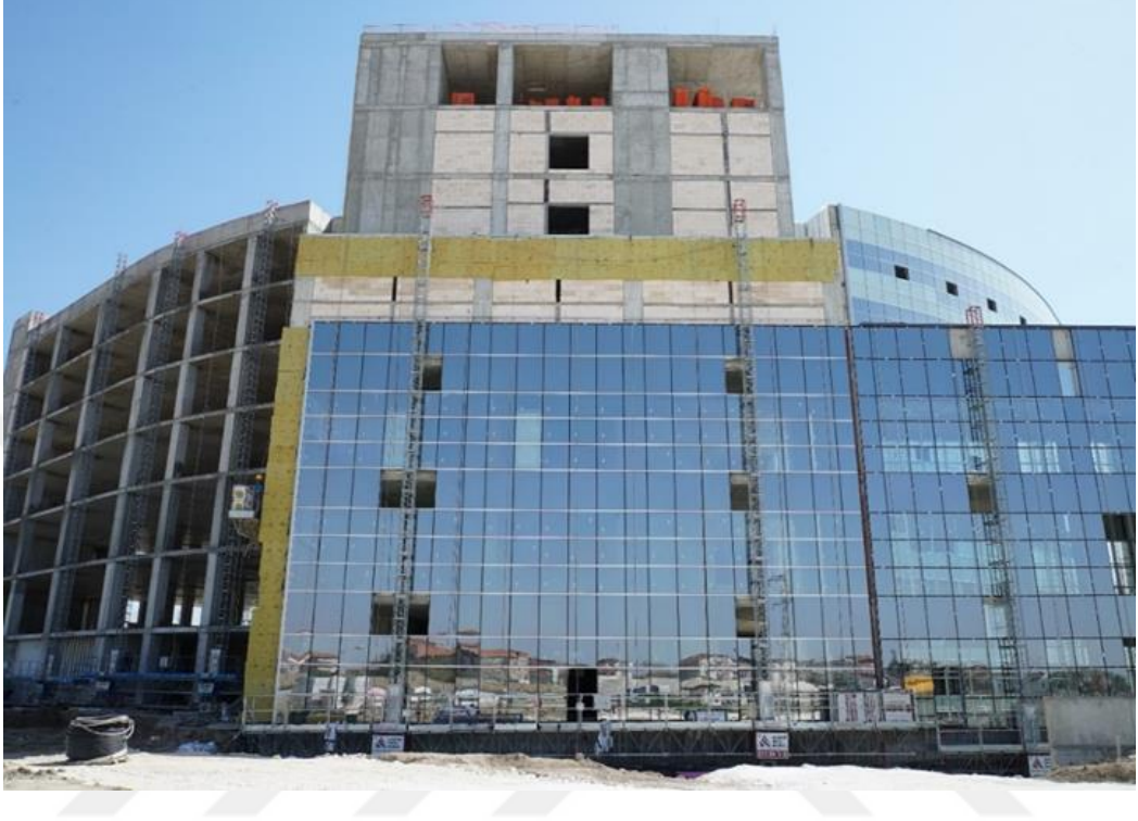
Şekil 3.7.Cam Giydirme Cephe Uygulaması
