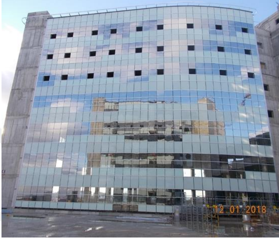
Şekil 3.6. Yapılan Çalışmada Cam Giydirme Cephe Uygulaması
