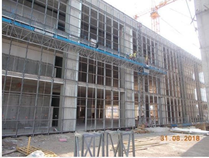
Şekil 3.10. Yapılan Çalışmada Cam Giydirme Cephe Alüminyum Profilleri
