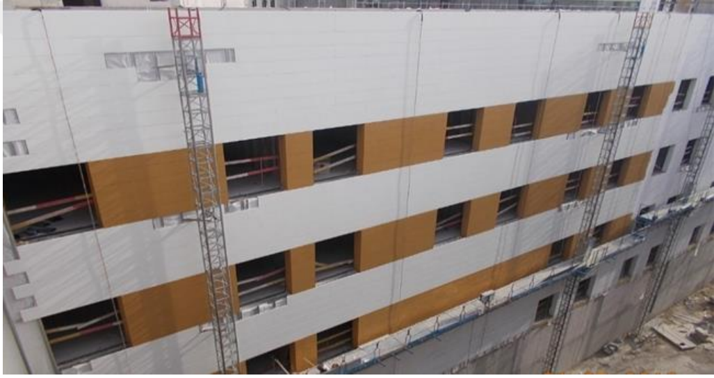
Şekil 3.1. Fibercement Cephe Kaplama İmalatı
