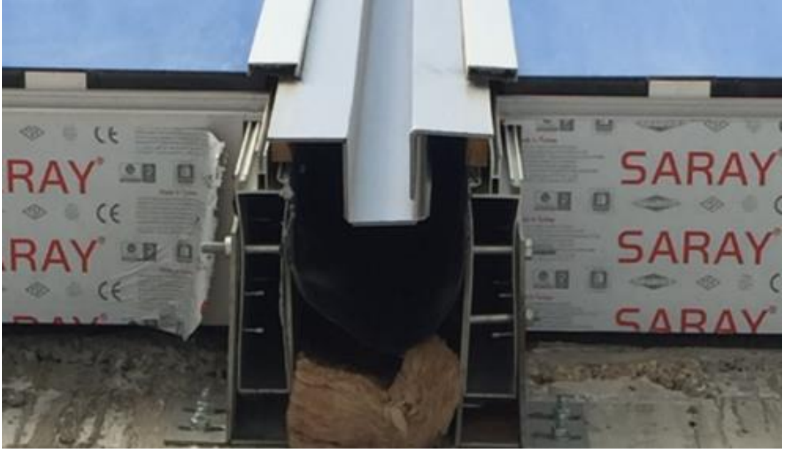
Şekil 3.11. Cam Giydirme Cephe Birleşim Detayı
