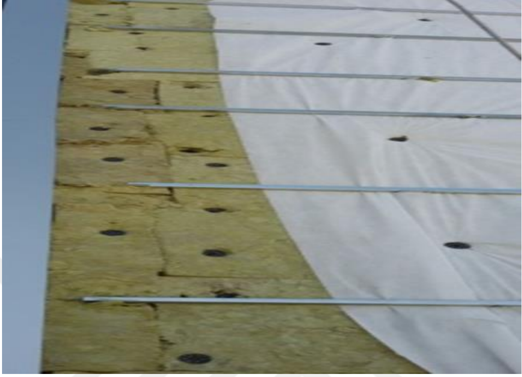
Şekil 3.4. Yapılan Çalışmada Nem Bariyeri Uygulaması
