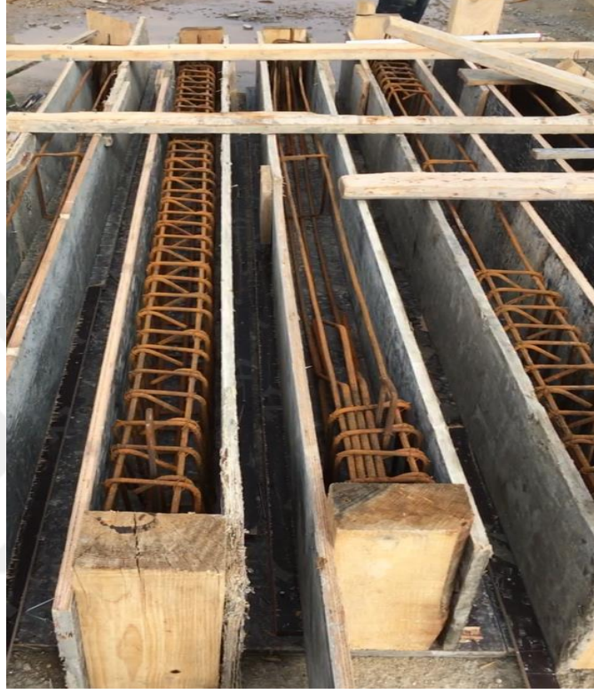
Şekil 4.6. Beton döküme hazır olan numune kirişler
