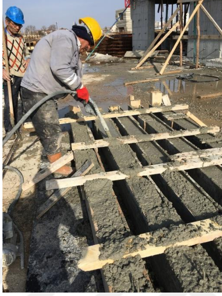
Şekil 4.7. Beton döküm aşaması
