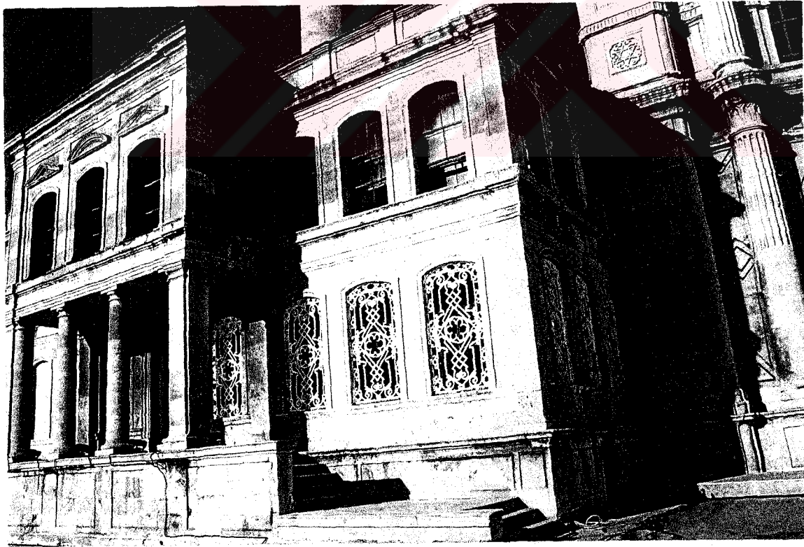
Şekil 3.25. Ortaköy Camii batı cephesinde hünkar girişi
