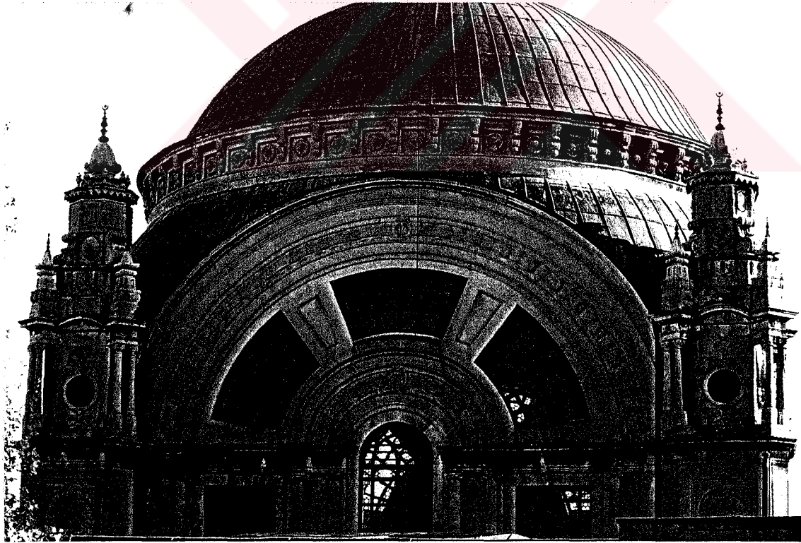
Şekil 3.33. Dolmabahçe Camii cephesinde üst bölümden detay
