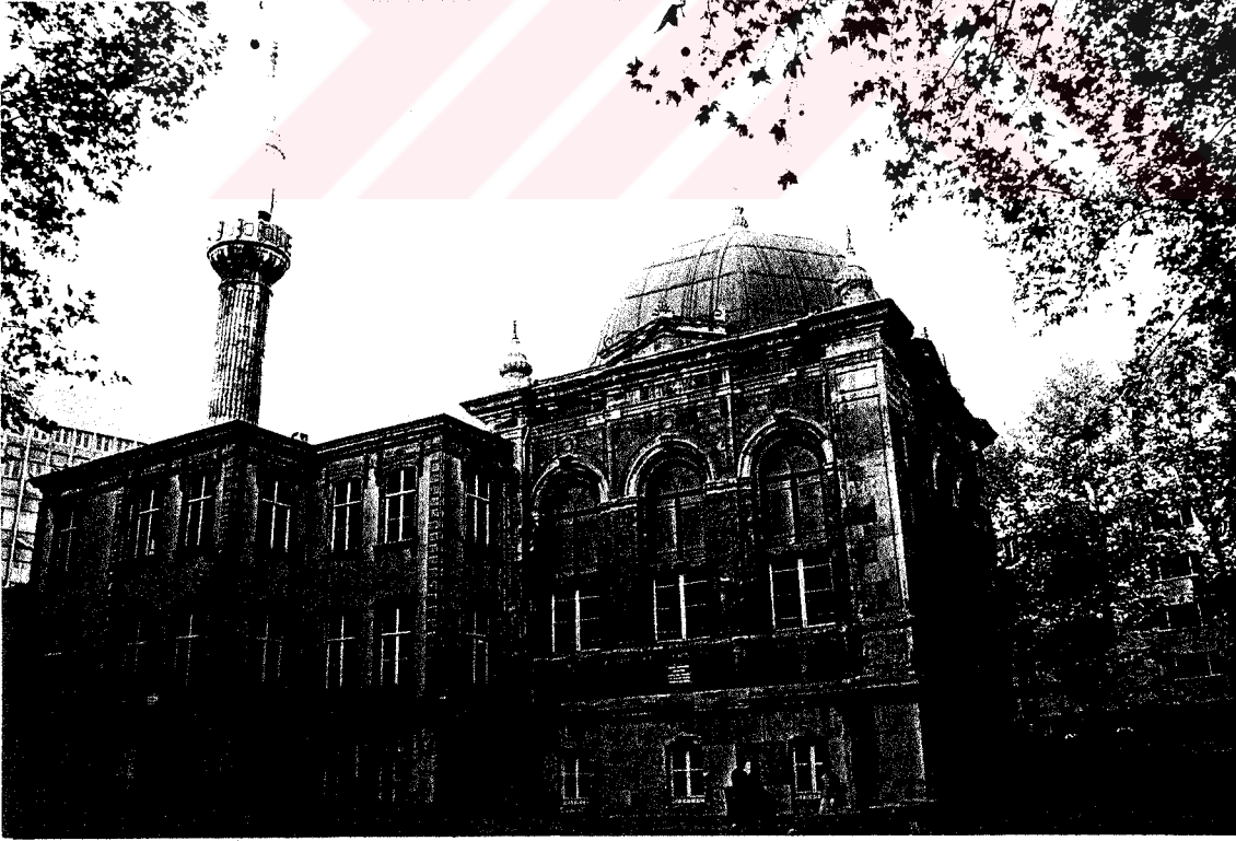
Şekil 3.35. Teşvikiye Camii batı cephesi
