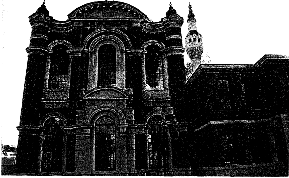
Şekil 5.30. Sa'dâbâd Camii doğu cephesi
