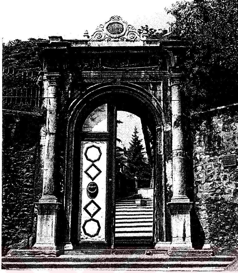
Şekil 3.72. Hırka-i Şerif Camii avlu batı kapısı
