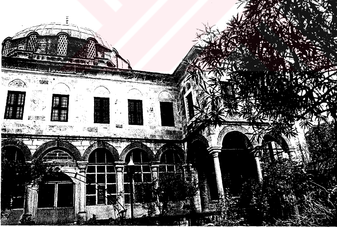
Şekil 5.10. Beylerbeyi Camii kuzey cephesi
