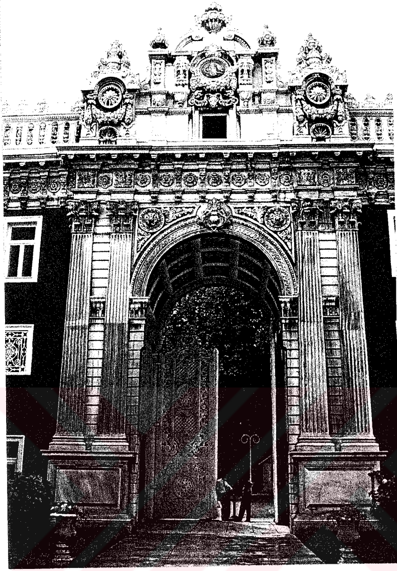
Şekil 5.18. Dolmabahçe Sarayı Hazine Kapısı iç görünümü
