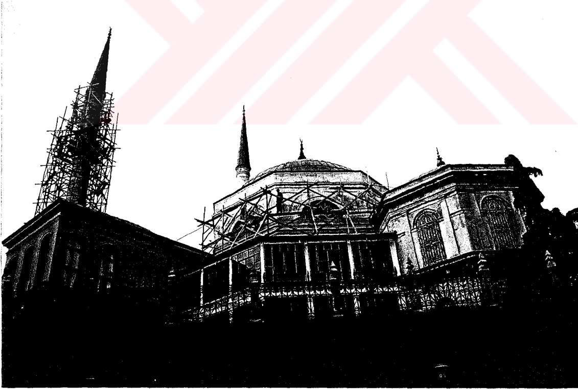
Şekil 3.21. Hırka-i Şerif Camii batı cephesinden görünüm
