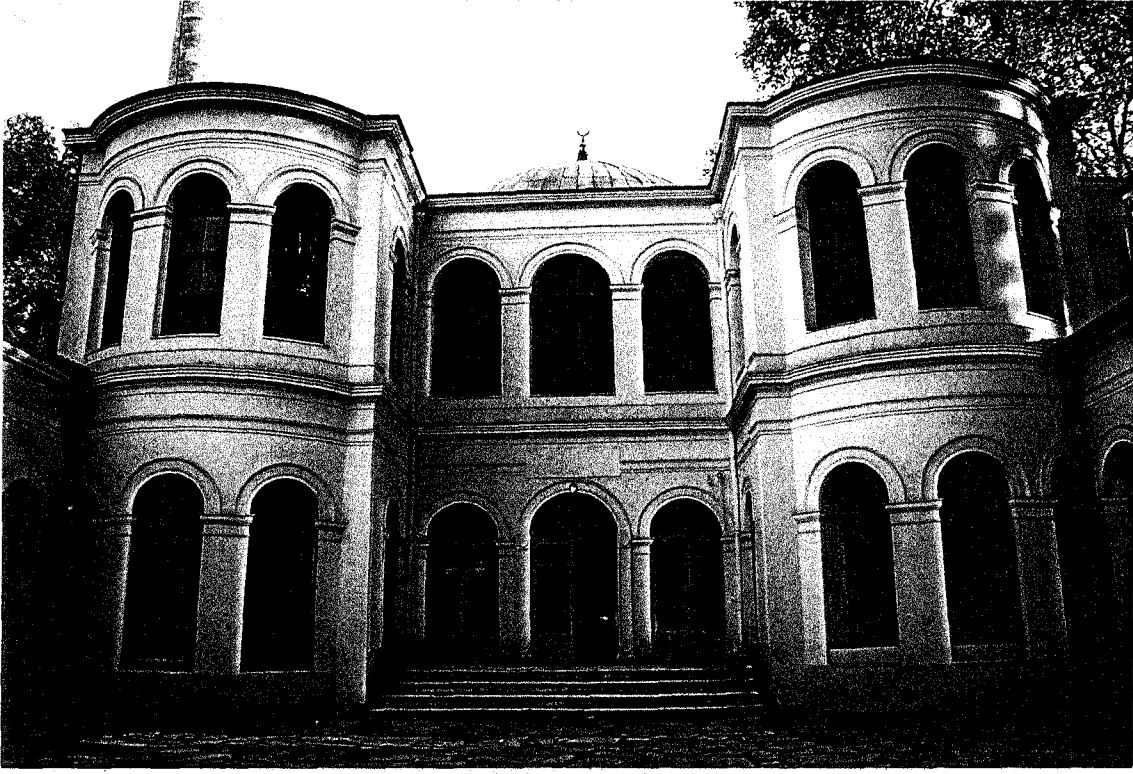
Şekil 3.12. Küçük Mecidiye Camii hünkar kasrı kuzey cephesi
