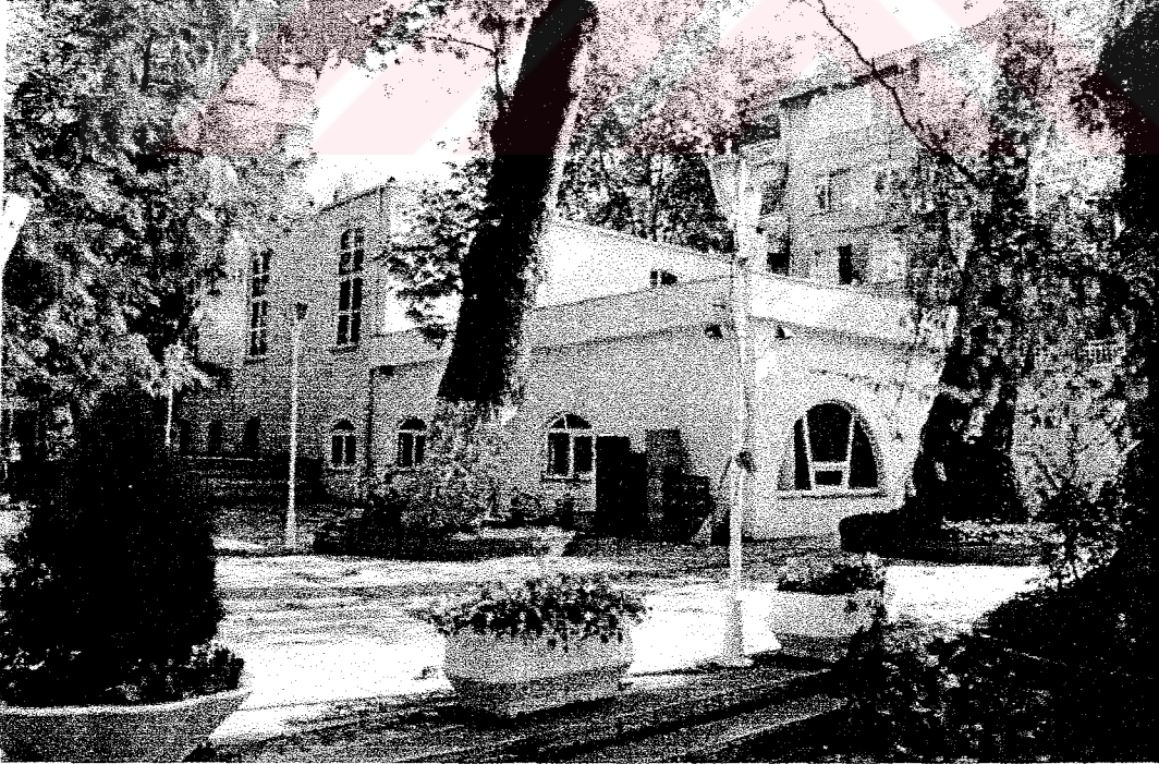
Şekil 3.31 KRO, bahçeden görünüm, İskele Sokak tarafı (Yazar Arşivi)
