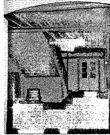
Şekil 3.12 bodrum kat merdiven holü
