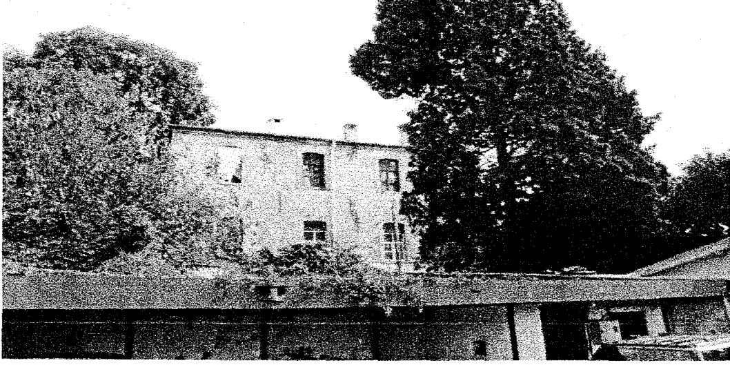
Şekil 3.45 Çengelköy Rum Okulu, Otomobil Bakım Servisi' nden görünüş, batı cephesi (Yazar arşivi)
