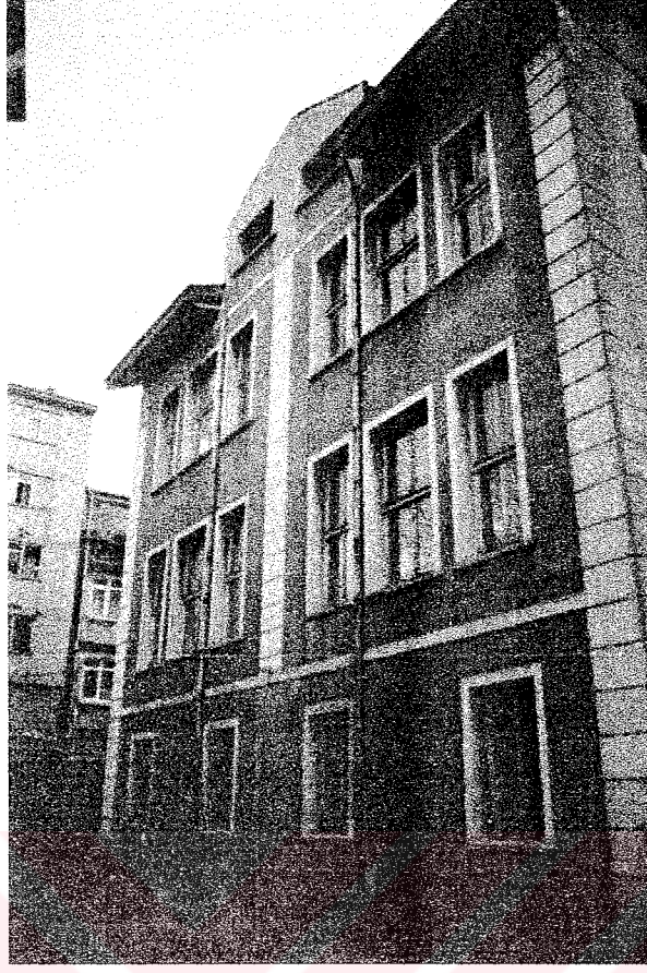
Şekil 3.68 AHEO, Doğu cephesi, bahçeden görünüm (Yazar arşivi)
