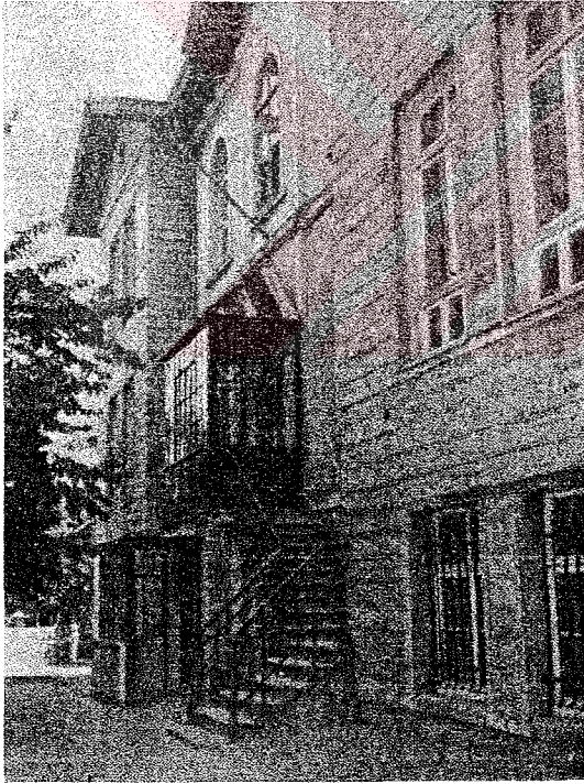
Şekil 3.66 AHEO, bina girişi, yenilemeden önce (Komisyon 1964, s.187)
