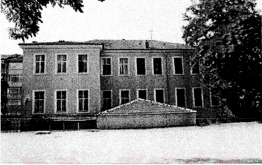
Şekil 3.18 Kadıköy Rum İlkokulu, arka cephe (Yazar arşivi)
