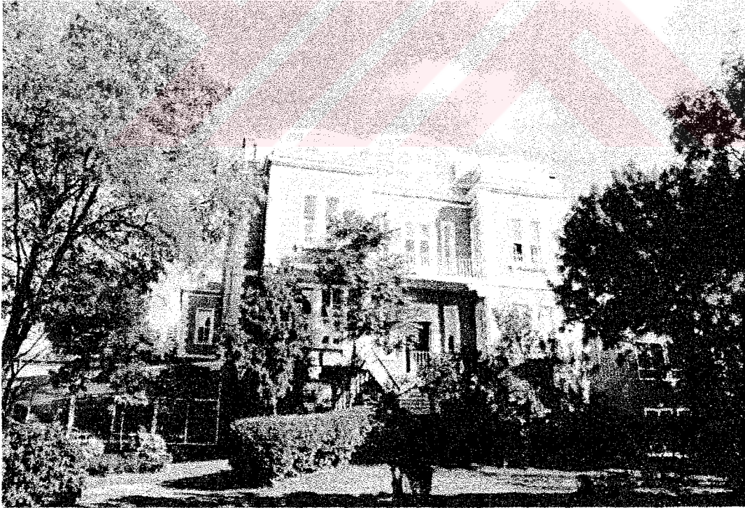
Şekil 4.113 ÜAKL, Bowker Hall, güneybatı cephesi (Yazar arşivi)
