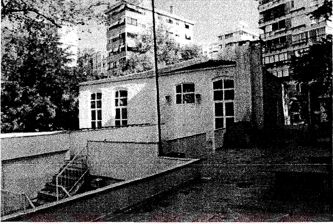
Şekil 3.30 KRO, güneydoğu tarafından görünüş (Yazar arşivi)
