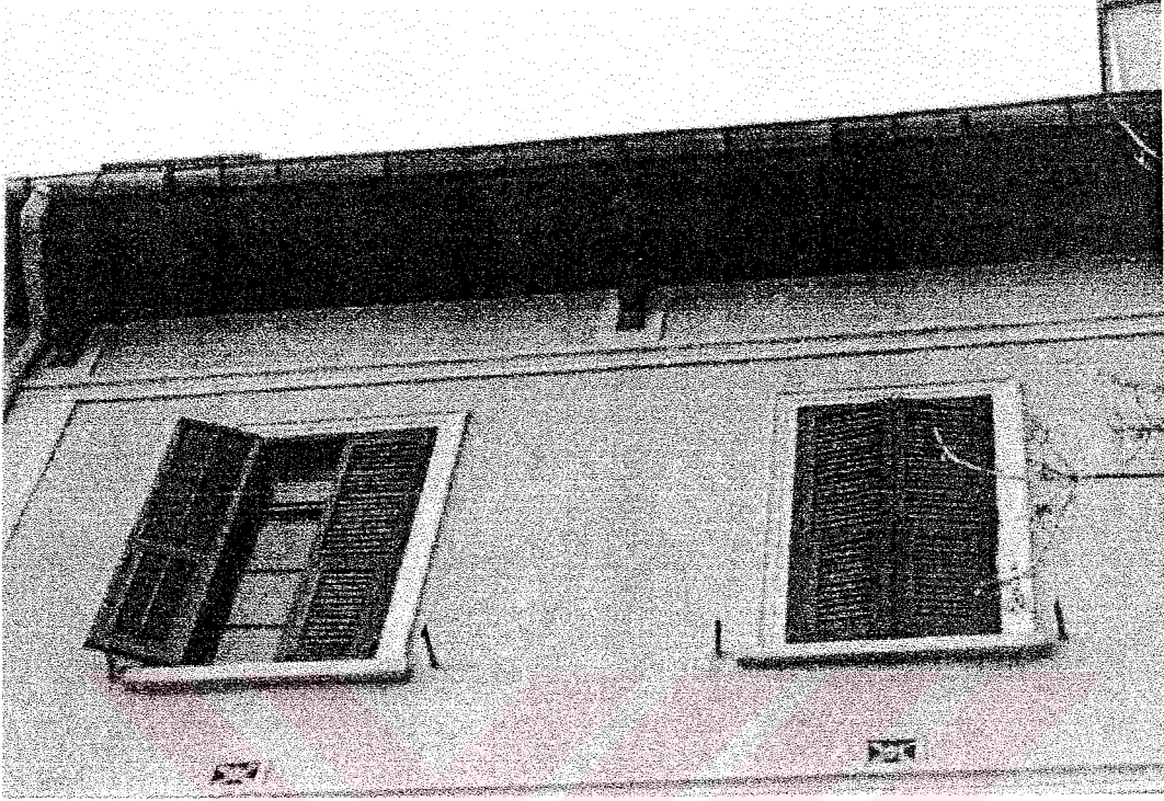
Şekil 4.13 St. Joseph Lisesi, kuzeydoğu kanadı, doğu cephesinden detay (Yazar arşivi)
