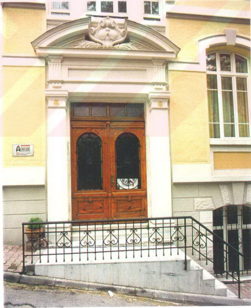
Şekil 5.41 St. Georg Hastahanesi eski giriş kapısı
