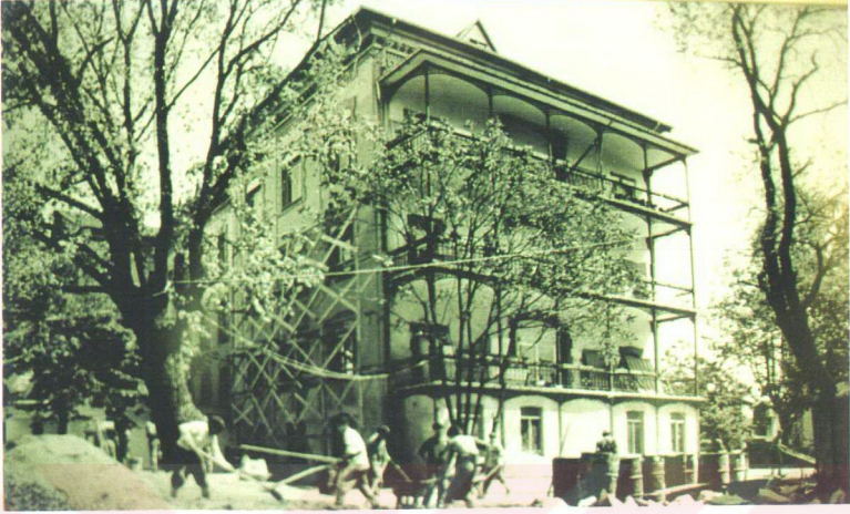
Şekil 5.30 Alman Hastahanesi , ana bina güney cephesinin eski hâli
