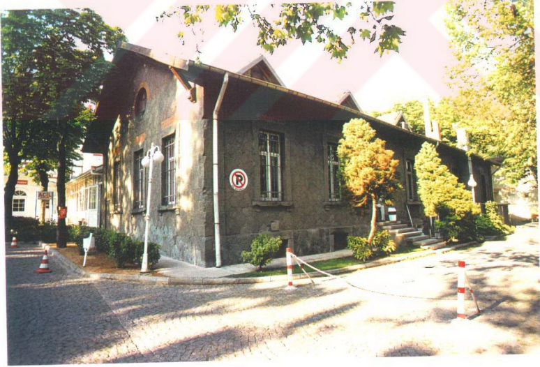
Şekil 5.52 Taş kaplı binanın doğu ve güney cepheleri
