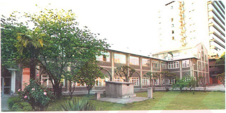
Şekil 5.7 İç bahçeden batıya bakış
