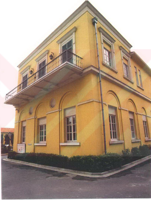
Şekil 5.23 Ana bina ve sonradan eklenen iki katlı bölüm
