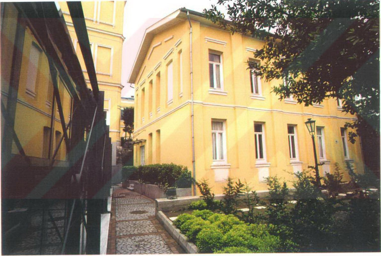
Şekil 5.18 Üst bahçe ile alt bahçe arasında yer alan iki katlı yapının kuzey cephesi
