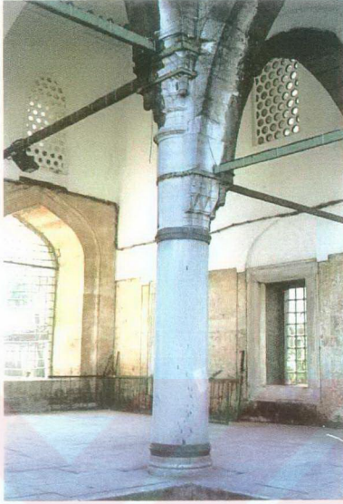
Şekil 2.47 Topkapı Kara Ahmed Paşa Camii Son Cemaat Yeri Revakı Köşe Sütunu
