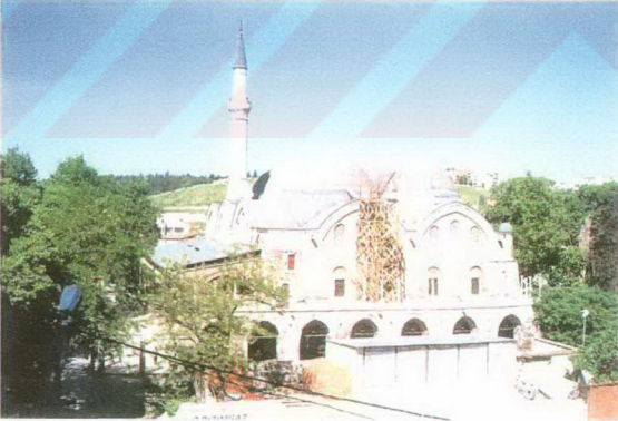
Şekil 2.72 Piyale Paşa Camii Genel Görünüş
