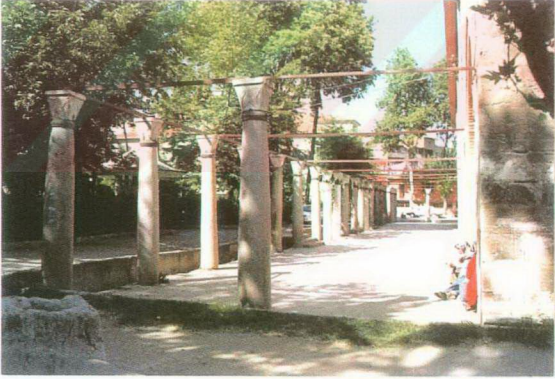
Şekil 2.76 Piyale Paşa Camii Dış Revak Sütunları
