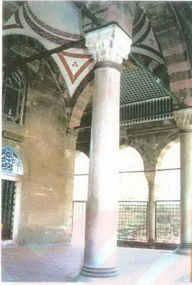
Şekil 2.98 Kılıç Ali Paşa Camii Son Cemaat Yeri Revak Sütunu
