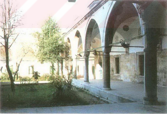
Şekil 2.45 Topkapı Kara Ahmed Paşa Camii Avlu Yan Revakı
