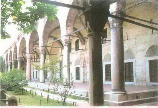
Şekil 2.63 Edirnekapı Mihrimah Sultan Camii Son Cemaat Yeri Revakı
