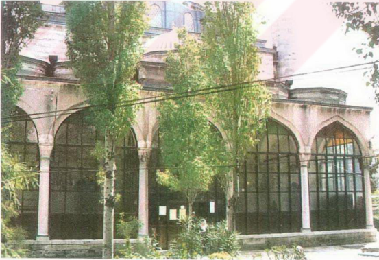
Şekil 2.20 Silivrikapı Hadım İbrahim Paşa Camii Son Cemaat Yeri
