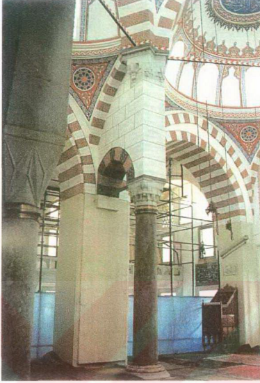
Şekil 2.101 Toptaşı Atik Valide Camii Ana Taşıyıcı Paye ve Sütun
