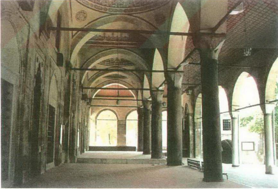
Şekil 2.110 Mesih Mehmed Paşa Camii Son Cemaat Yeri ve Dış Revak
