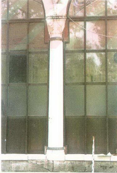
Şekil 2.23 Silivrikapı Hadım Ibrahim Paşa Camii Son Cemaat Yeri Revak Sütunu
