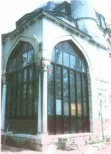
Şekil 2.22 Silivrikapı Hadım Ibrahim Paşa Camii Son Cemaat Yeri Revak Sütunu
