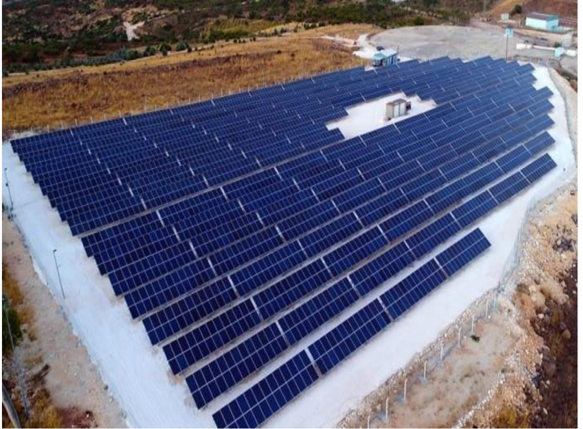
Şekil 2.2. Kurulumu tamamlanmış olan santralin üstten görünümü
