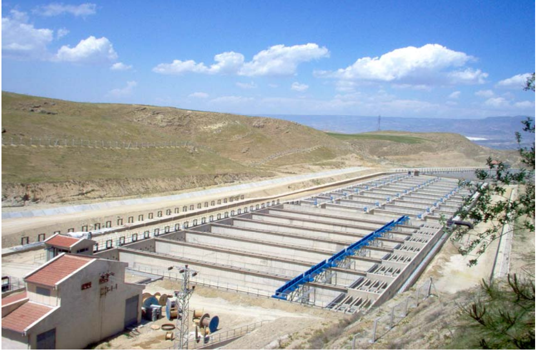
Şekil 2.2 Denizli (Merkez) Atıksu Arıtma Tesisi ön çökteltme havuzları genel görünümü
