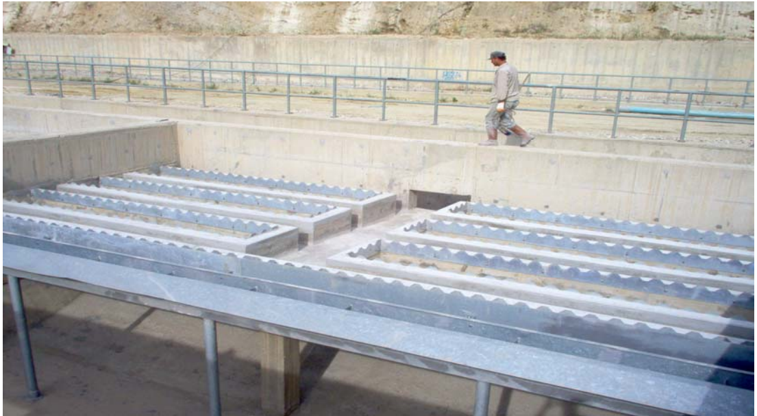
Şekil 2.15 Denizli (merkez) Atıksu Arıtma Tesisi ön çökelme havuz çıkış yapısı
