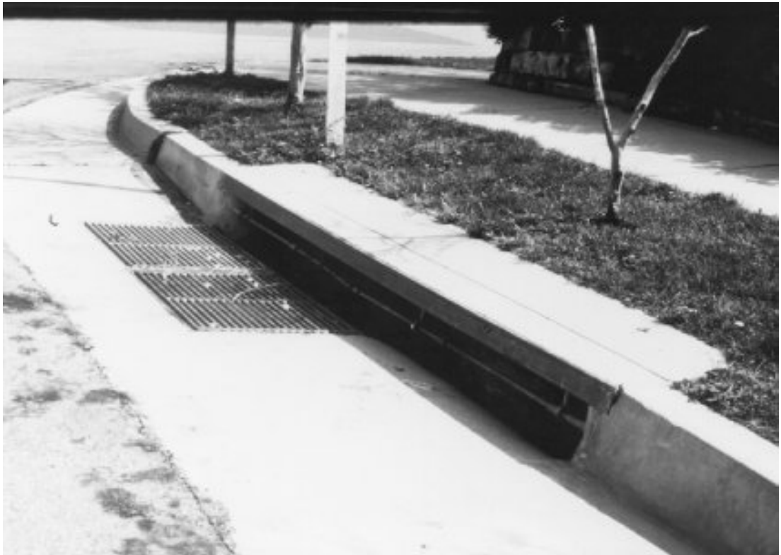
Şekil 2.9 : Izgaralı Girişin Sistemin Mansap Tarafında Bulunduğu Birleşik Giriş [4]
