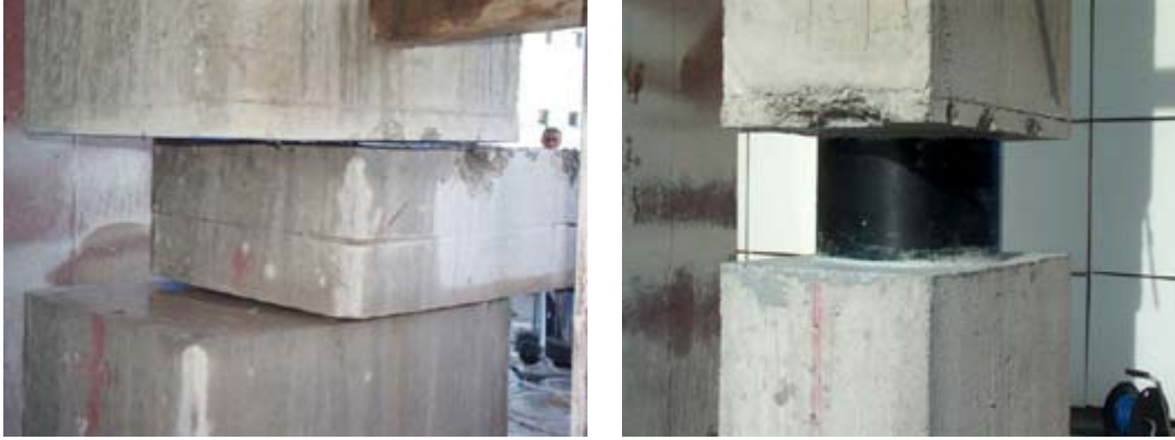
Şekil 7.15: Kolonların elmas tel ile kesilip izolatörün yerleştirilmesi ([35]'den alınmıştır.)
