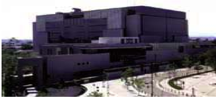
Şekil 7.9: C-1 binası ([30]'dan alınmıştır.)
