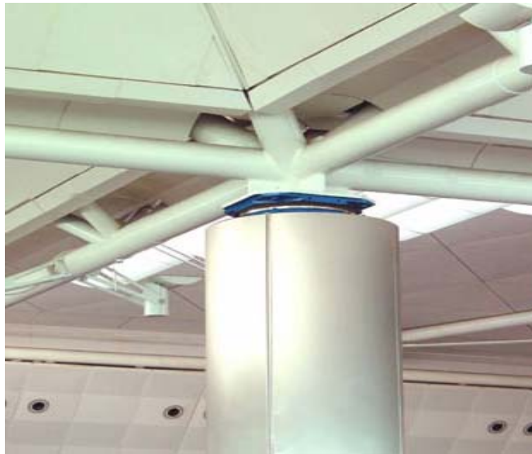
Şekil 7.19: Atatürk havalimanında kullanılan bir sürtülmeli sarkaç mesnet ([36]'dan alınmıştır.)
