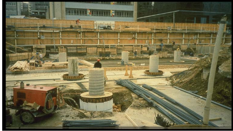
Şekil 7.11: Wellington merkezi polis istasyonu temelindeki 20m uzunluğunda esnek kazıklar ([30]'dan alınmıştır.)
