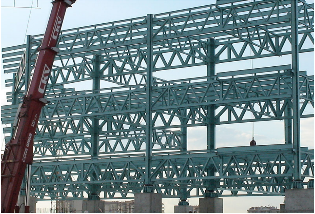
Şekil 1.3 : Ankara'da Kafes Kirişli Bir Yapı İnşaatı
