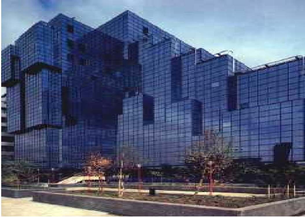
Şekil 1.1 : Londra’da Çelik Taşıyıcı Sistemli Bir Ofis Binası
