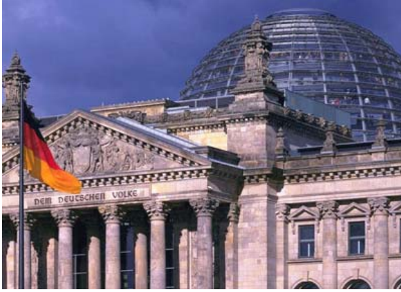
Şekil 4.2.2.2.22. Alman Parlamento Binası, Görünüş, Norman Foster, 2001
