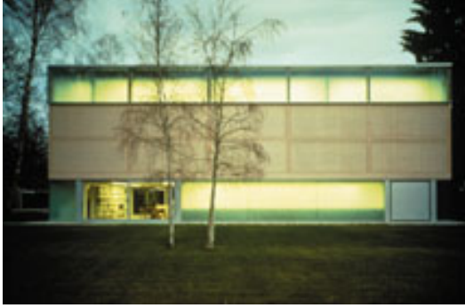
Şekil 3.1.3.3. Goetz Collection, Görünüş, Herzog & De Meuron, 1992
