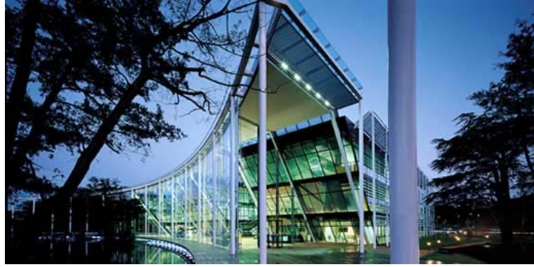
Şekil 4.2.2.2.20. Elektronik Sanatlar Merkezi, Görünüş, Norman Foster, 2000
