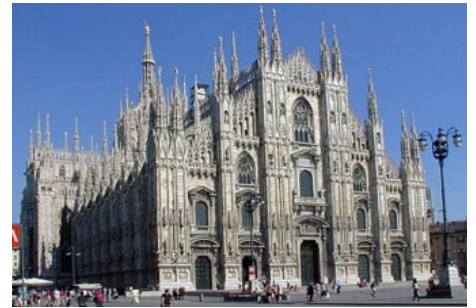
Şekil 5.32: Milano Dome, Milano.
