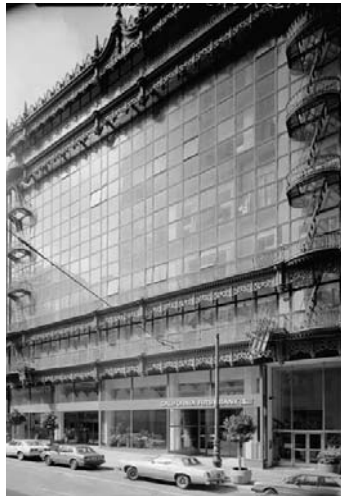
Şekil 5.45: Hallidie Binası, 1918, San Francisco, California, Willis Polk, (web 9).
