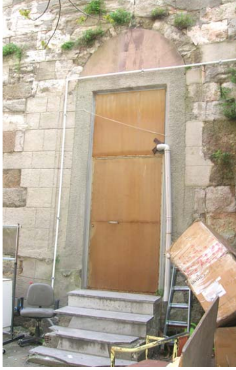
Şekil D.58: Mahmud Paşa Hamamı; soyunmalık-bahçe kapısı
