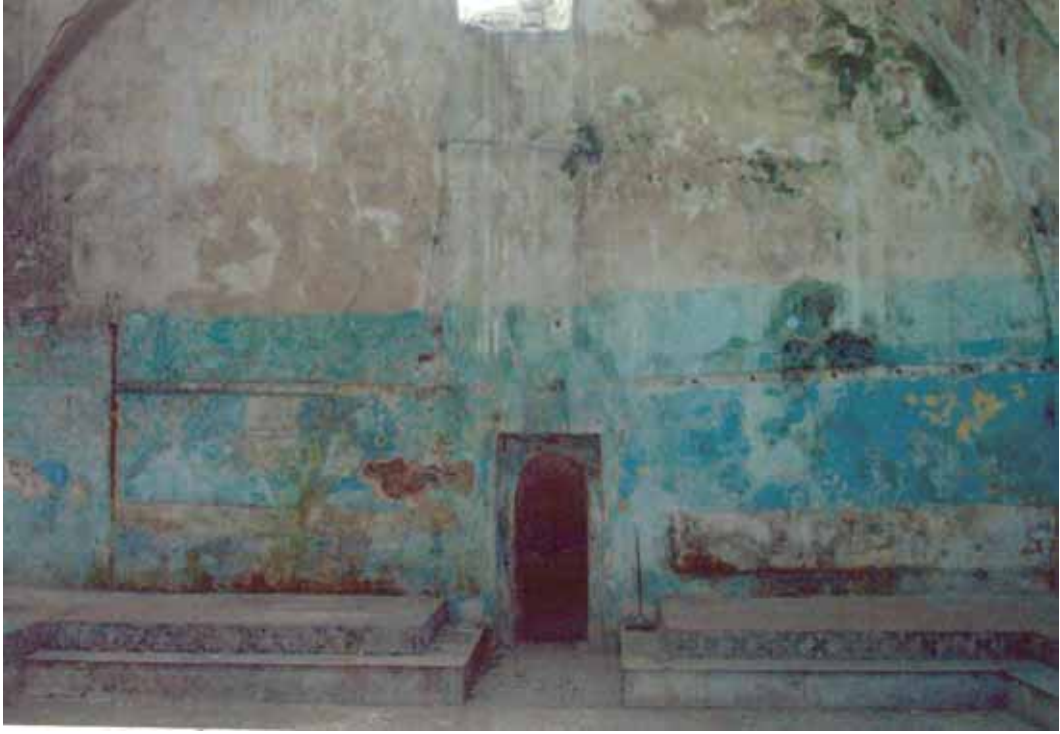
Şekil C.2-20: Kadınlar Bölümü; soyunmalık kuzeydoğu duvarı
