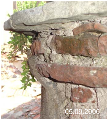
Şekil C.7-2: Kasnak duvarları; çimentolu sıvanın döküldüğü bölgeler
