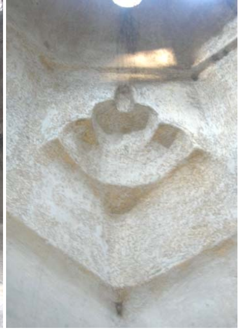
Şekil C.5-40: Z04a; kademeli tromp
