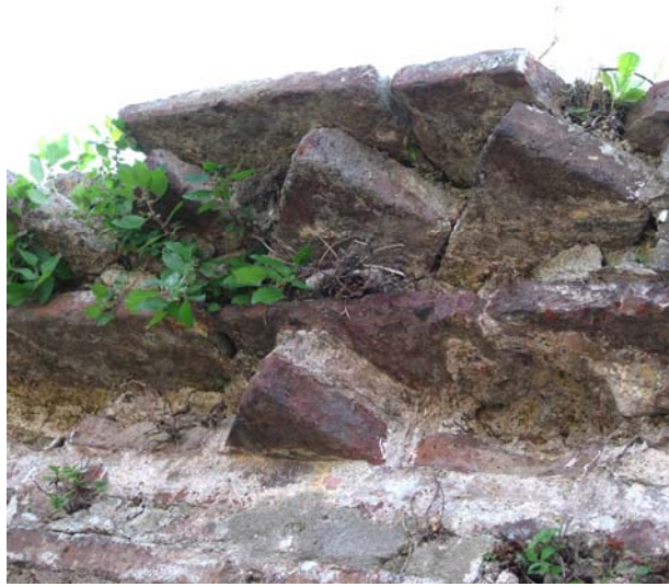
Şekil C.5-135: Kirpi saçak; kasnak kuzey duvarı (korunmuş örgü)
