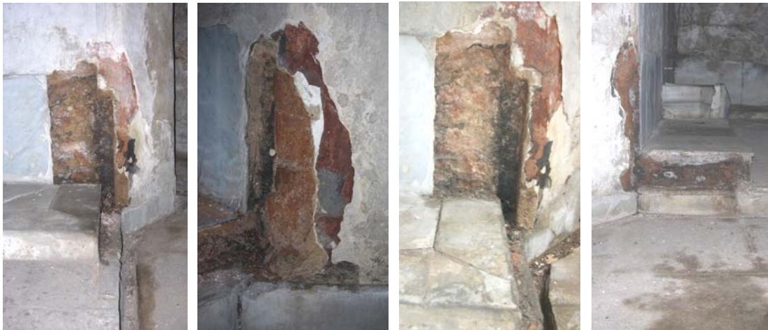
Şekil C.7-19: Sökülen koltuk taşlarına ait izler (06.12.2006)
