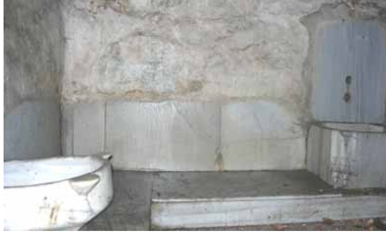
Şekil C.3-201: Z05-2; kuzeybatı duvarı ve seki
