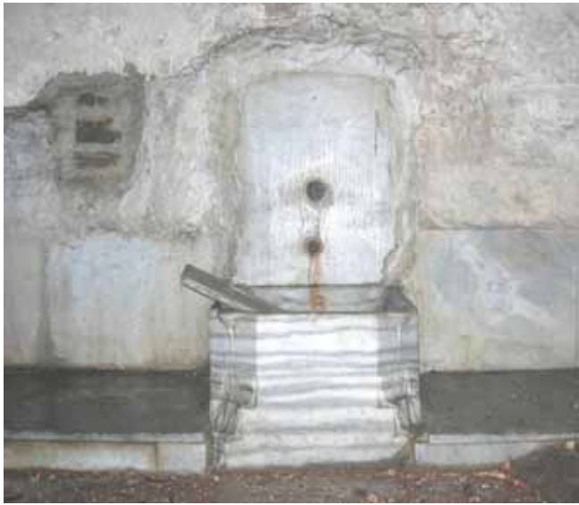
Şekil C.3-203: Z05-2; kuzeydoğu duvarı ve seki
