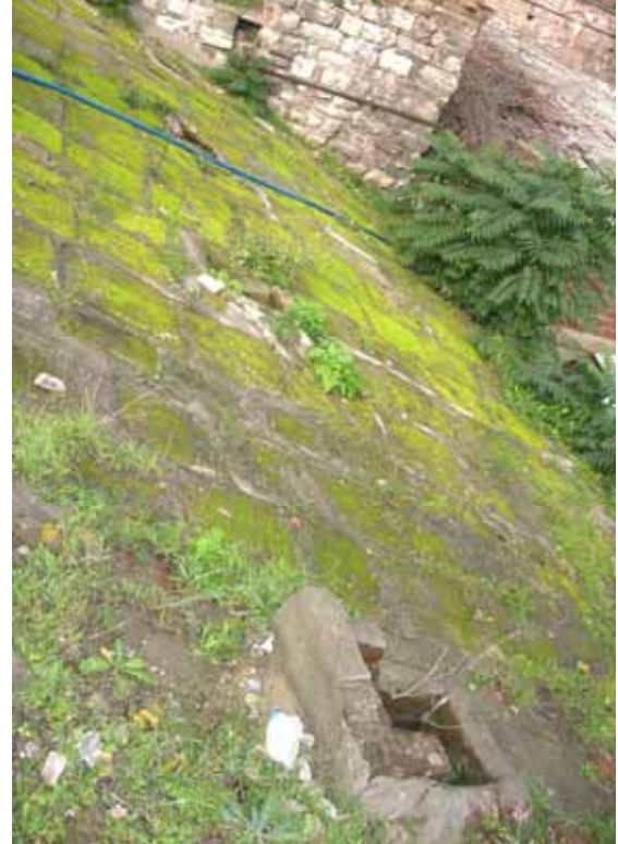
Şekil C.5-101: Z07'nin taş kaplı örtüsündeki bozulma
