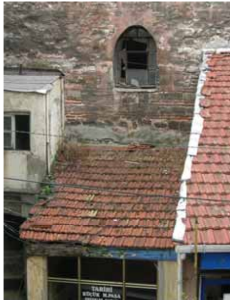
Şekil C.4-6: Güneybatı cephesi; almaşık örgü
