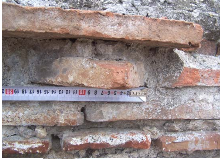
Şekil C.5-161: Kirpi saçak; İznik- Büyük Hamam (15.10.2006)
