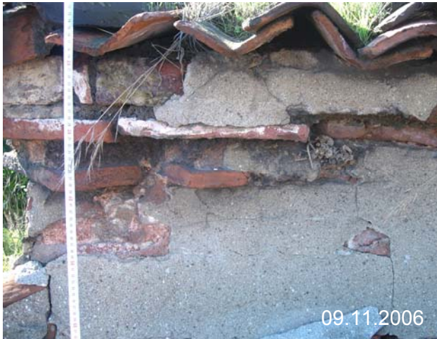
Şekil C.7-3: Çimentolu sıvadaki çatlama ve dökülmeler
