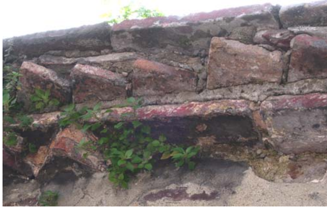
Şekil C.5-130: Kirpi saçak; kasnak kuzeydoğu duvarı (orta bölüm)
