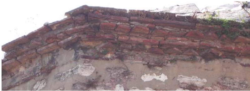
Şekil C.5-132: Kirpi saçak; kasnak kuzeydoğu duvarı (kuzey köşe)
