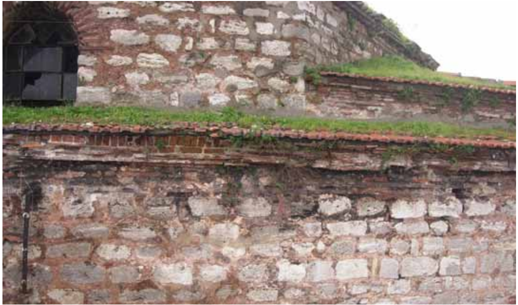
Şekil C.4-20: Soyunmalık kuzeydoğu cephesi, saçak kornişi
