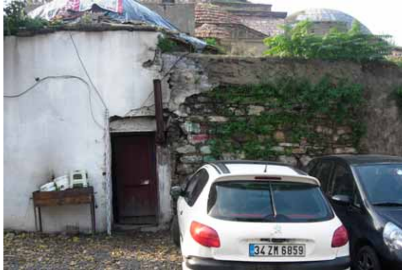
Şekil C.4-11: Kuzeydoğu cephesi; su kulesi
