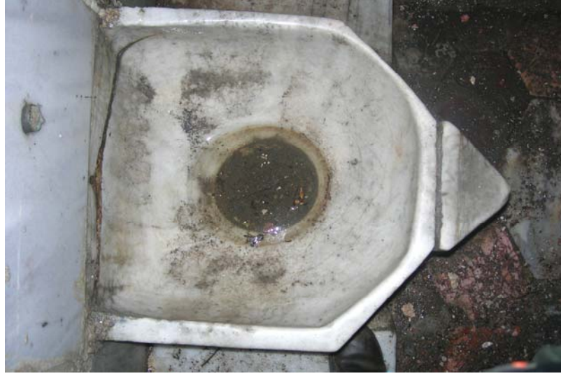
Şekil C.7-35: Mermer elemanlarda gözlenen kirlenme
