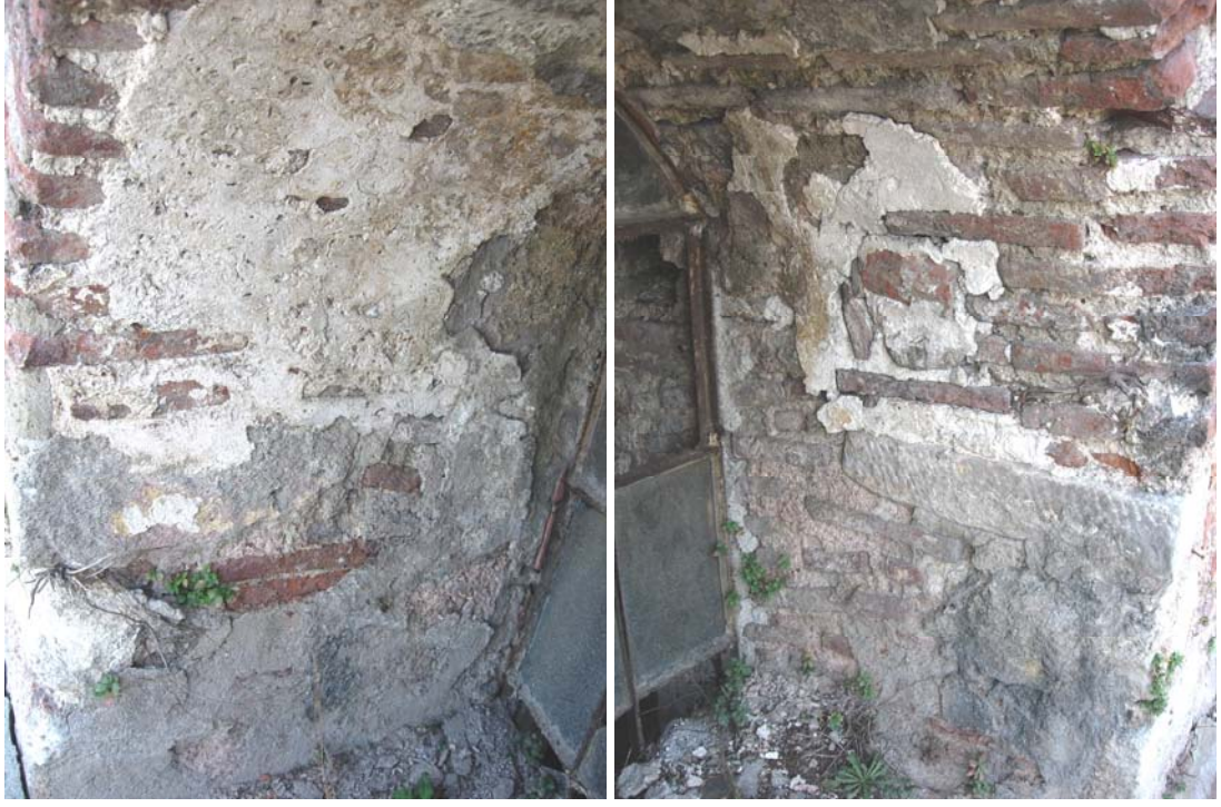
Şekil C.6-12: Kuzeydoğu kasnak duvarı; dış taraf
