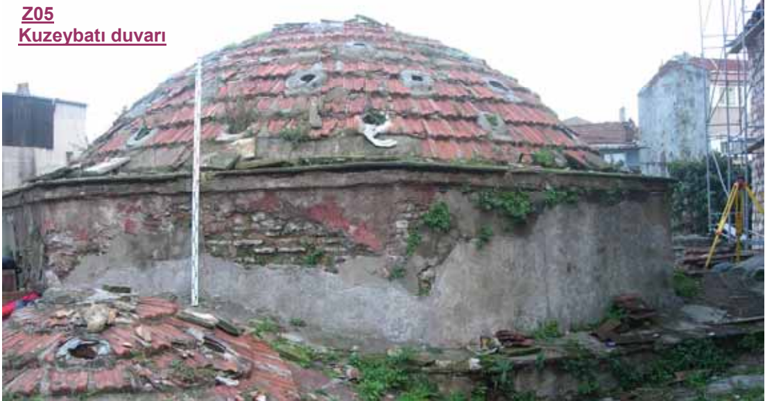
Şekil C.5-86: Duvar örgüsü görülebilen kasanak duvarları (tuğla-horasan harcı)
