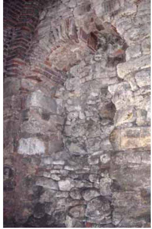
Şekil C.3- 254: Z07; güneydoğu nişi
