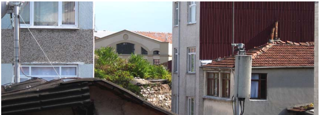
Şekil B.14: Eski Cibali Tütün Fabrikası'nın kuzey cephesi
