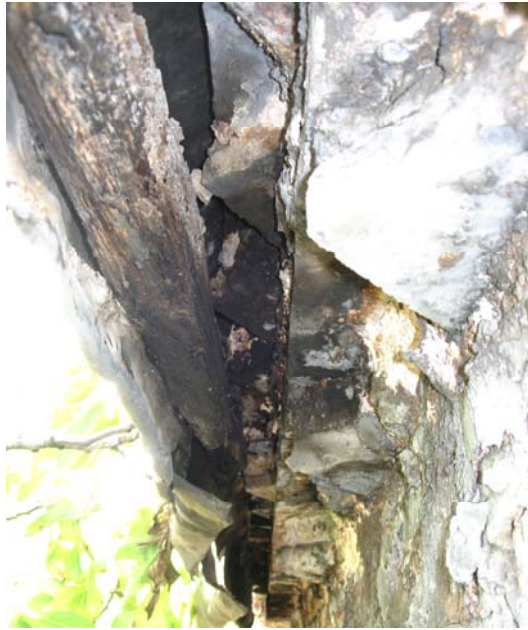
Şekil C.5-156: Kirpi saçak; kasnak güneydoğu duvarı
