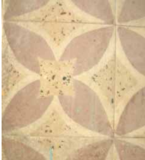
Şekil C.3-64: Z02i; duvar kaplaması
