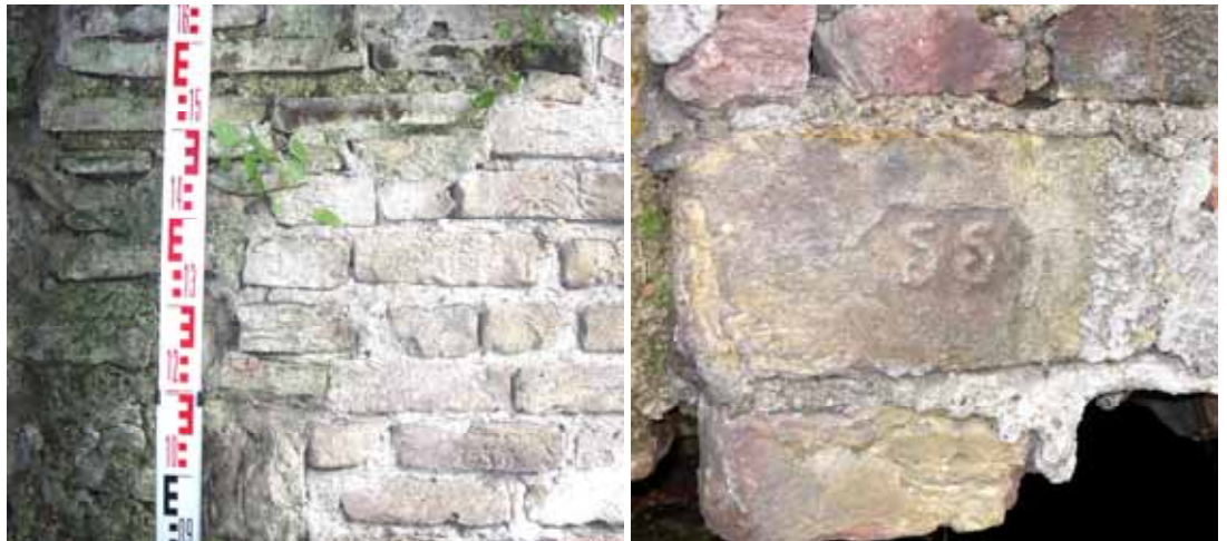
Şekil C.3- 242: Z07'ye girişteki harman tuğlası duvar örgüsü
