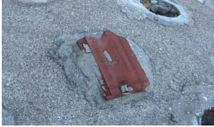
Şekil C.5-89: Kiremit ve çimentolu harçla kapatılan ışık gözü (Z05-3)
