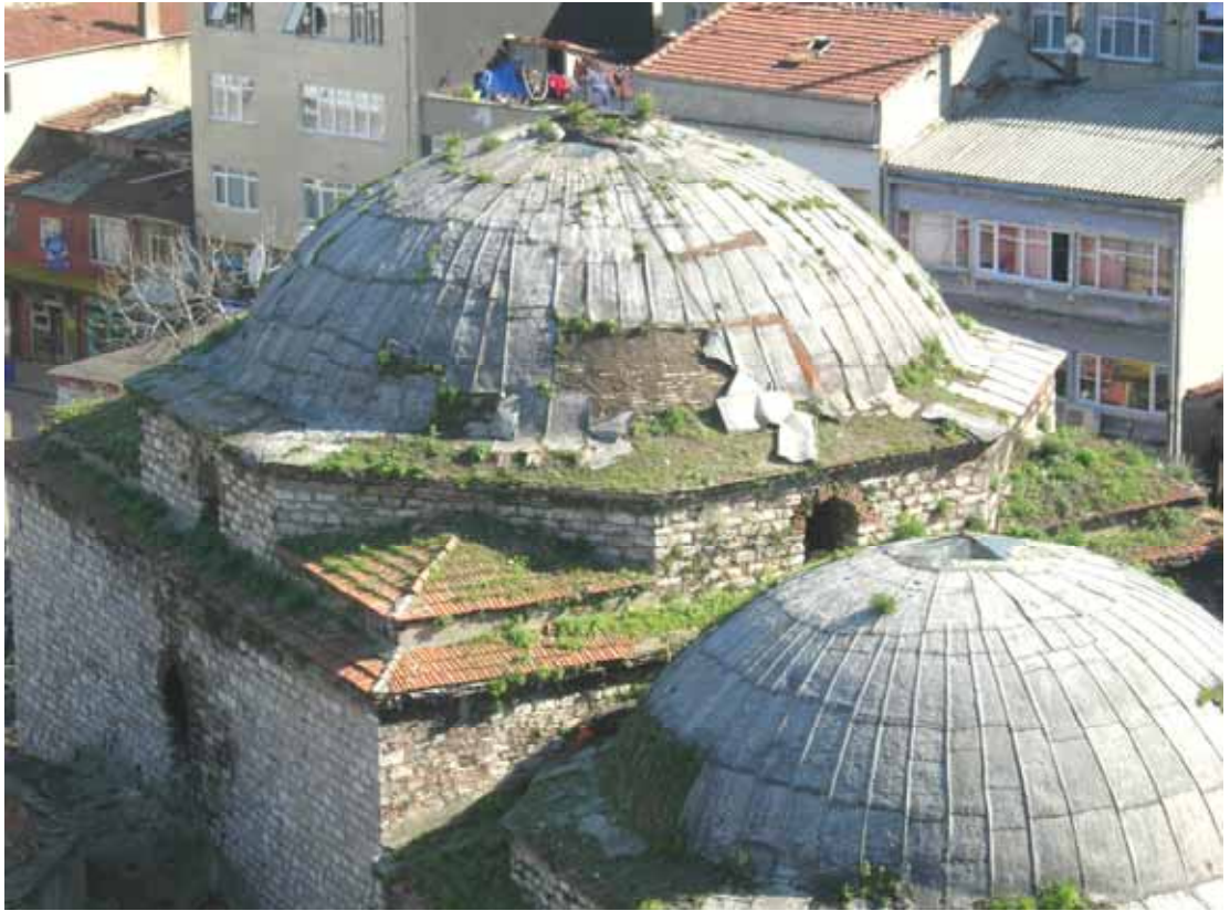
Şekil C.5-62: Erkekler Bölümü; Z02 kubbесinin kasağı (03.04.2006)
