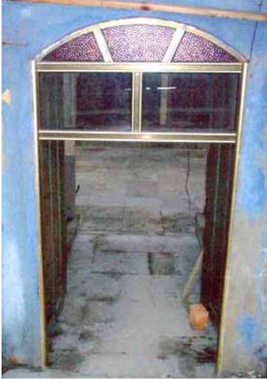
Şekil C.3-9: Z02a'ya açılan kemerli giriş ve muhdes kapı
