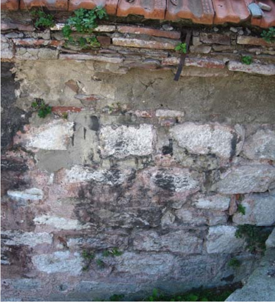
Şekil C.5-118: Kuzeybatı b. duvarı kornişi
