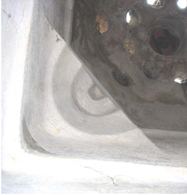
Şekil C.5-39: Z04a; kademeli tromp
