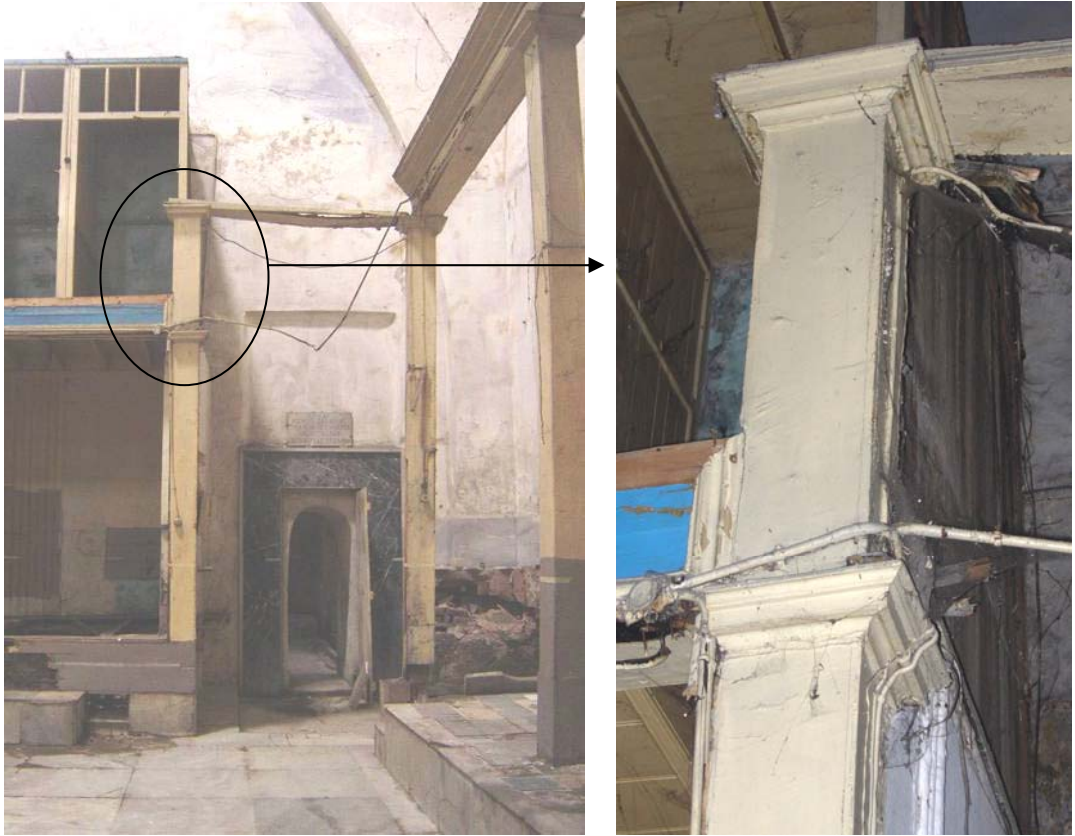
Şekil C.6-52: Şirvan; ahşap silme bitiş detayı
