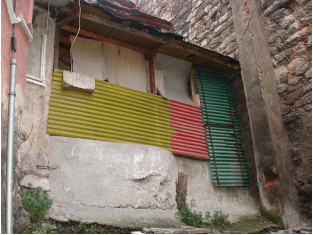
Şekil C.4-21: Güneydoğu cephesi, muhdes yapı
