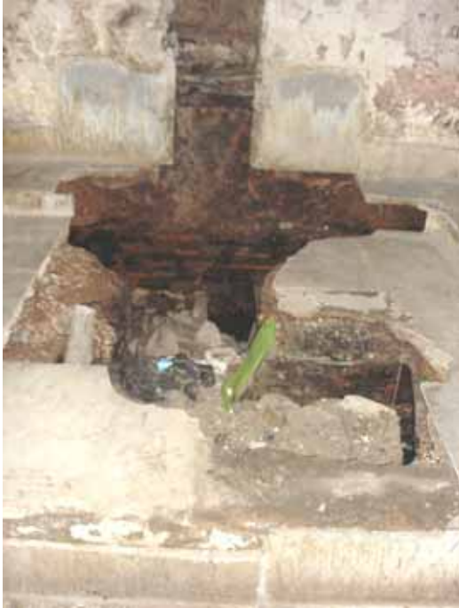
Şekil C.2-23: Kadınlar Bölümü; ılıklık döşemesindeki delik
