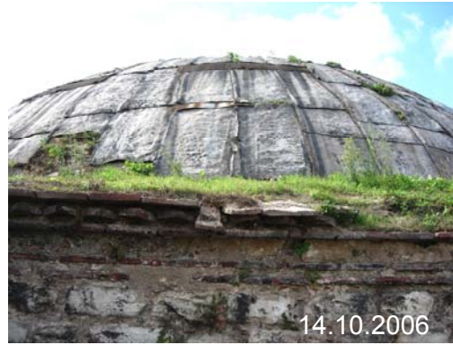
Şekil C.7-13: Bozularak koruyuculuğunu yitiren mevcut kurşun örtü
