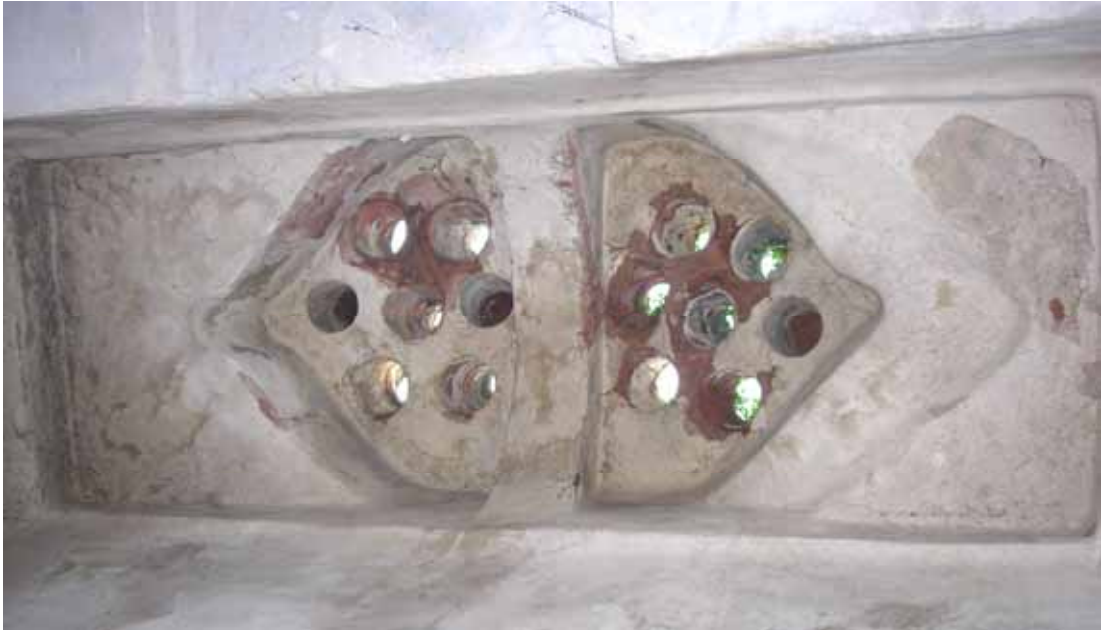
Şekil C.3-89: Z03 eyvanının örtüsü ve ışık gözleri
