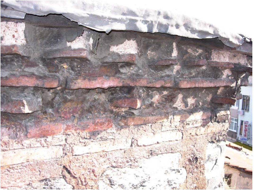
Şekil C.5-147: Kirpi saçak; kasnak batı duvarı (güney bölüm)
