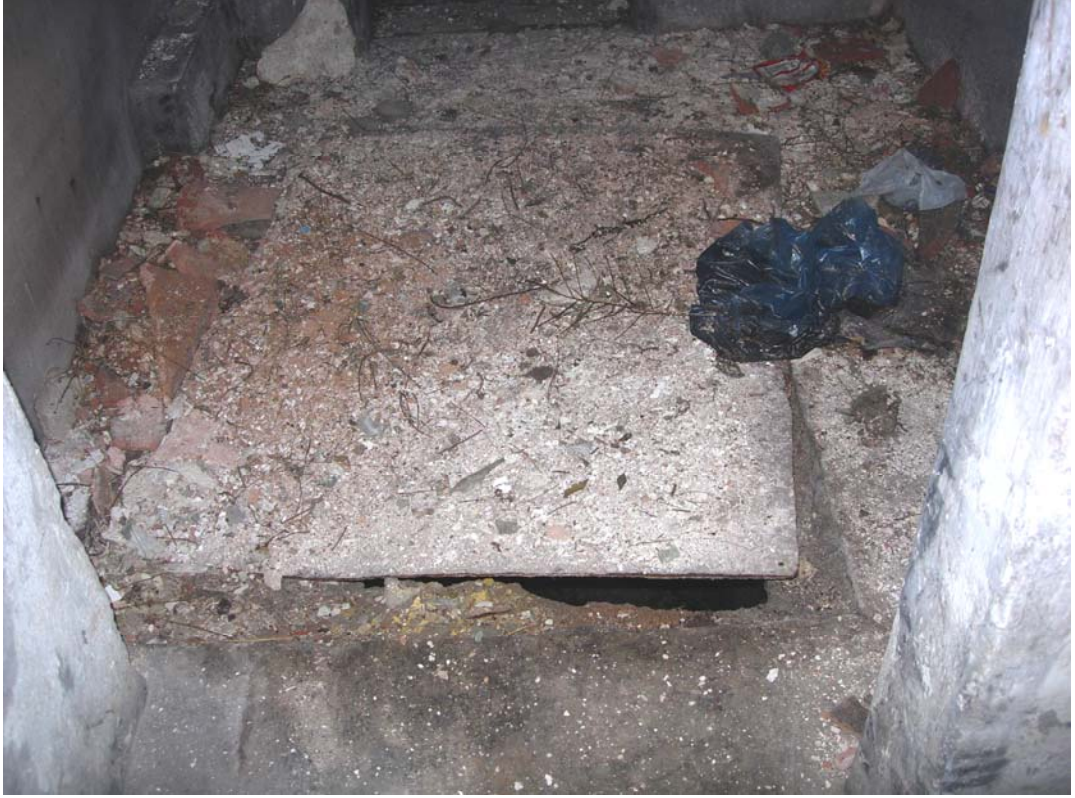
Şekil C.5-10: Z03; güneydoğu eyvanının döşemesindeki delik (çapı≈1m)
