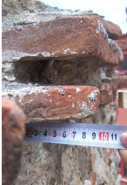
Şekil C.5-162: Kirpi saçak; İznik- Büyük Hamam (15.10.2006)
