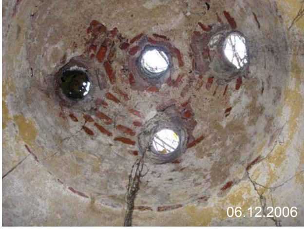
Şekil C.7-33: Sıva dökülmeleri ve çatlakları
