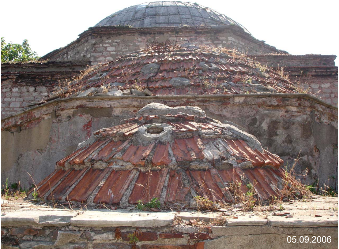
Şekil C.7-11: Örtü sisteminin temizlik öncesi ve sonrası durumu
