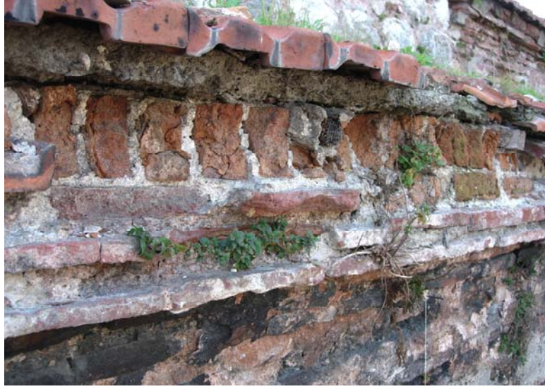
Şekil C.5-110: Kuzeydoğu kornişi; harman tuğlası örgü
