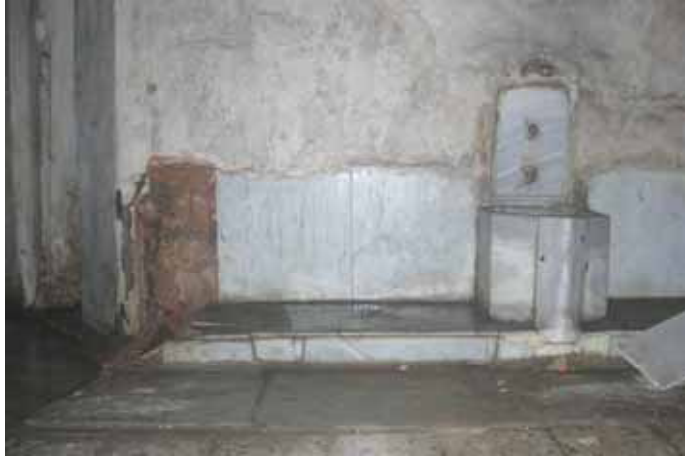
Şekil C.3-138: Z05b; güneybatı duvarı ve seki
