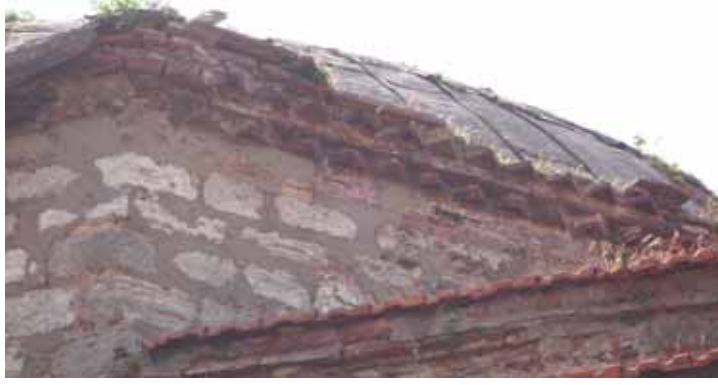
Şekil C.5-63: Z02; kubbe kasmağındaki kirpi saak
