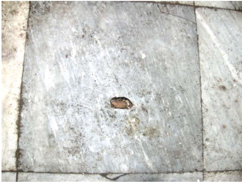
Şekil C.5-7: Z02; döşemede açılan delik (çapı=6.5cm)
