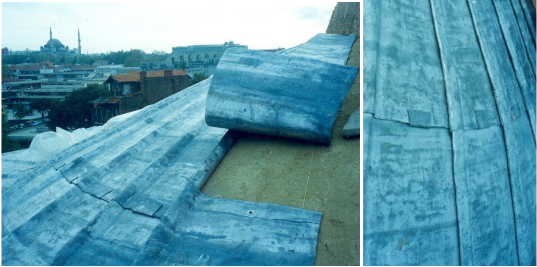
Şekil E.9: Kurşun kaplamanın kubbede uygulanışı
