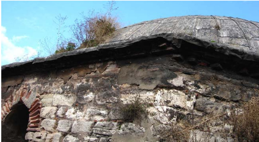
Şekil C.5-150: Kirpi saçak; kasnak güneybatı duvarı (güney köşe)
