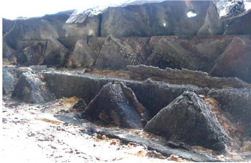
Şekil C.5-152: Kirpi saçak; kasnak güney duvarı
