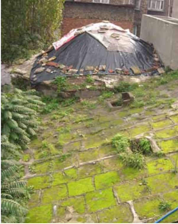
Şekil C.3- 272: Z08'in branda örtülü kubbesi
