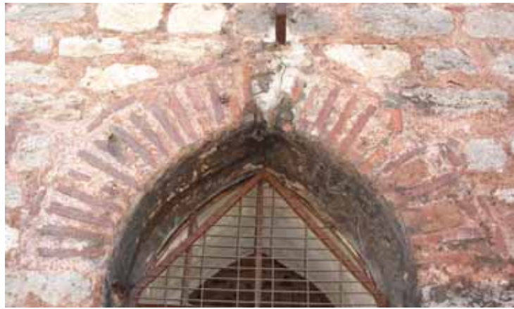
Şekil C.4-18: Kuzeydoğu cephesi; pencere
