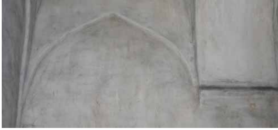
Şekil C.3-145: Z05b; kuzeydoğu kemeri
