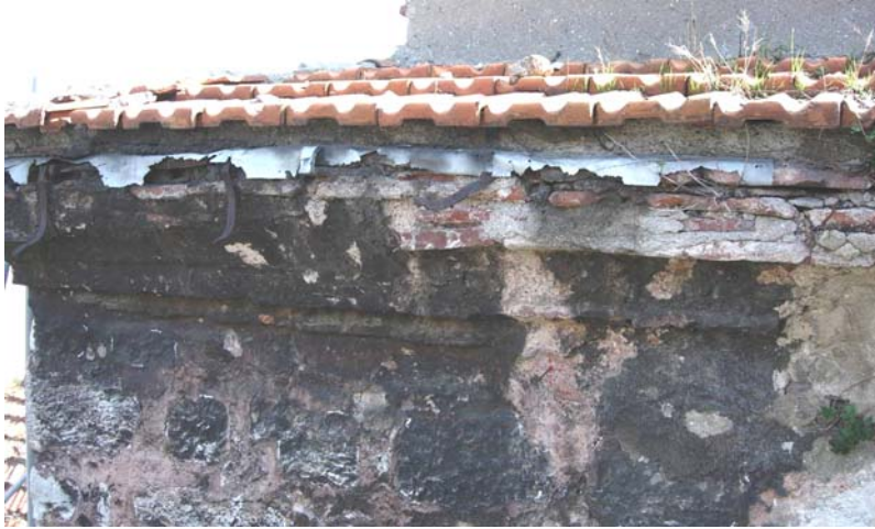
Şekil C.5-121: Kuzeybatı kornişi; bozuk örgü
