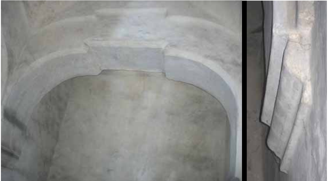
Şekil C.3-79: Z03'ü güneydoğu eyvanından ayıran kemer
