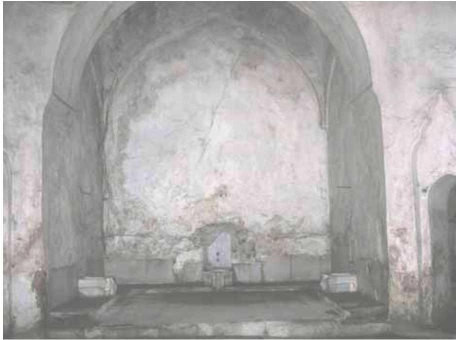
Şekil C.3-149: (Kuzeydoğu eyvanı) Z05c'nin genel görünümü
