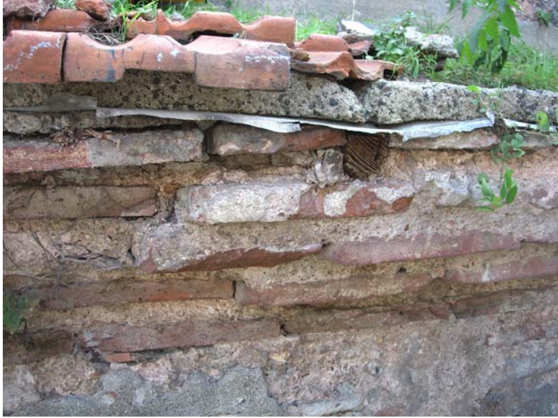
Kuzeybatı Cephesi Saçak Korniş
