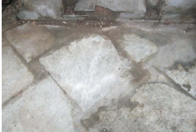
Şekil C.5-17: Z05 döşemesi; kuzey bölümü
