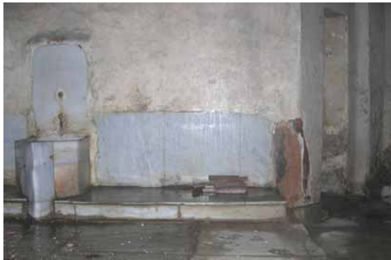
Şekil C.3-170: Z05d; güneybatı duvarı ve seki
