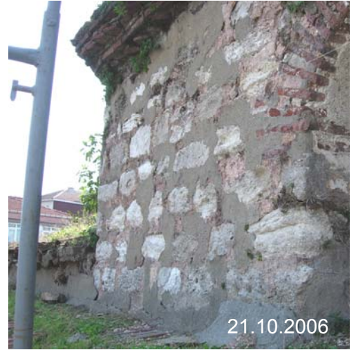
Şekil C.7-5: Kasnak cephelerinde çimentolu sıvayla yapılan onarımlar
