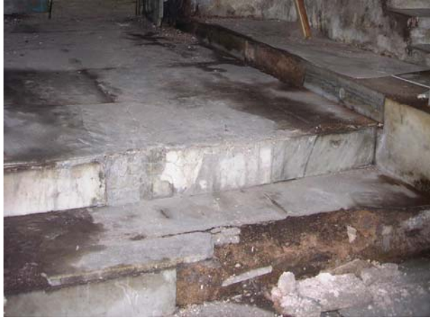
Şekil C.5-2: Z02a; basamaklardaki bozulmalar
