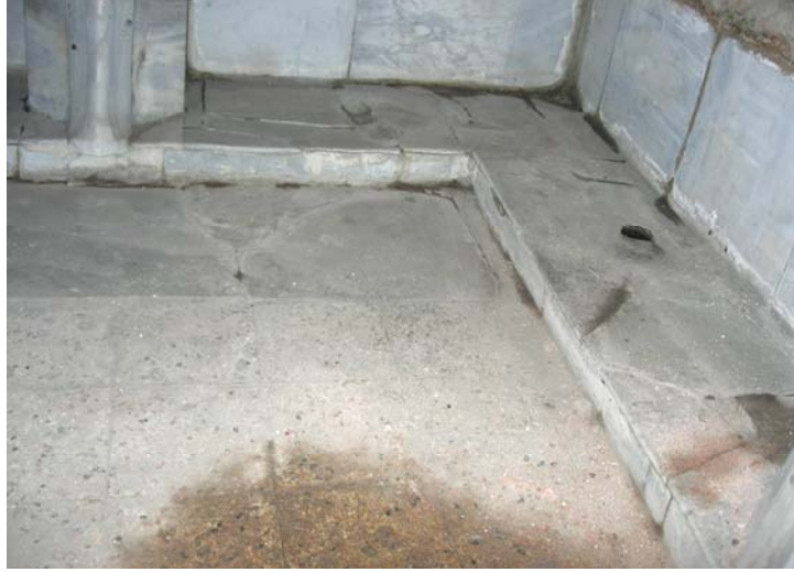
Şekil C.5-19: Z05b döşemesi; güneybatı bölümü
