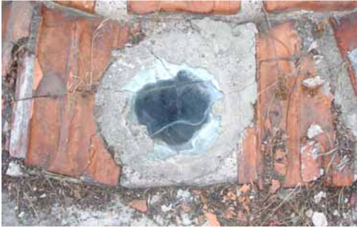
Şekil C.5-91: Işık gözünü örten düz cam (Z03; 06.09.2006)
