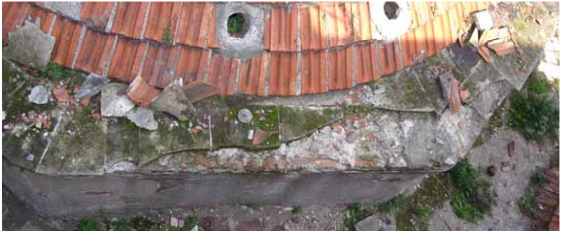
Şekil C.5-81: Z05- kubbe kasmağı; güneybatı saçağı
