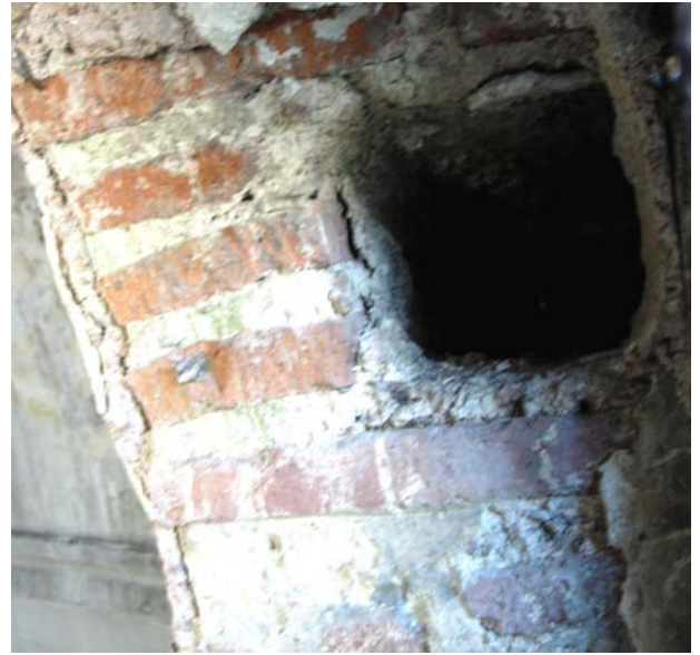
Şekil C.6-7: Kuzeybatı penceresi; hatıl deliği
