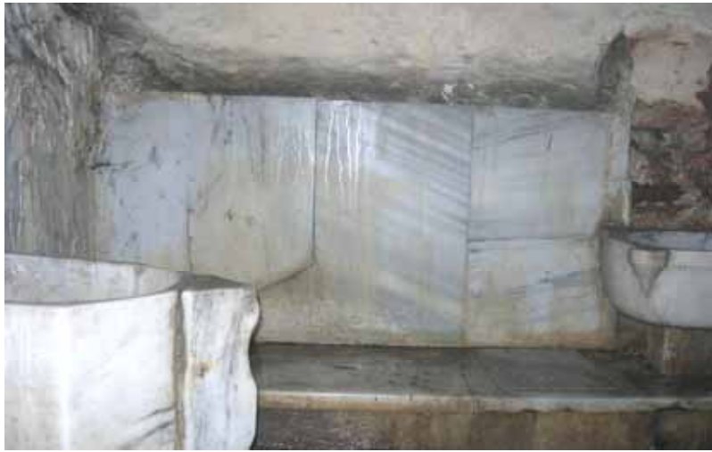
Şekil C.3-185: Z05-1; kuzeydoğu duvarı ve seki
