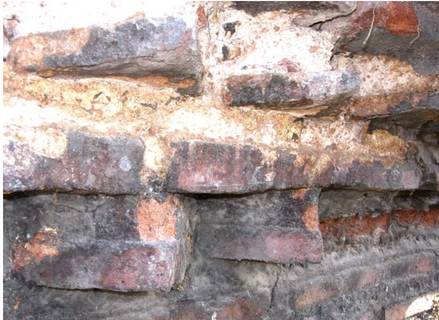
Şekil C.5-145: Kirpi saçak; kasnak batı duvarı (farklı harç tipleri)
