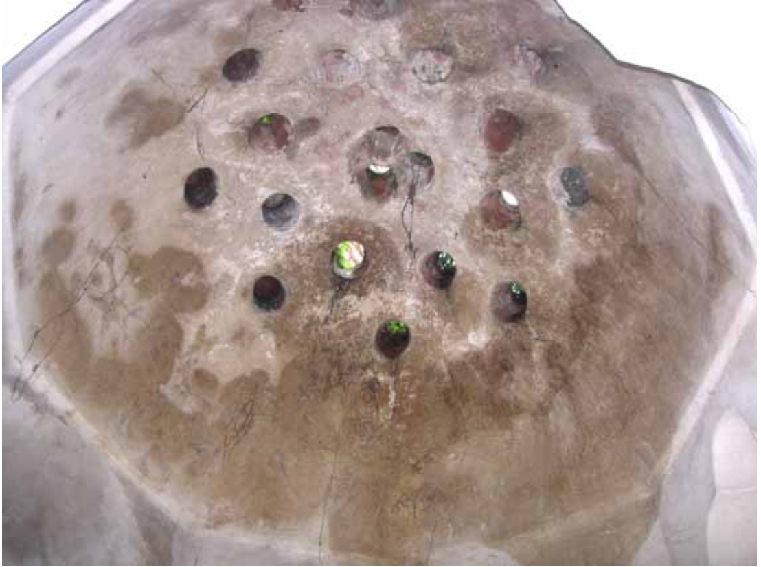
Şekil C.3-192: Z05-1; kubbede görülen bozulmalar
