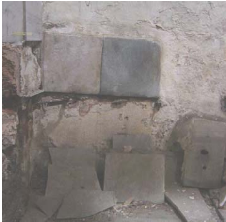
Şekil C.7-14: Soyunmalık; doğu köşede sökülen mermer izleri
