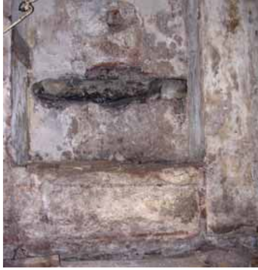
Şekil C.3-50: Z02e; kuzeydoğu duvarındaki niş
