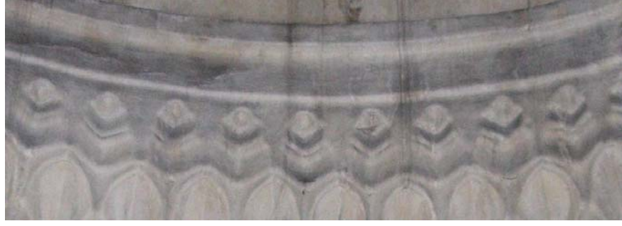
Şekil C.5-48: Z05; mukarnas üst bitiş sırası
