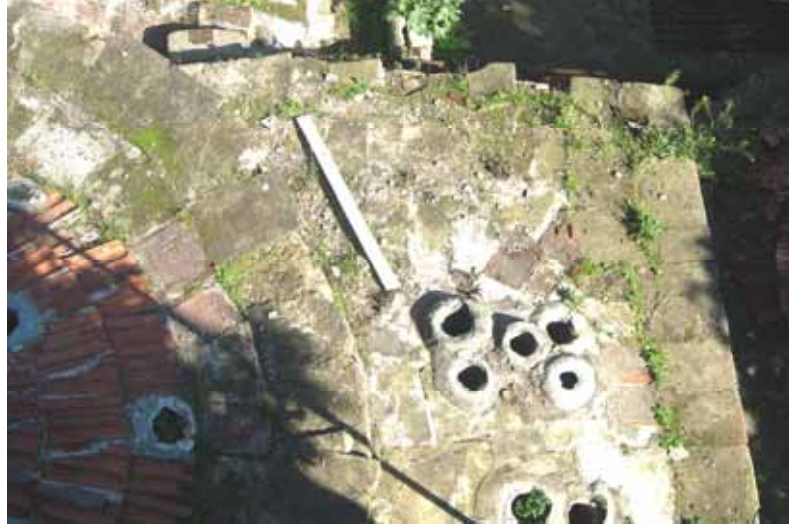
Şekil C.5-82: Z03- kubbe kasnağı; güneydoğu saçağı
