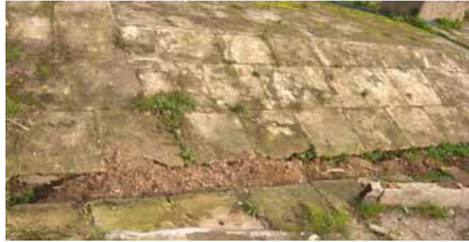
Şekil C.5-96: Z06'nın çatısıyla sıcaklık örtüsü arasındaki boşluk
