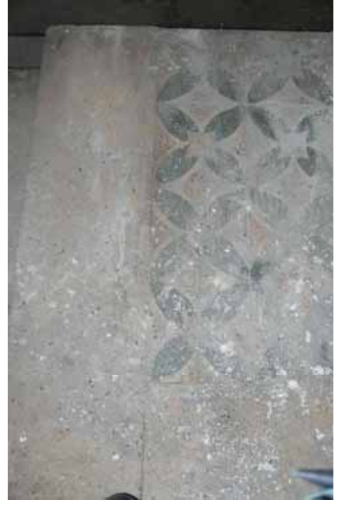
Şekil C.3-28: Z02c; merdiven sahanlığı
