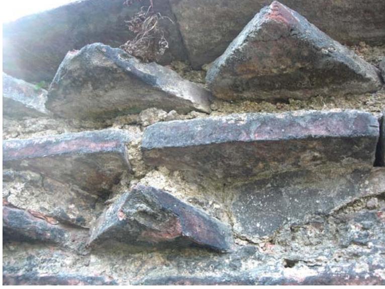
Şekil C.5-158: Kirpi saak; kasnak doęu duvarı (güney bölüm)
