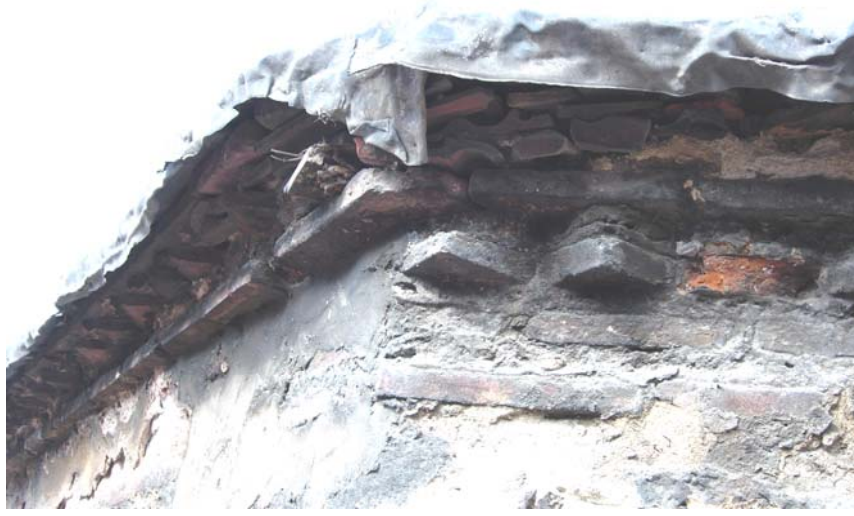
Şekil C.5-151: Kirpi saçak; kasnak güney duvarı (batı köşe)
