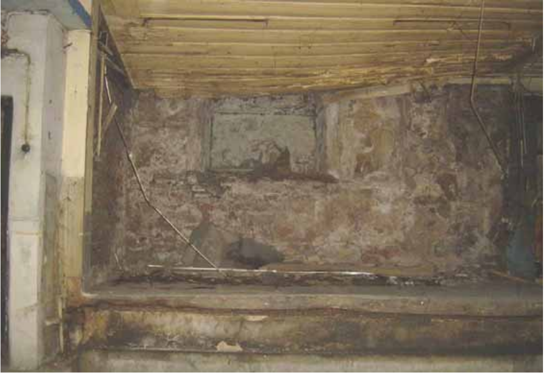
Şekil C.3-34: Z02b; güneybatı duvarındaki niş
