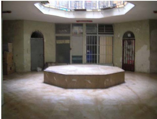
.....sıcaklık mekanına yapılan eklemeler
