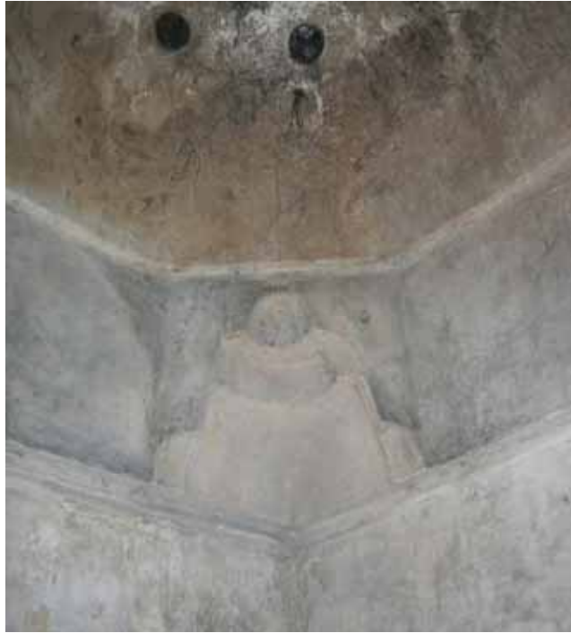
Şekil C.3-190: Z05-1'in kubbesi; geçiş ögesi (kademeli tromp)
