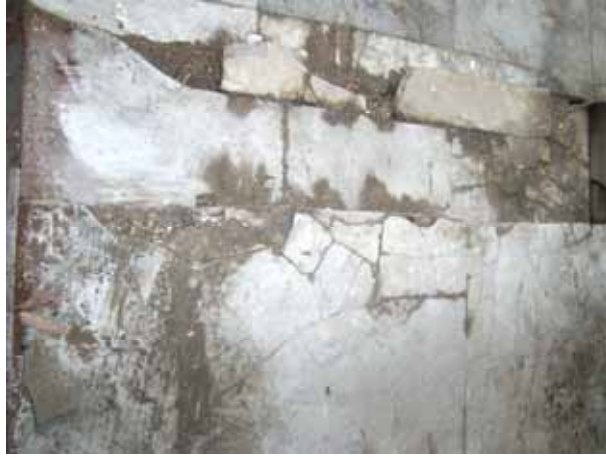
Şekil C.3-16: Z02a; mermer basamaklardaki hasar
