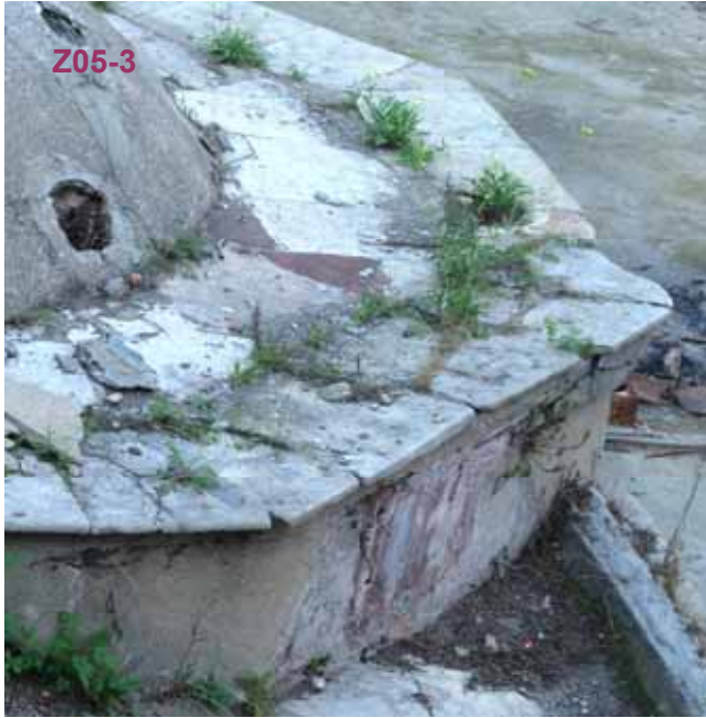
Şekil C.5-80: Kubbe kasnaklarındaki taş örtü ve saçaklar
