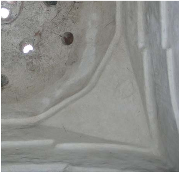
Şekil C.5-37: Z03'ün kubbesi; pendentif
