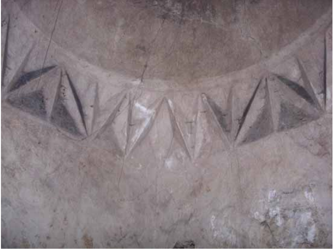
Şekil C.3-210: Z05-2'nin kubbesi; geçiş ögesi (Türk üçgeni)
