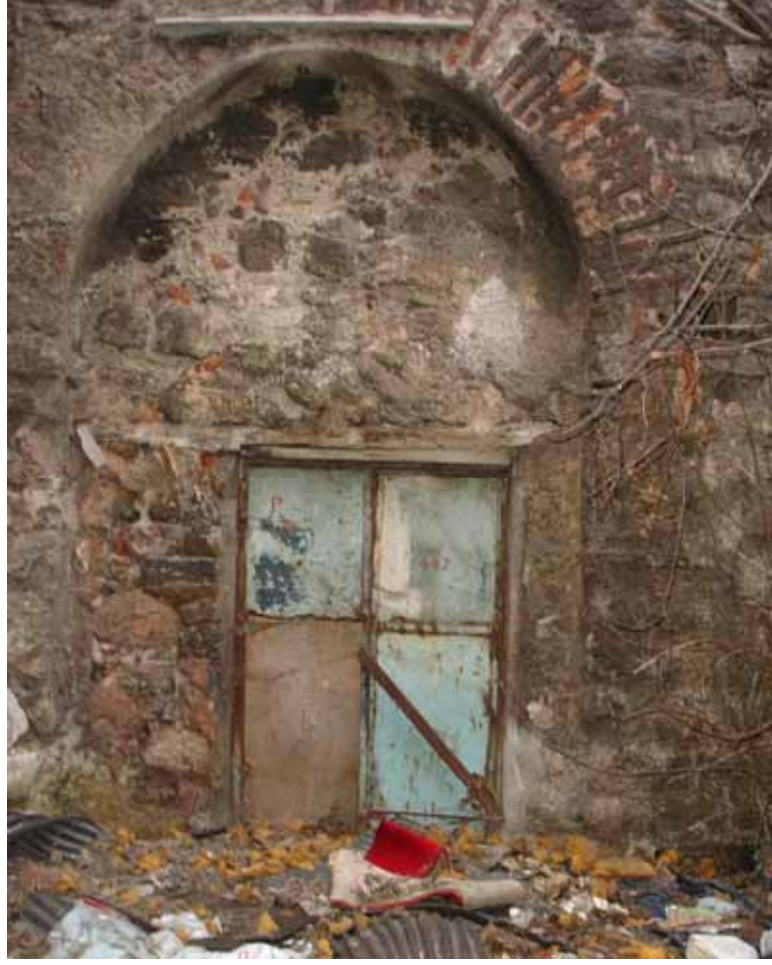
Şekil C.4-23: Güneydoğu cephesi; soyunmalık girişi
