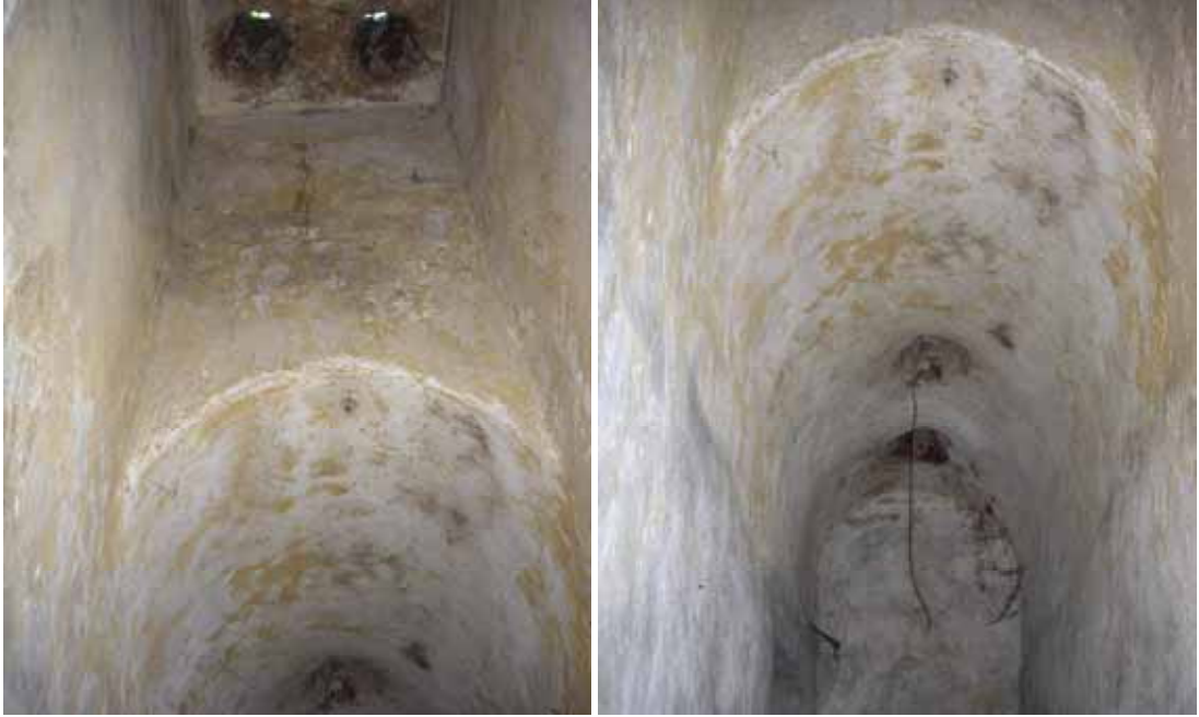
Şekil C.3-96: Z04'ün güneydoğu bölümü; tonoz örtü
