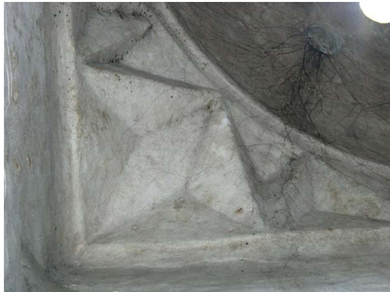
Şekil C.5-56: Üçgenli geçiş bölgesi; köşe detayı
