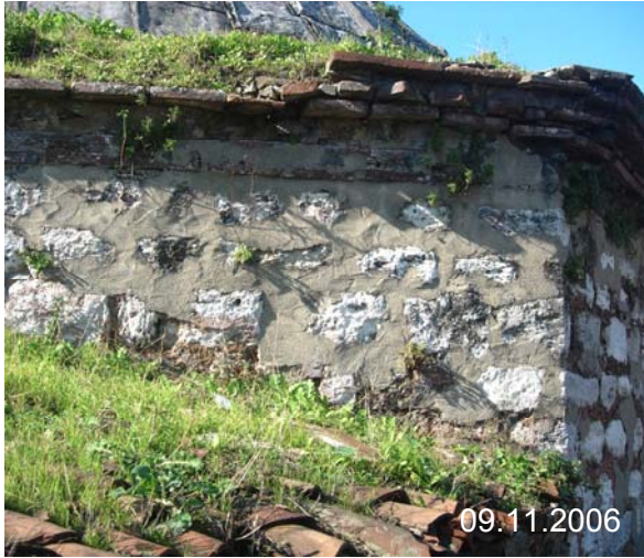
Şekil C.7-5: Kasnak cephelerinde çimentolu sıvayla yapılan onarımlar
