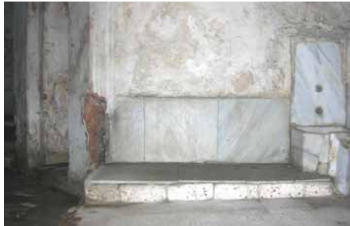
Şekil C.3-150: Z05c; kuzeybatı duvarı ve seki
