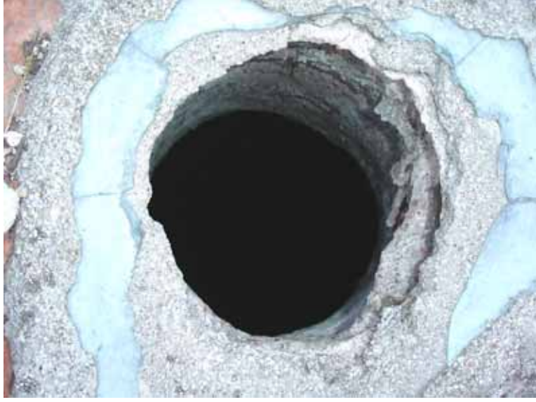
Şekil C.5-92: Camı kırılmış bir ışık gözü (Z05; 06.09.2006)
