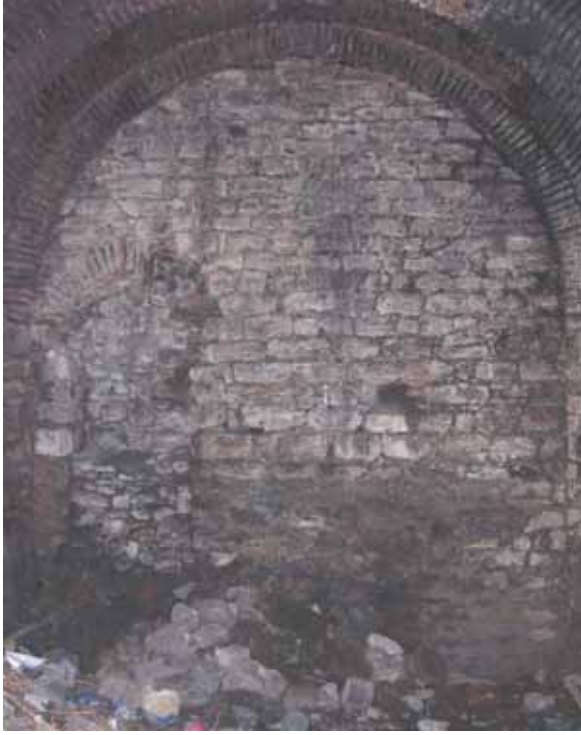
Şekil C.3- 253: Z07; güneydoğu duvarı
