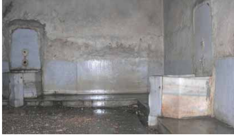
Şekil C.3-168: Z05d; güneydoğu duvarı ve seki
