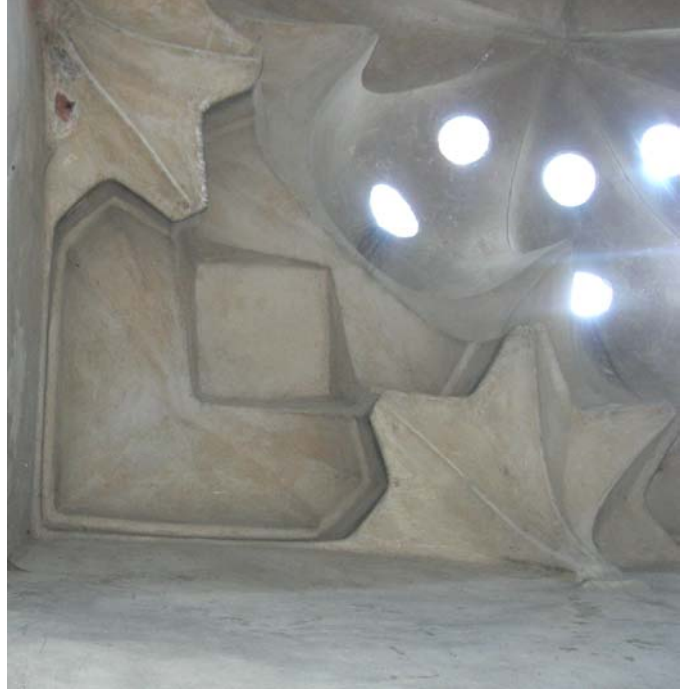
Şekil C.5-53: Z05d; mukarnas köşe detayı
