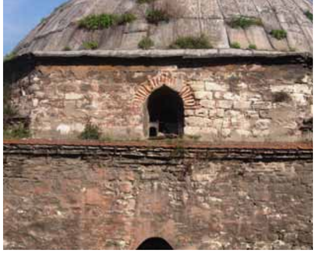
Şekil C.4-4: Tuğla sivri kemer
