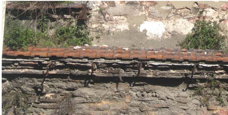
Güneybatı Cephesi Saçak Korniş
