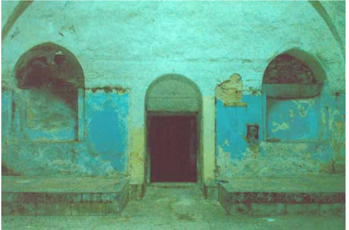
Şekil C.2-18: Kadınlar Bölümü; soyunmalık kuzeybatı duvarı
