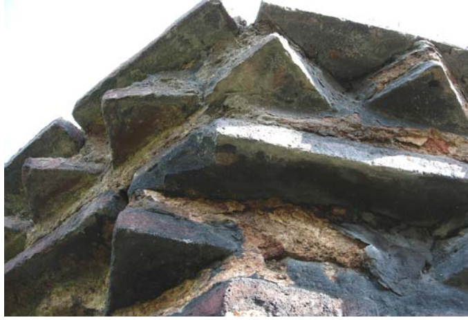
Şekil C.5-143: Kirpi saçak; kasnak batı duvarı (kuzey köşe)
