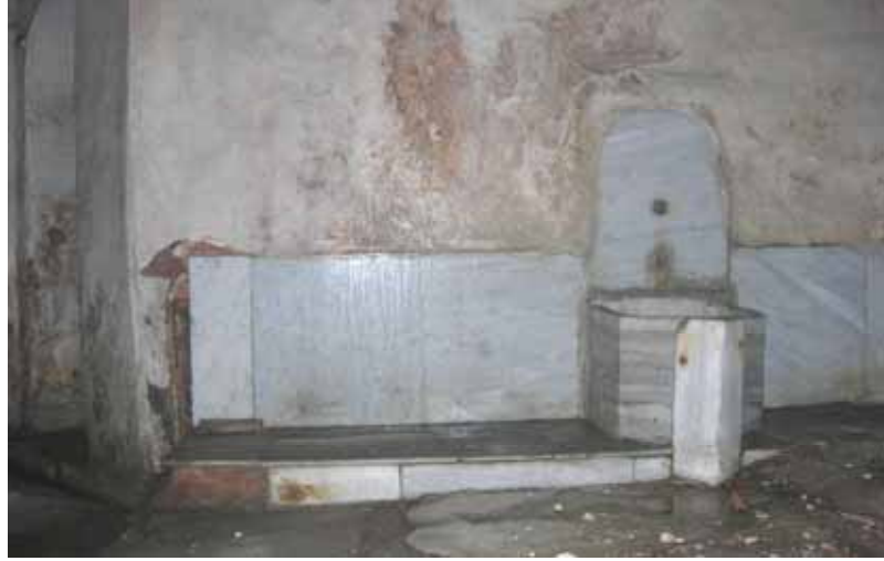
Şekil C.3-165: Z05d; kuzeydoğu duvarı ve seki
