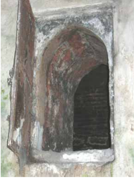
Şekil C.3-235: (Su deposu) Z06'ya açılan pencere (Z05-3 tarafı)
