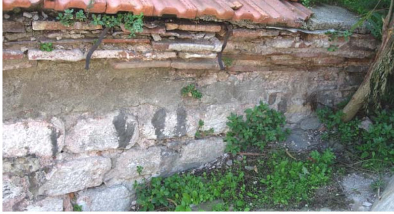
Şekil C.5-120: Kuzeybatı kornişi; bozuk örgü
