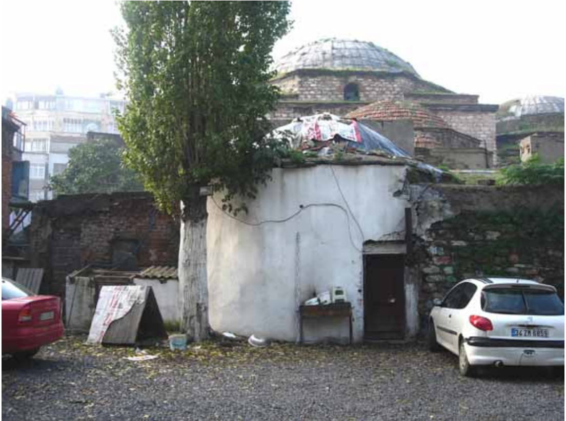
Şekil C.3- 268: (Su kulesi) Z08'in kuzeydoğudan görünümü
