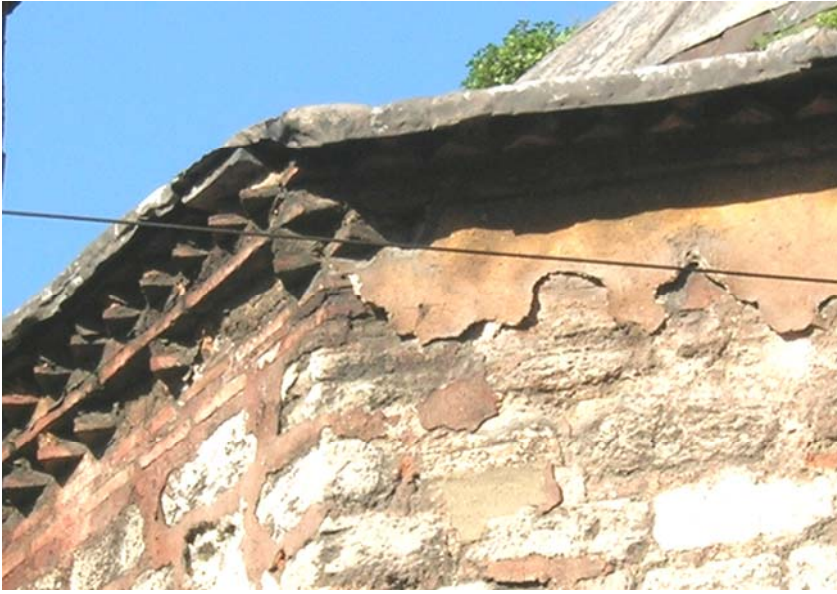
Şekil C.5-149: Kirpi saçak; kasnak güneybatı duvarı (kuzey köşe)
