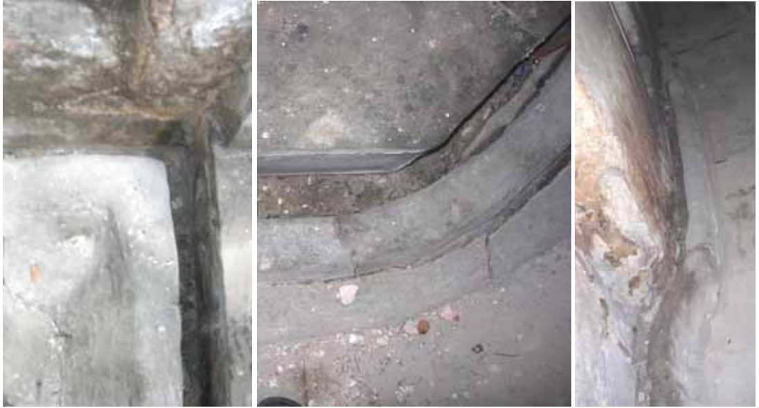
Şekil C.3-82: Z03; helaya kadar uzanan pis su kanalı
