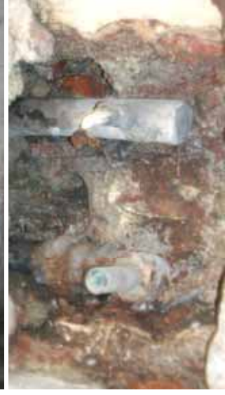
Şekil C.3-187: Z05-1; yenilenmiş demir borular
