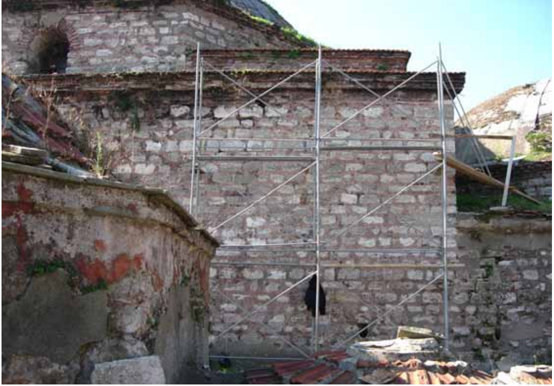
Şekil C.4-13: Kuzeydoğu cephesine kurulan iskele (Eylül 2006)
