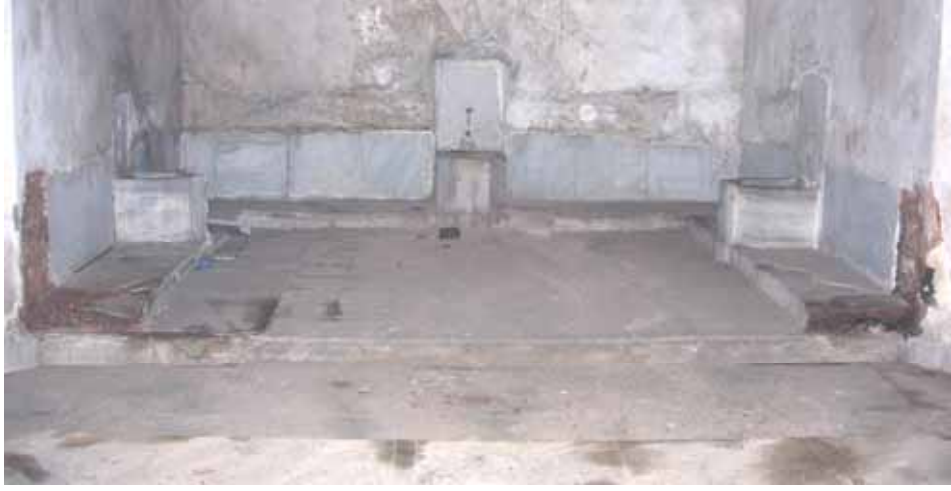
Şekil C.3-146: Z05b döşemesinin genel görünümü
