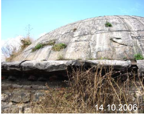
Şekil C.7-13: Bozularak koruyuculuğunu yitiren mevcut kurşun örtü
