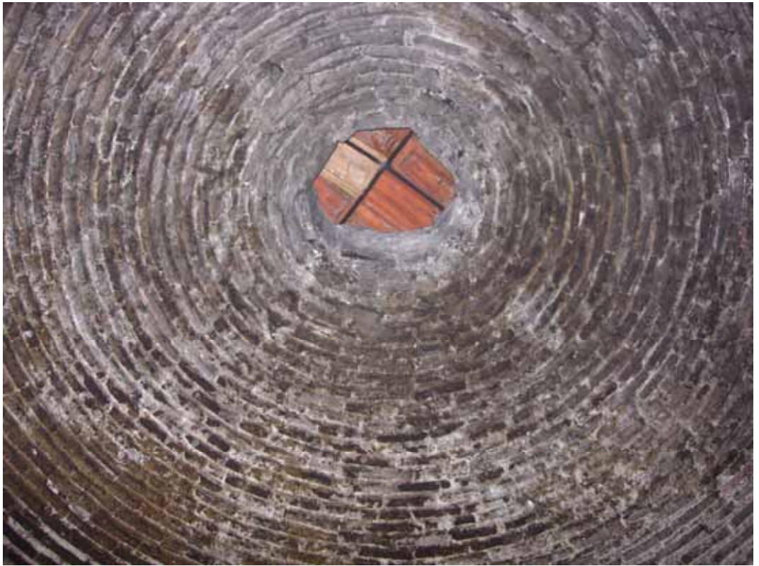
Şekil C.3- 270: Z08'in kubbesi ve tepesindeki fener açıklığı
