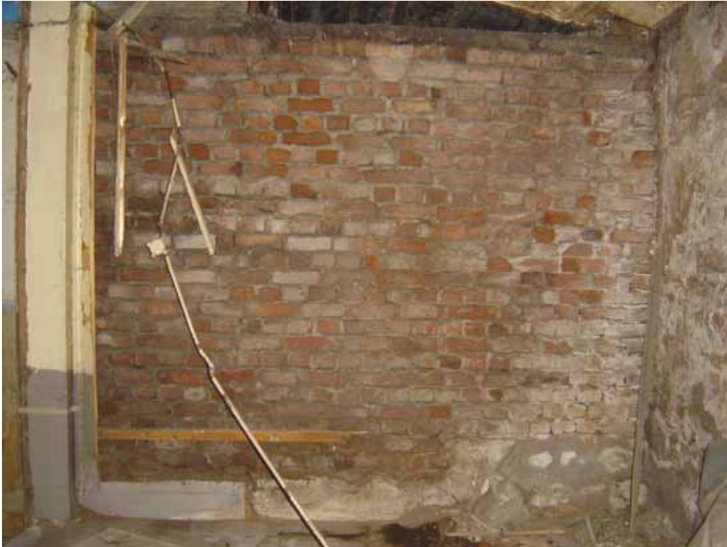
Şekil C.3-26: Z02b ile Z02j mekanlarını ayıran duvar
