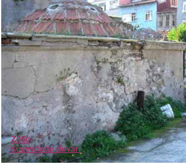
Şekil C.5-85: Çimento sıvalı kasanak duvarları
