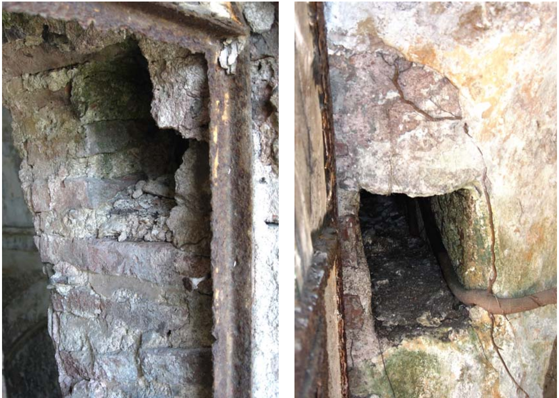
Şekil C.6-11: Kuzeydoğu penceresi; hatıl delikleri
