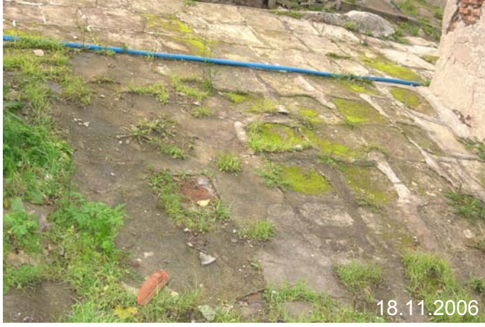
Şekil C.7-4: Çimentolu sıvayla yapılan onarımlar
