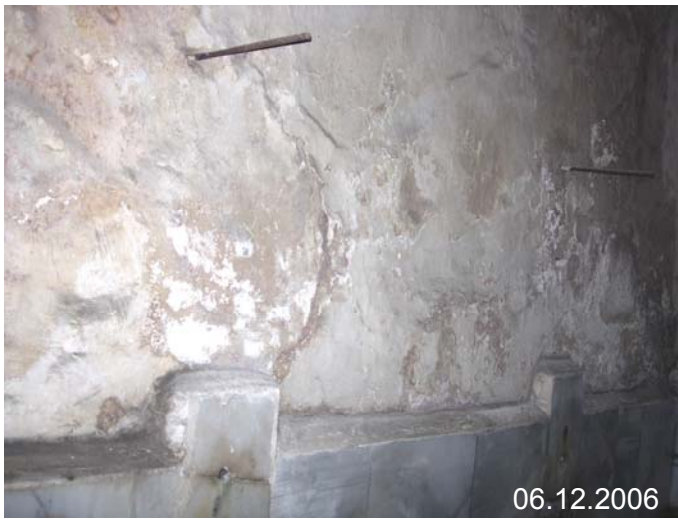
Şekil C.7-32: Duvarlarda nemden kaynaklanan renk değişimleri
