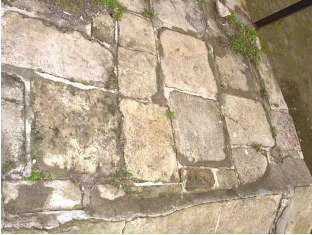
Şekil C.5-99: Z06'nın örtüsündeki onarım izleri (17.11.2006)
