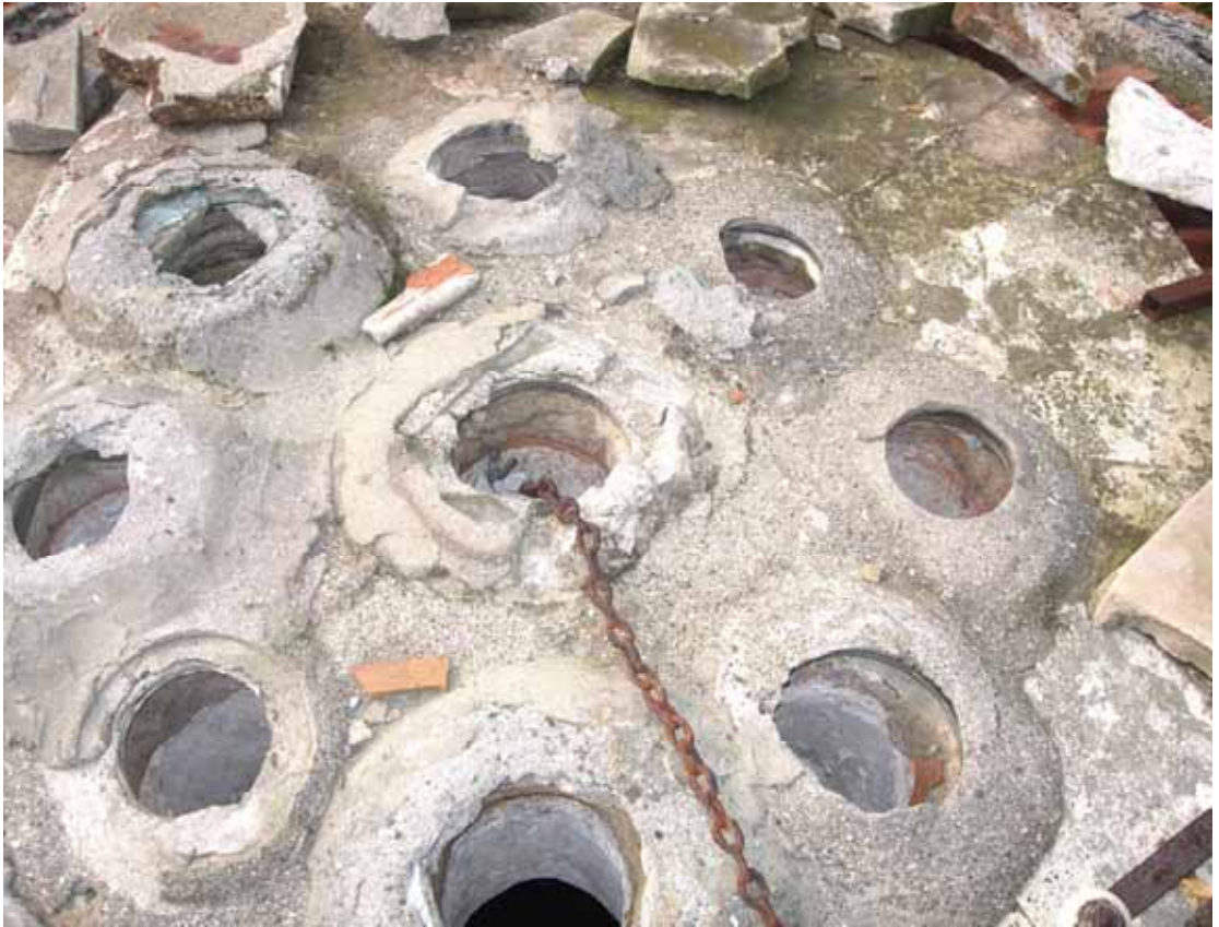
Şekil C.5-93: Z05 kubbesinin tepesindeki açık ışık gözleri
