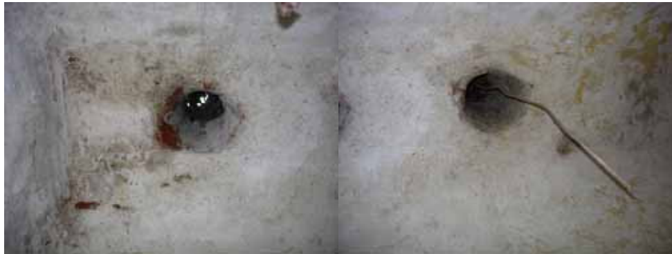
Şekil C.3-97: Z04; tonoz örtüdeki ışık gözleri
