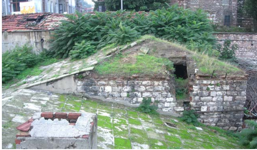
Şekil C.7-24: Odunluk taş örtüsündeki bitkilenme
