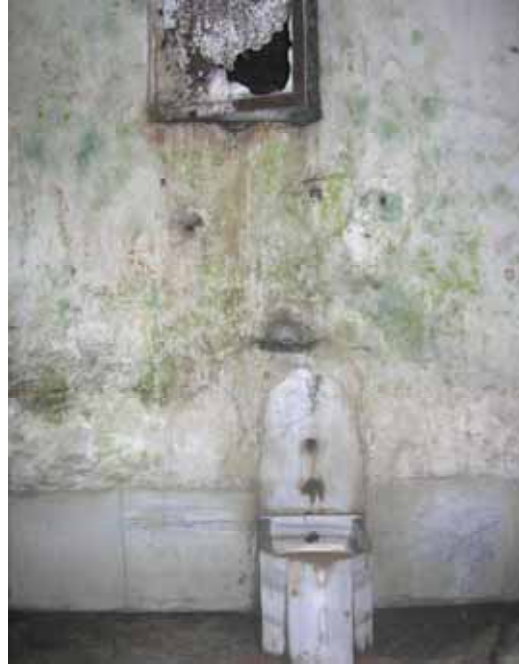
Şekil C.3-220: Z05-3; kuzeydoğu duvarı ve seki
