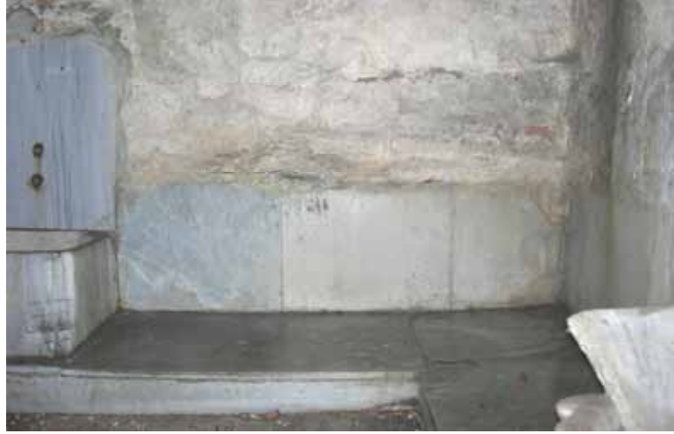
Şekil C.3-202: Z05-2; kuzeybatı duvarı ve seki
