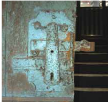
Şekil C.3-13: Ahşap kapının üzerindeki geçmeli kilit
