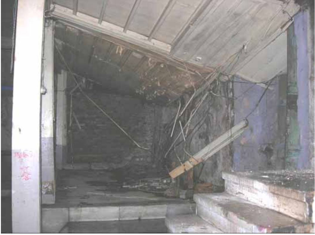
Şekil C.3-25: Z02b; çöken ahşap döşeme
