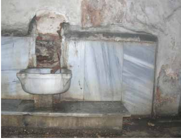
Şekil C.3-186: Z05-1; kuzeydoğu duvarı ve seki
