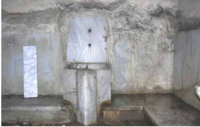
Şekil C.3-184: Z05-1; kuzeybatı duvarı ve seki
