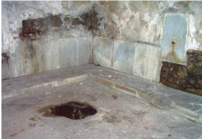
Şekil C.2-26: Kadınlar Bölümü; sıcaklık güneydoğu eyvanı
