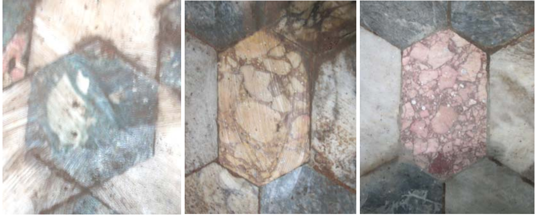
Şekil C.5-25: Z05-1; döşemede kullanılan renkli mermerler
