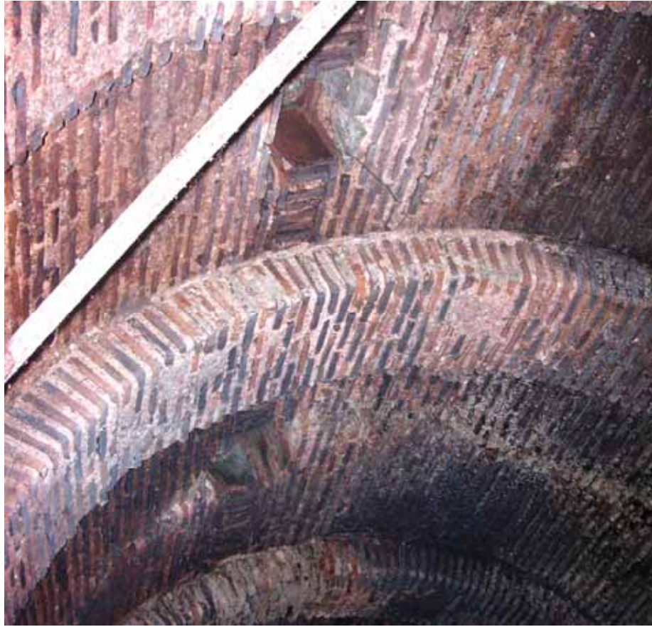
Şekil C.3- 246: Z07'yi örten tonoz ve destek kemerleri
