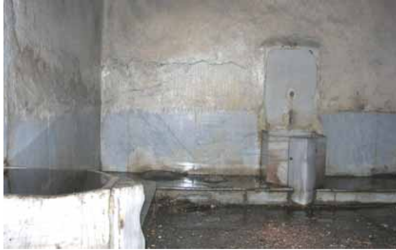
Şekil C.3-169: Z05d; güneybatı duvarı ve seki
