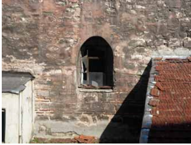
Şekil C.4-5: Güneybatı cephesi; pencere
