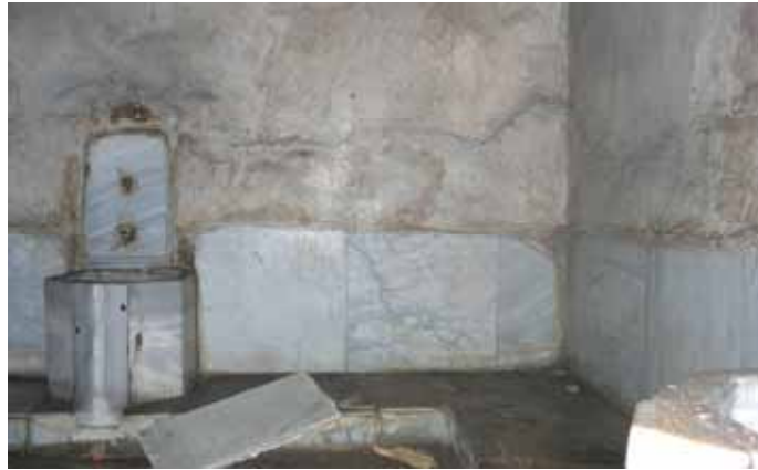
Şekil C.3-139: Z05b; güneybatı duvarı ve seki
