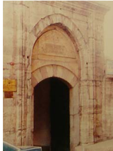
Darüzziyafe girişi (1550-57); [89; s.178]
