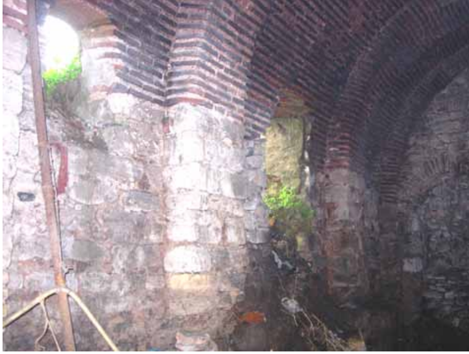
Şekil C.3- 245: Z07; kaba yonu taş duvar ve tuğla tonoz
