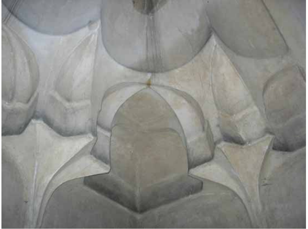
Şekil C.3-174: Z05d; mukarnaslı geçiş bölgesinin köşe detayı
