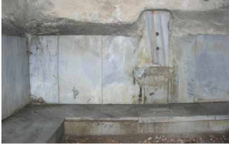
Şekil C.3-181: Z05-1; güneybatı duvarı ve seki
