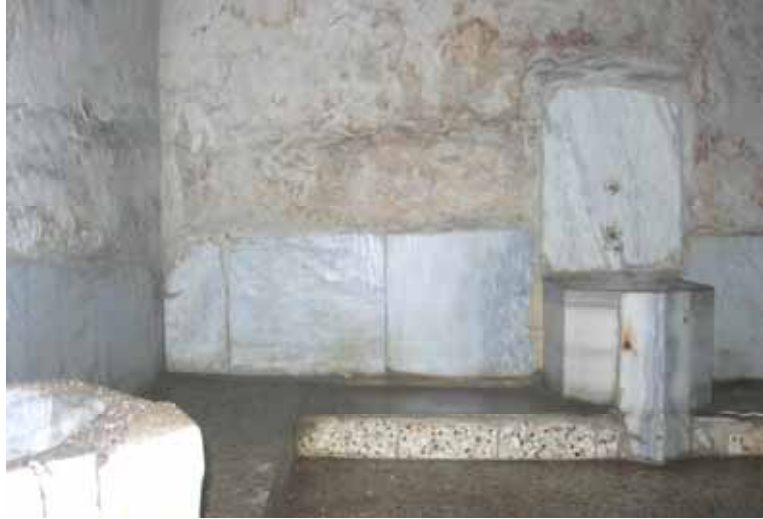
Şekil C.3-143: Z05b; kuzeydoğu duvarı ve seki
