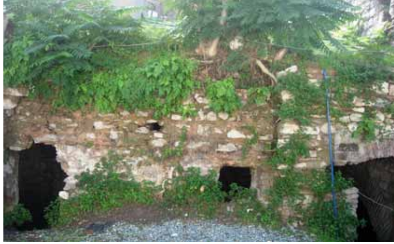
Şekil C.4-10: Kuzeydoğu cephesi; külhan
