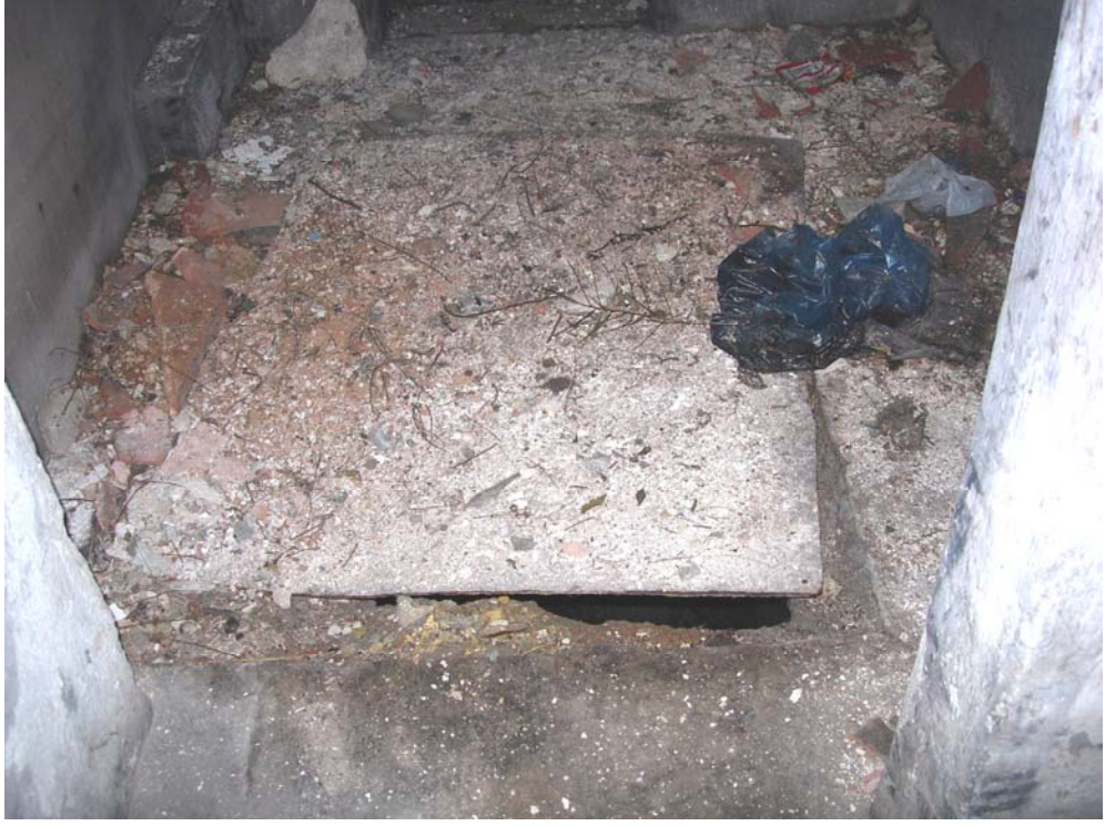
Şekil C.7-20: Ilıklık sekisinde açılan delik
