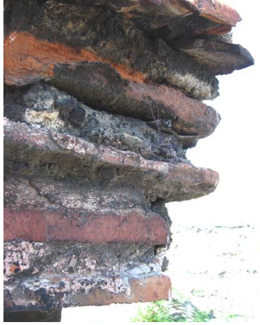
Şekil C.5-106: Z02 korniş; kuzey köşe
