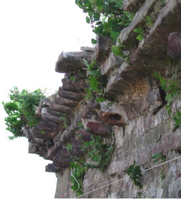
Şekil C.5-134: Kirpi saçak; kasnak kuzey duvarı (korunmuş örgü)
