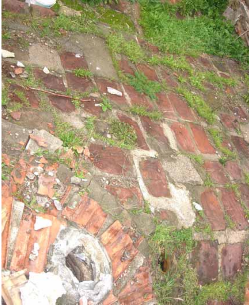
Şekil C.5-88: Tuğla örtü (Z05b'nin batısındaki bölüm)
