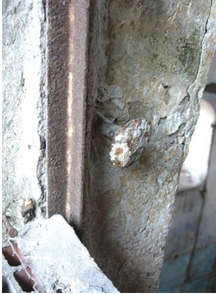
Şekil C.6-6: Kuzeybatı penceresi; tesbit çivisi
