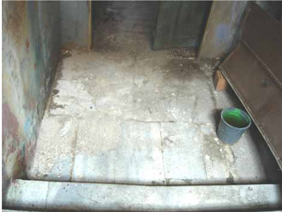
Şekil C.3-5: Z01; mermer döşeme (±0.00 kotu)
