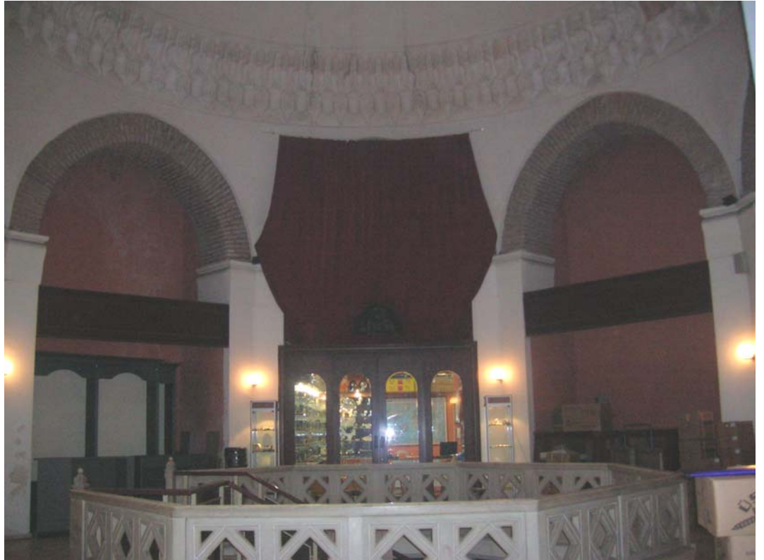
.....Sıcaklığın restorasyon sonrası durumu (Nisan 2006)
