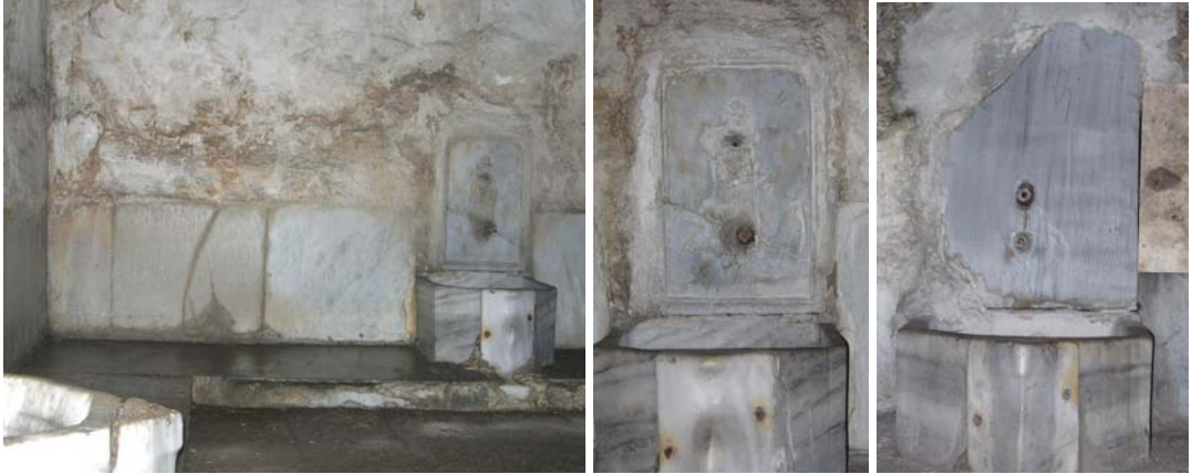
Şekil C.7-16: Tahrip olmuş mermer ayna taşları
