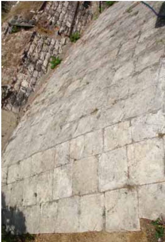
Şekil C.5-101: Z07'nin taş kaplı örtüsündeki bozulma
