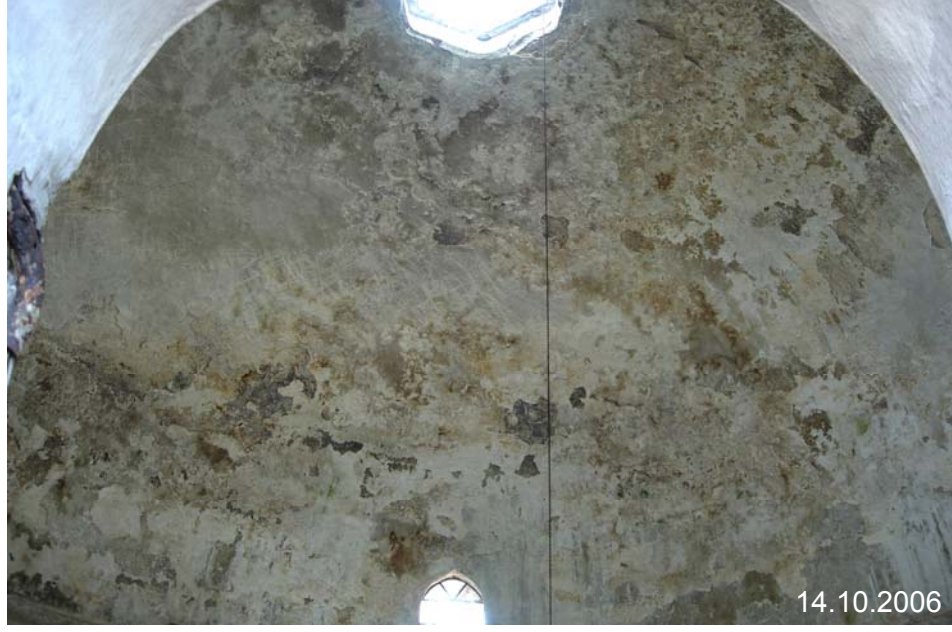
Şekil C.7-30: Soyunmalık kubbesinin iç yüzündeki bozulmalar
