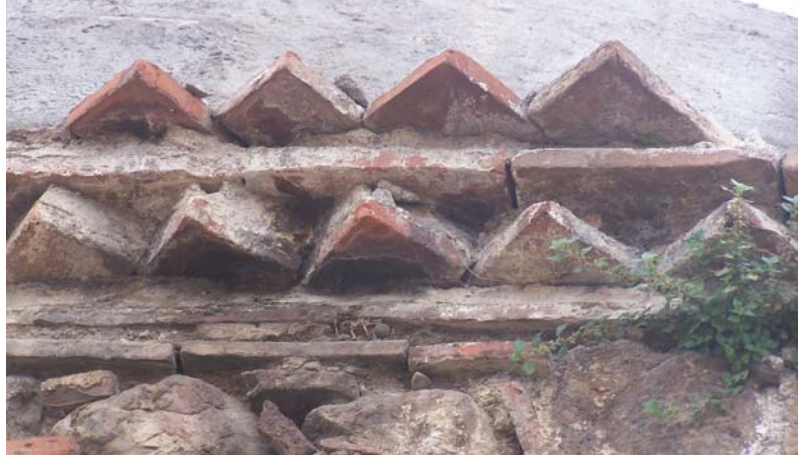
Şekil C.5-161: Kirpi saçak; İznik- Büyük Hamam (15.10.2006)
