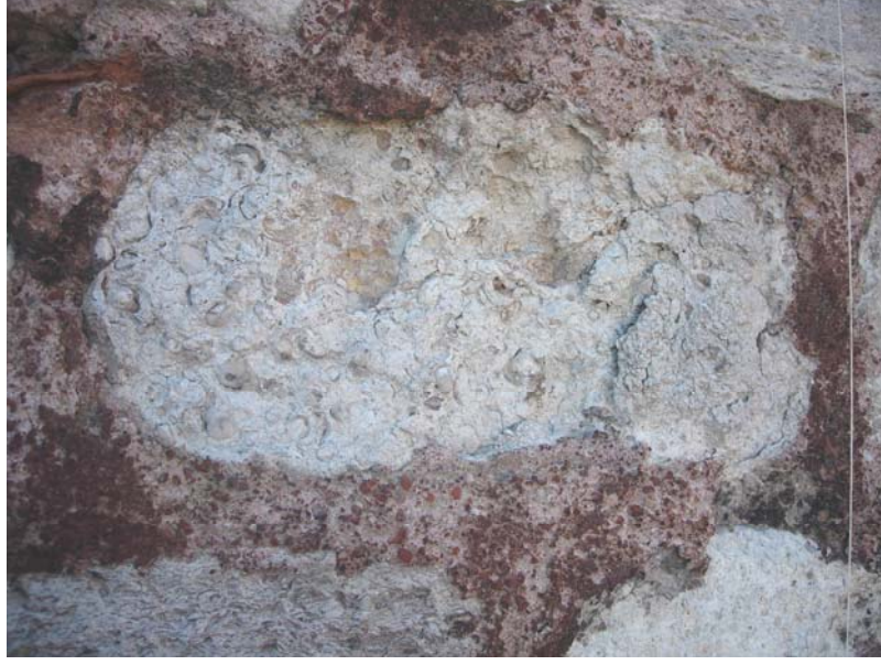
Şekil C.7-27: Soyunmalık kuzeydoğu cephesi; yüzey kaybı
