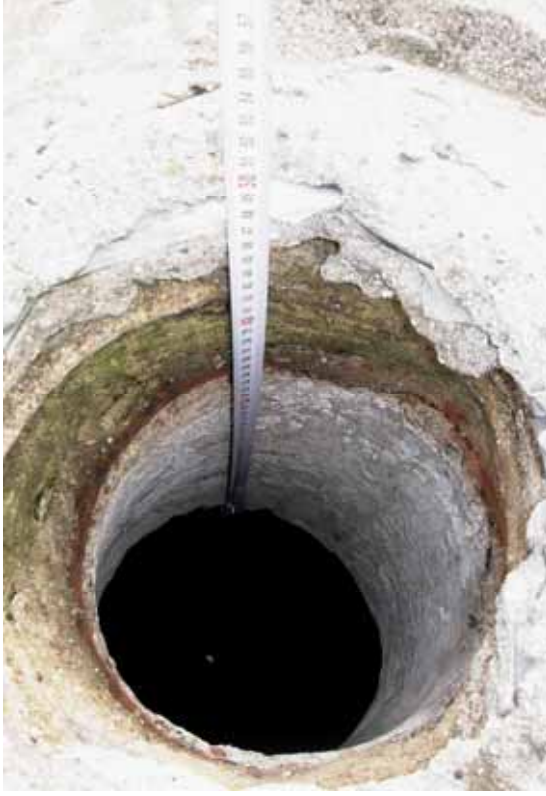
Şekil C.5-94: Kubbe kalınlığı ölçümü
