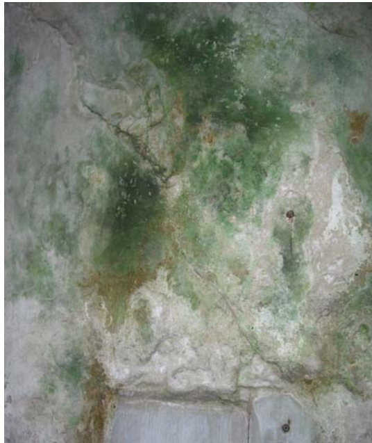
Şekil C.7-34: Z05-3 duvarlarındaki yoğun yosunlanma (01.11.2006)
