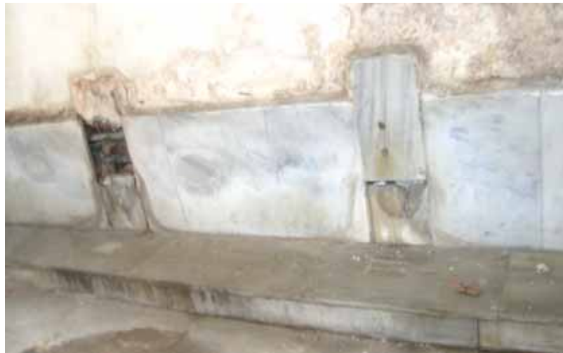
Şekil C.3-129: Z05a; kuzeydoğu duvarı ve mermer seki
