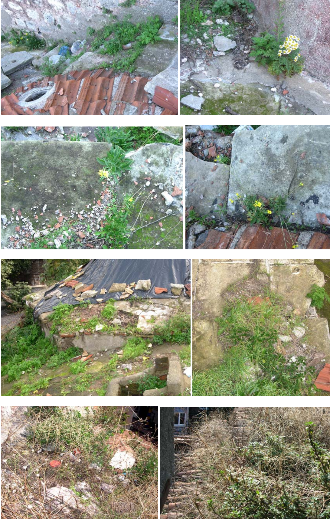
Şekil C.7-10: Örtü sisteminde gözlenen bitkilenme (Ekim 2006)
