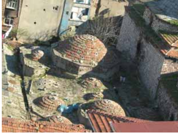
Şekil C.2-5: Sıcaklık kubbelerinin genel görünümü
