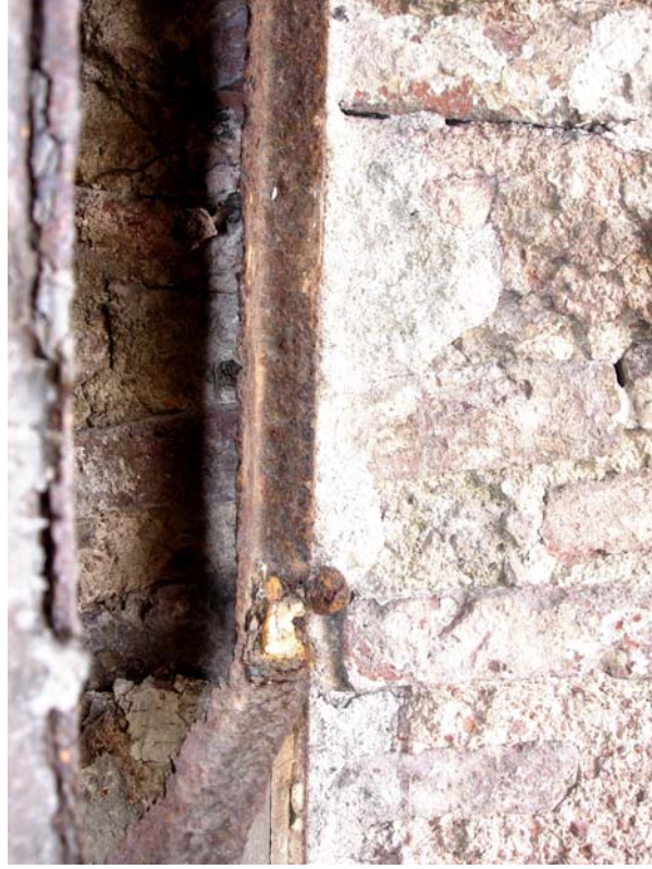
Şekil C.6-10: Kuzeydoğu penceresi; tesbit çivisi
