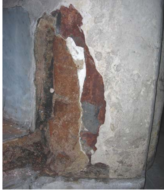
Şekil C.5-24: Z05d; sökülmüş koltuk taşı izi
