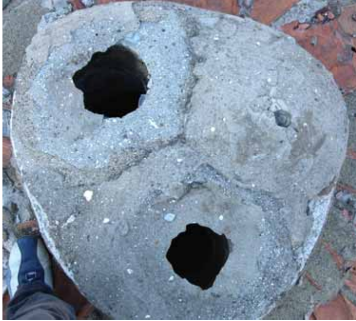
Şekil C.5-90: Işık gözünü örten cam fanusa dair iz (Z05c)
