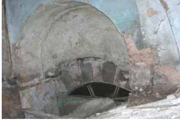
Şekil C.3-11: Z02a girişinin soyunmalığa bakan cephesi
