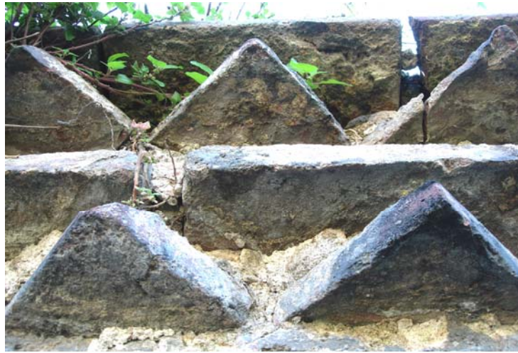
Şekil C.5-139: Kırpi saçak; kasnak kuzeybatı duvarı
