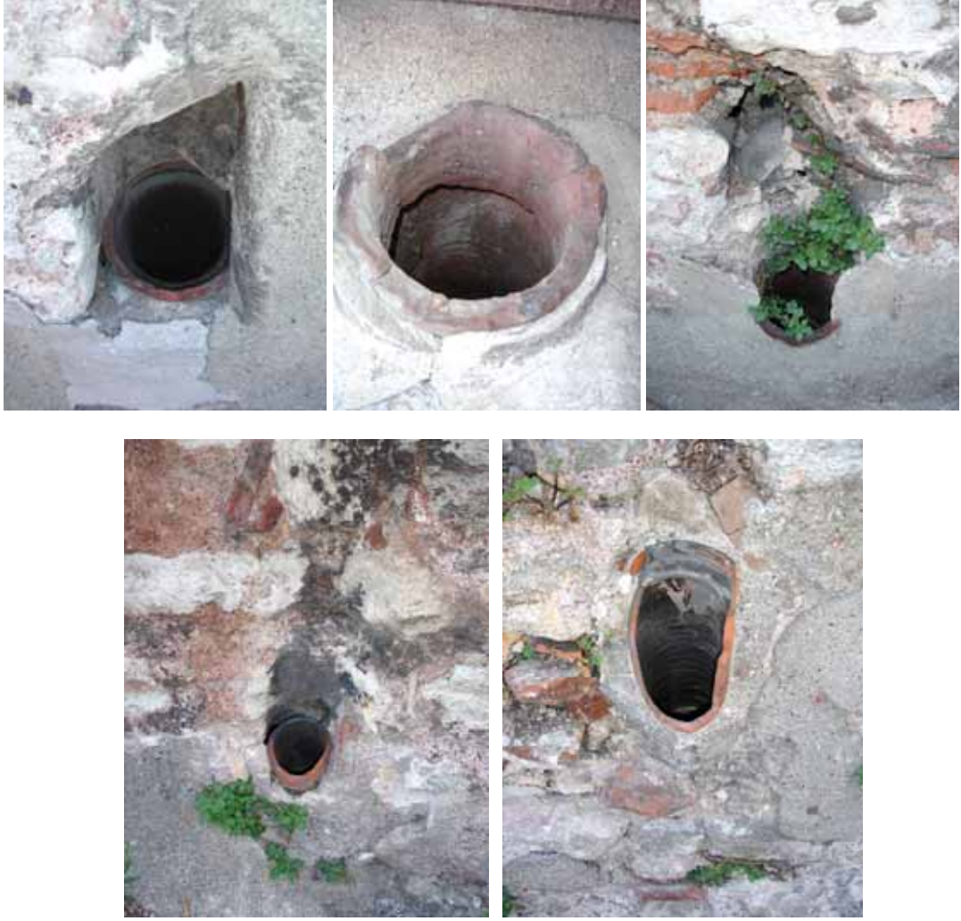
Şekil C.4-19: Soyunmalık kuzeydoğu cephesi; tüteklikler
