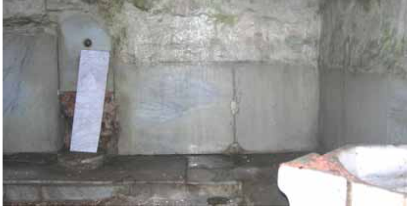
Şekil C.3-218: Z05-3; kuzeybatı duvarı ve seki
