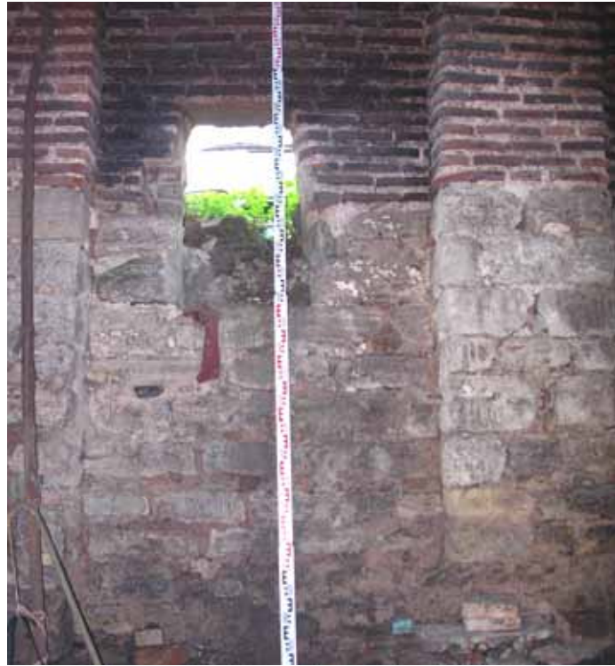
Şekil C.3- 250: Z07; kuzeydoğu duvarındaki pencere açıklığı
