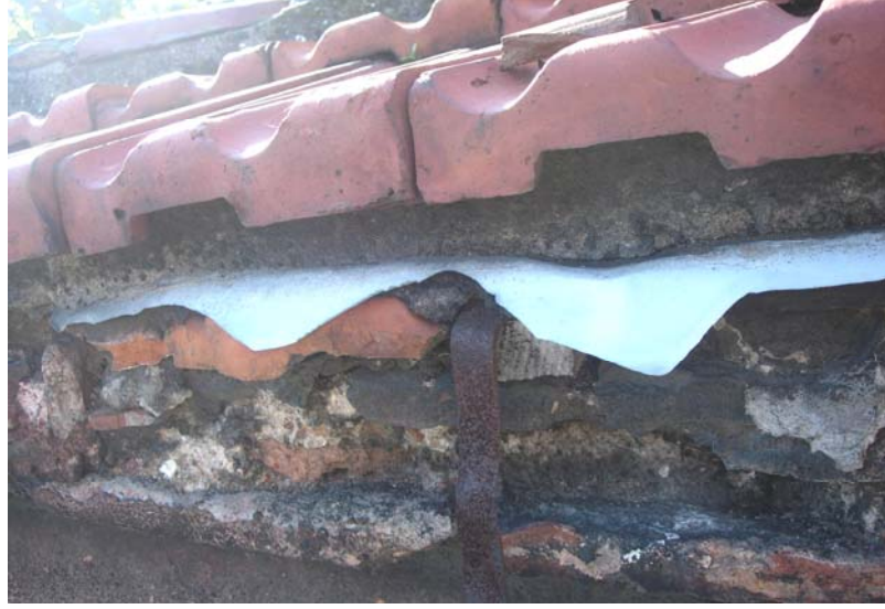
Kuzeydoğu Cephesi Saçak Korniş
