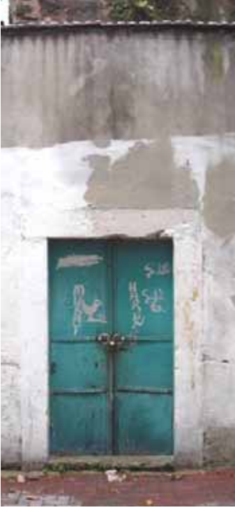
Şekil C.2-13: Kadınlar Bölümü; giriş kapısı
