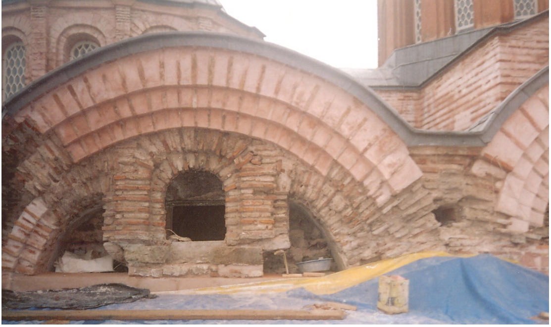
Şekil E.8: Horasan harcıyla yapılan derzleme örneđi
