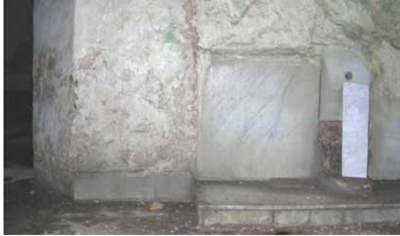
Şekil C.3-216: Z05-3; kuzeybatı duvarı ve seki
