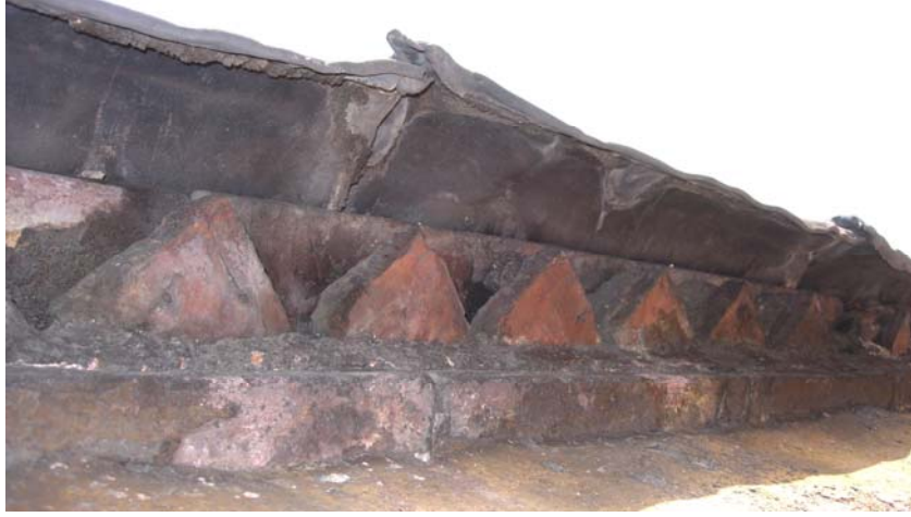
Şekil C.5-148: Kirpi saçak; kasnak güneybatı duvarı (tek dişli sıra)
