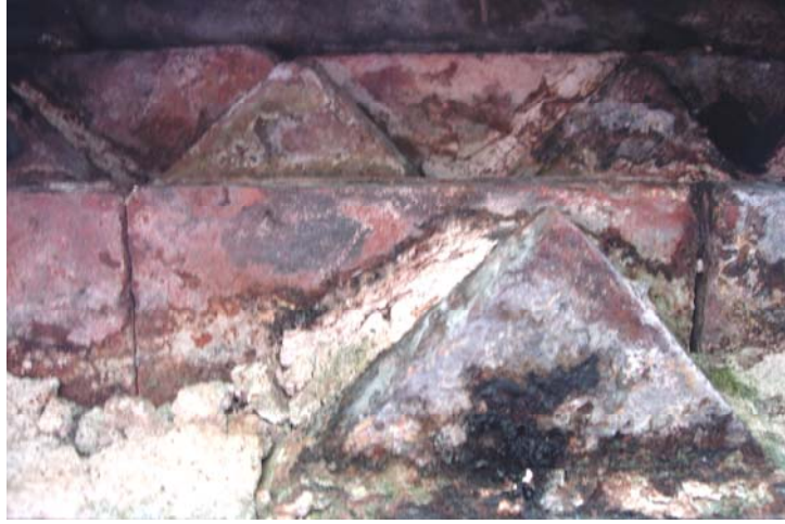
Şekil C.5-155: Kirpi saçak; kasnak güneydoğu duvarı (orta bölüm)
