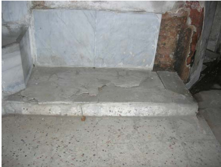
Şekil C.5-21: Z05b döşemesi; kuzeydoğu bölümü
