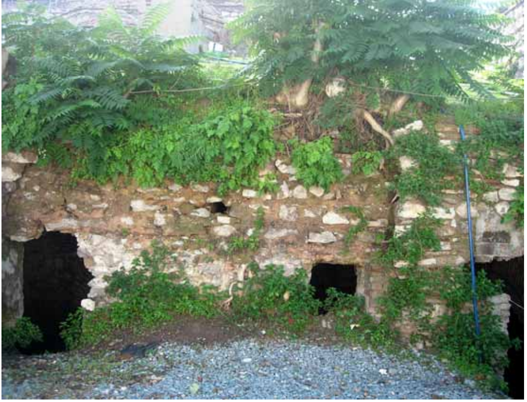
Şekil C.3- 251: Z07; kuzeydoğu cephesine bakış
