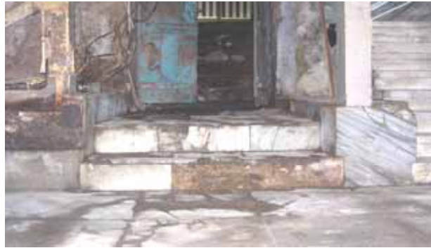
Şekil C.3-17: Z02a; mermer basamaklardaki hasar
