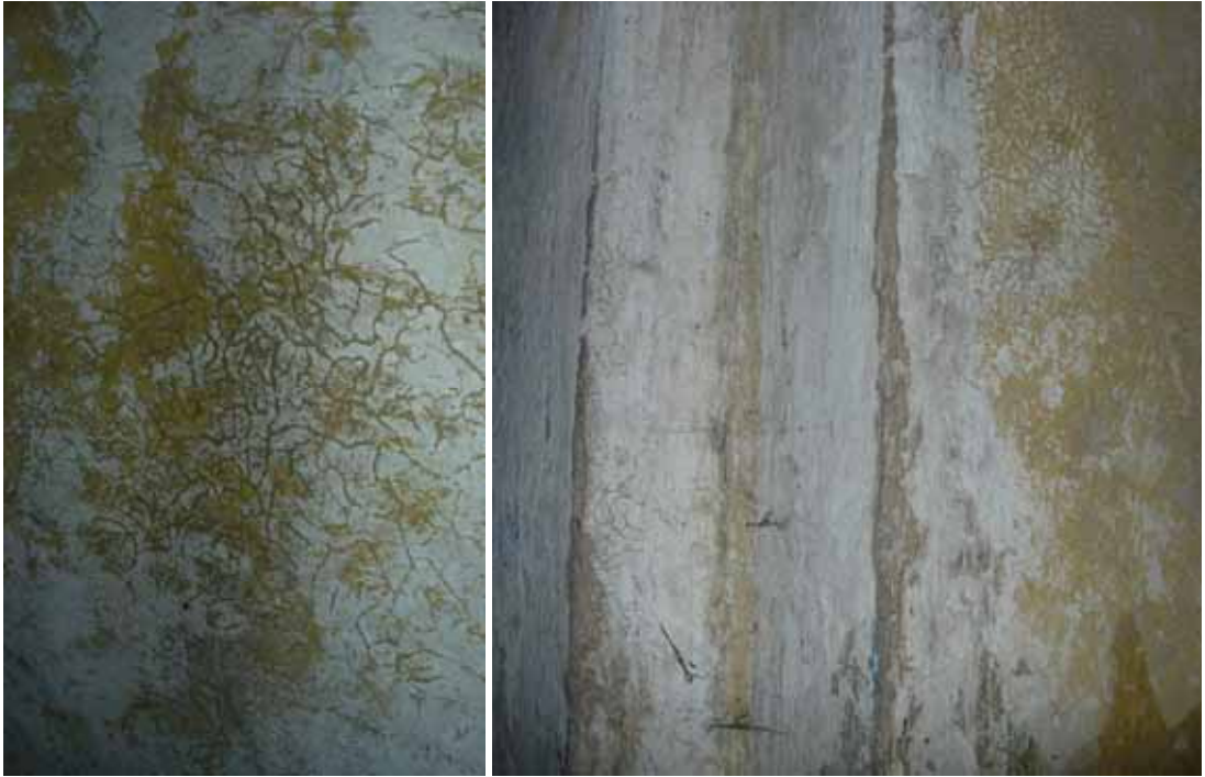
Şekil C.3-91: Sıvalı Z04 duvarlarının görünümü
