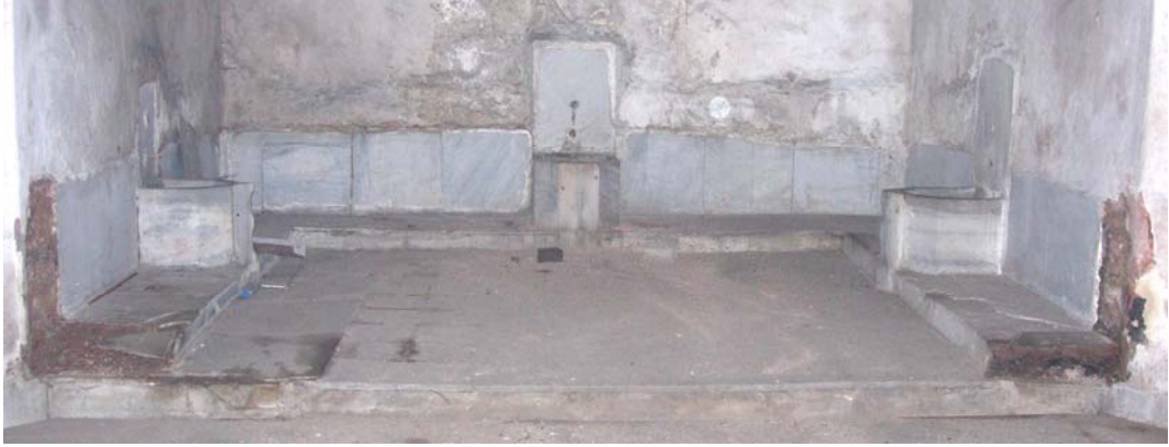
Şekil C.7-18: Eyvanlardan sökülen koltuk taşlarına ait izler
