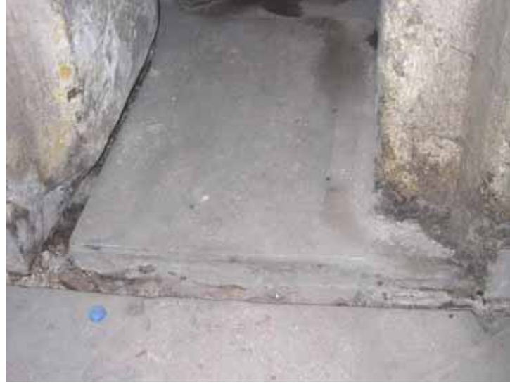
Şekil C.3-114: Z05 döşemesini çevreleyen pis su kanalı
