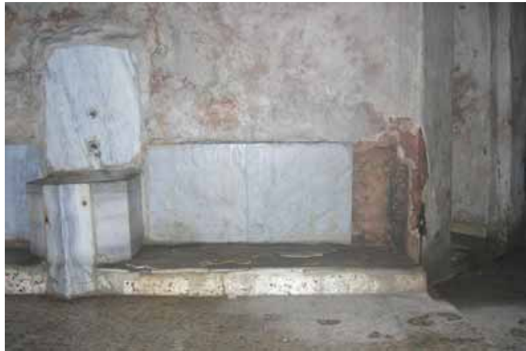
Şekil C.3-144: Z05b; kuzeydoğu duvarı ve seki
