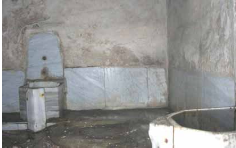
Şekil C.3-166: Z05d; kuzeydoğu duvarı ve seki
