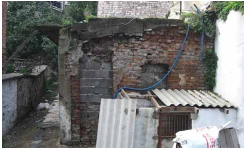
Şekil C.4-12: Kuzeydoğu cephesi, muhdes bina
