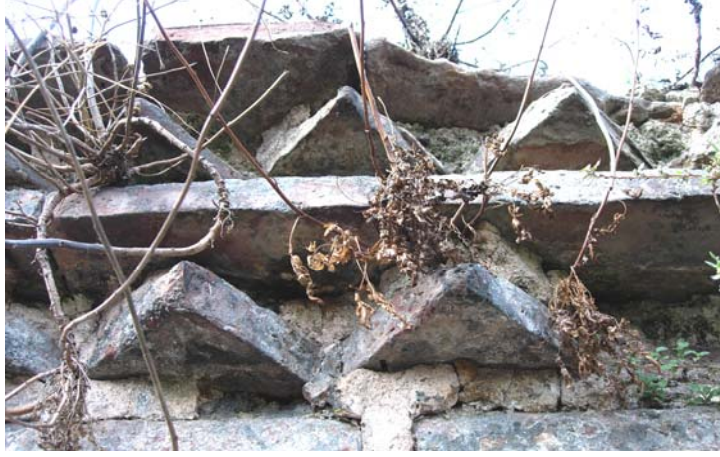
Şekil C.5-154: Kirpi saçak; kasnak güneydoğu duvarı
