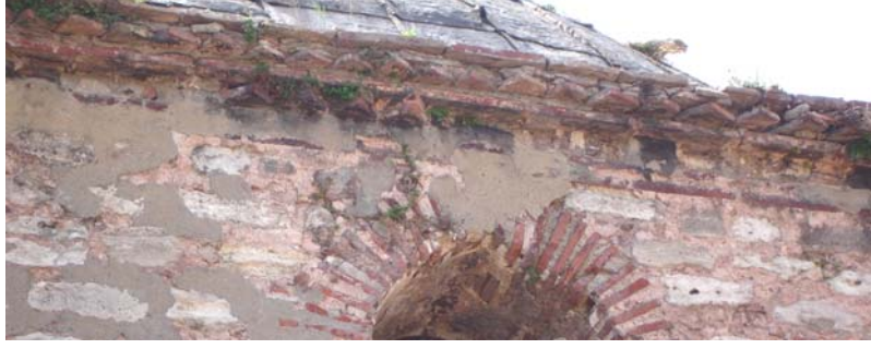
Şekil C.5-129: Kirpi saçak; kasnak kuzeydoğu duvarı
