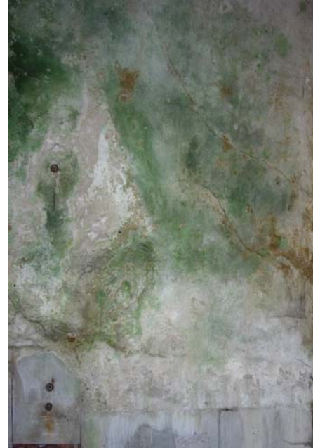
Şekil C.7-34: Z05-3 duvarlarındaki yoğun yosunlanma (01.11.2006)
