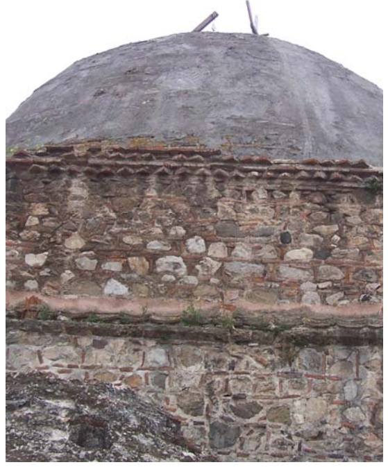
Şekil C.5-126: Kirpi saçak; (İznik- Büyük Hamam)
