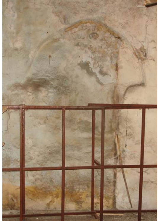
Şekil D.61: Soyunmalık KB Duvarı; kapatılan niş
