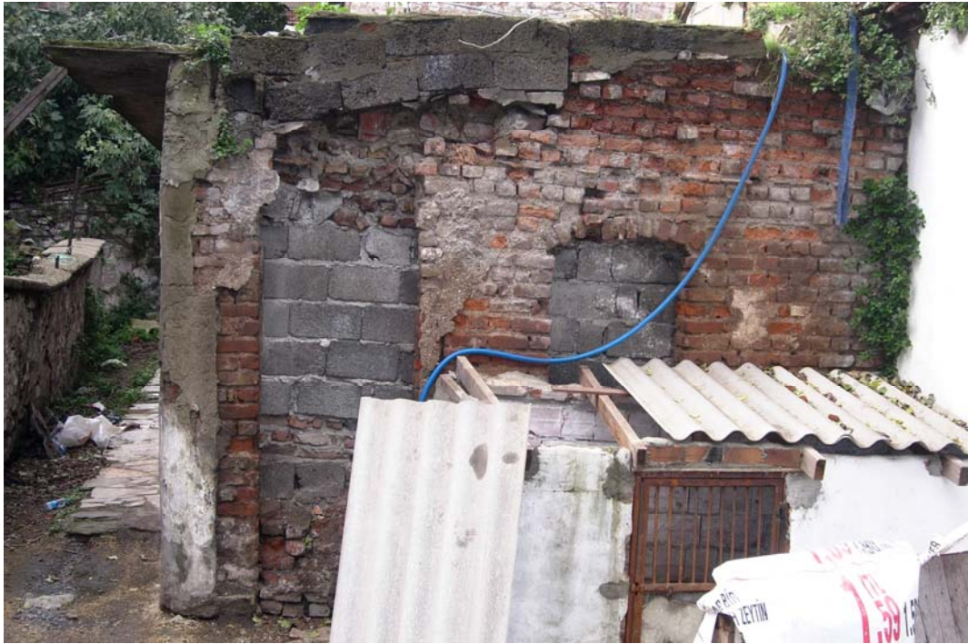
Şekil D.6: Muhdes yapının kuzeydoğudan görünümü
