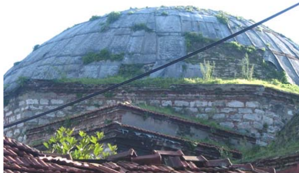
Şekil C.5-136: Kirpi saçak; kasnak kuzey duvarı
