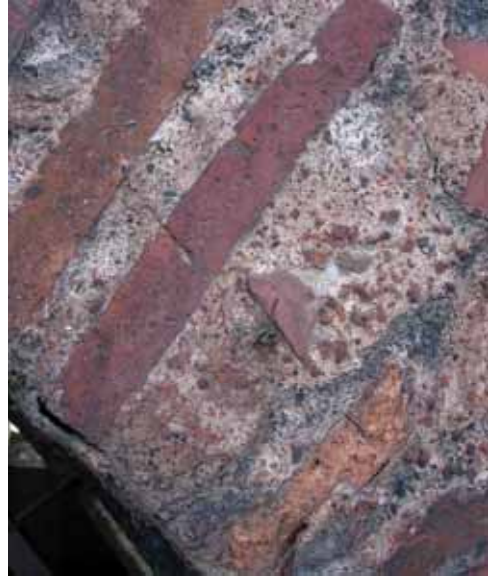
Şekil C.4-17: Kemer, derz harcı
