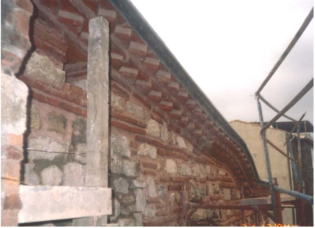
řekil E.6: Kirpi saak korniřinin yapımı [Zeyrek Camii, Dıř Narteks Kuzey Duvarı Restorasyonu, 31.12.2004]
