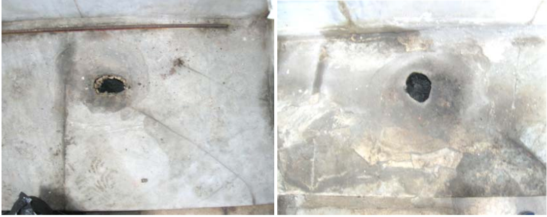
Şekil C.5-20: Z05b; seki döşemesinde açılan delikler (çapları=7cm ve 10.5cm)
