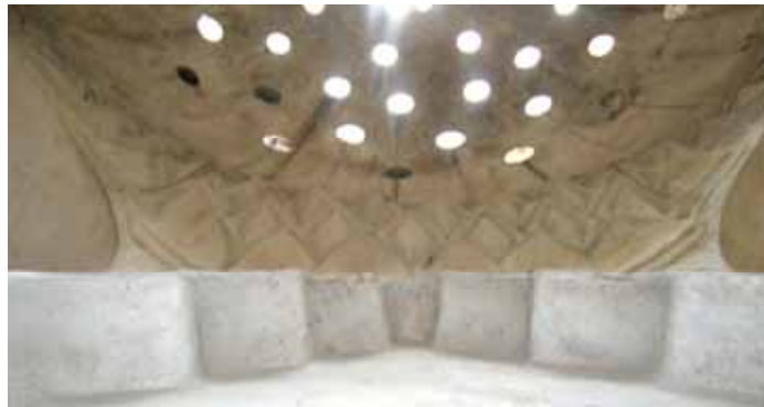
Şekil C.3-118: Z05 kubbesi; mukarnasların alttan görünümü
