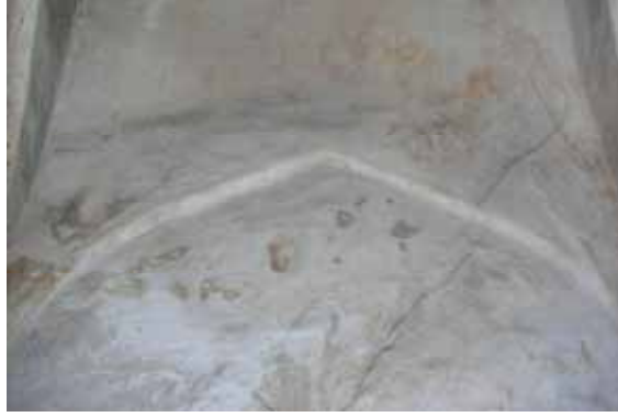
Şekil C.3-158: Z05c; güneydoğu kemeri
