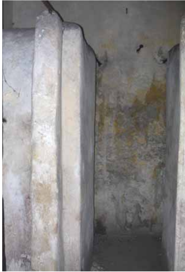
Şekil C.3-100: Z04a; muhdes bölücü duvarlar
