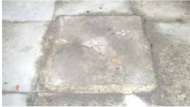
Şekil C.3-112: Z05; göbek taşının ortasındaki onarım izi
