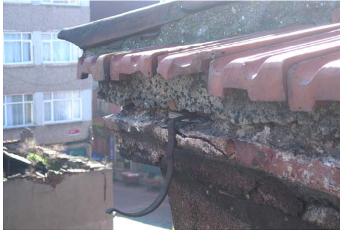
Şekil C.5-107: Z02 beden duvarı korniş; doğu köşe
