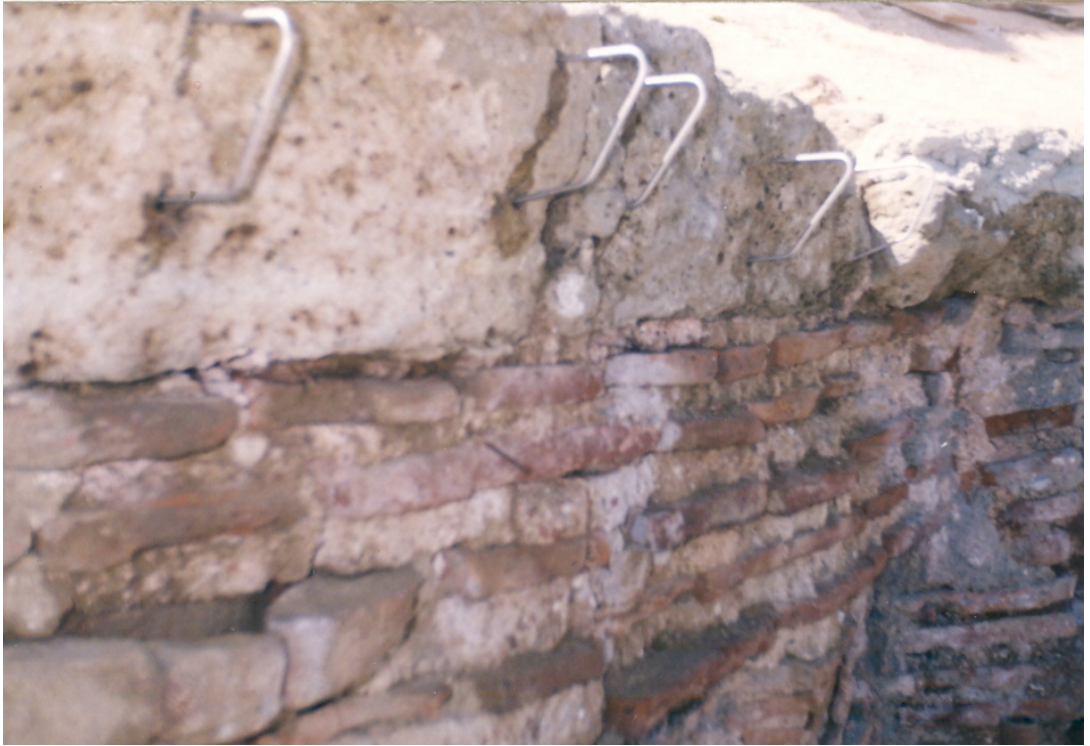
řekil E.7: Tař bütünleme uygulaması [Zeyrek Camii, Kuzey Kilise- Doęu Cephesi Restorasyonu, 2000]
