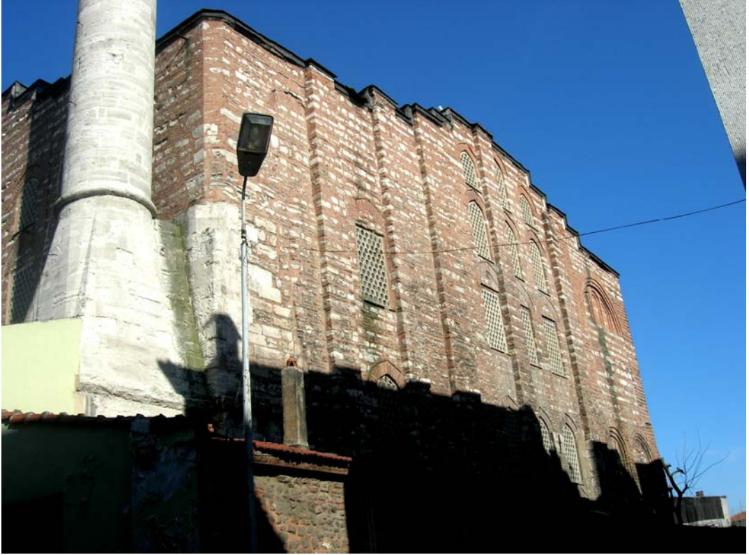
Şekil B.9: Gül Camii, güneybatı cephesi
