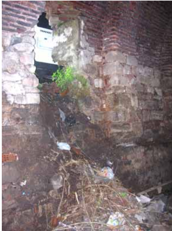
Şekil C.3- 252: Z07; kuzeydoğu duvarındaki açıklık
