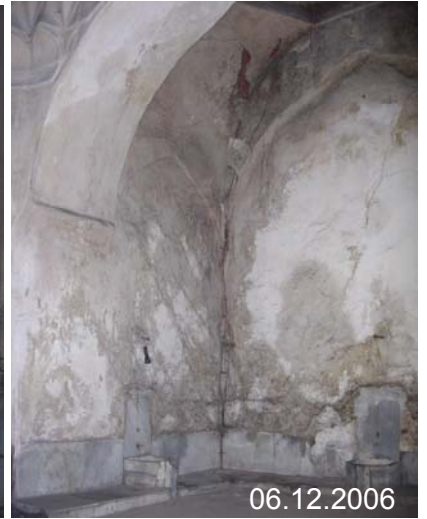
Şekil C.7-32: Duvarlarda nemden kaynaklanan renk değişimleri
