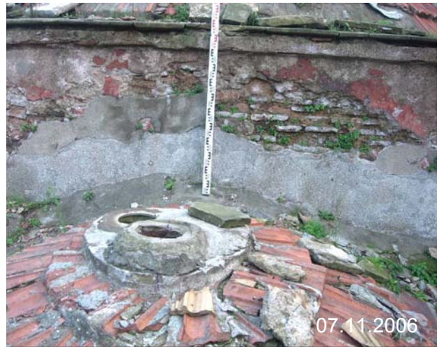
Şekil C.7-2: Kasnak duvarları; çimentolu sıvanın döküldüğü bölgeler
