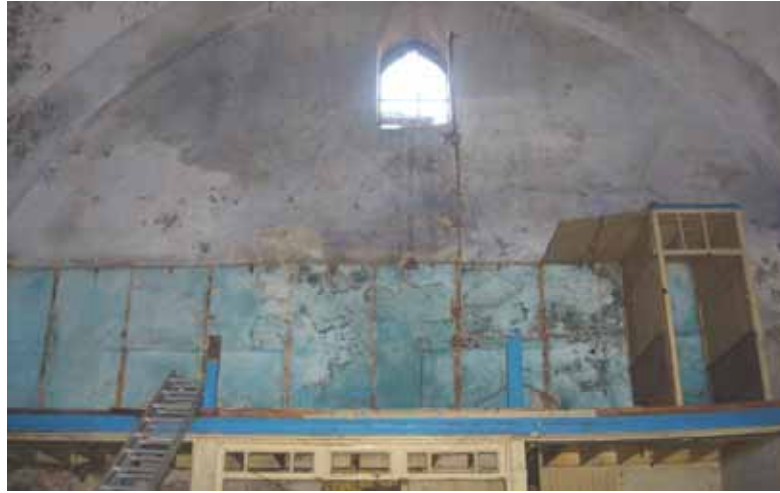
Şekil C.3-51: Soyunmalık; kuzeydoğu beden duvarı
