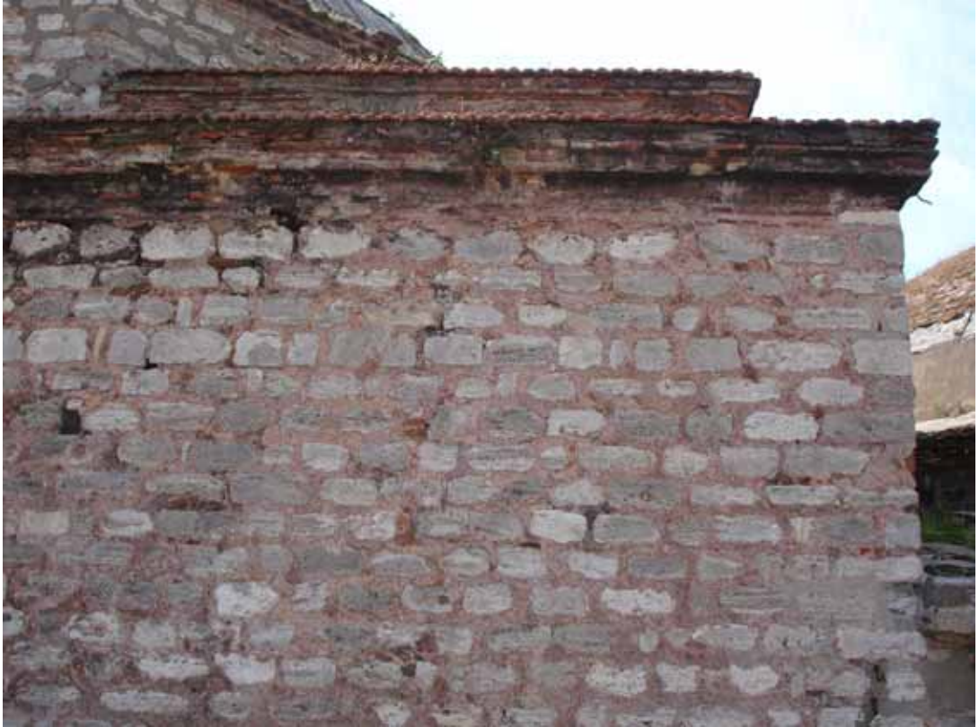
Şekil C.4-14: Kuzeydoğu cephesi, soyunmalık
