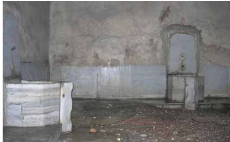
Şekil C.3-167: Z05d; güneydoğu duvarı ve seki
