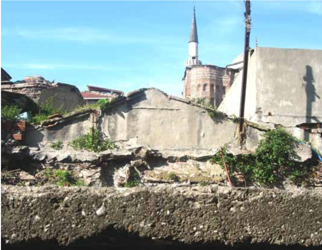
Şekil C.3- 237: Z06'nın eğimli çatı örtüsü (güneydoğu cephe)
