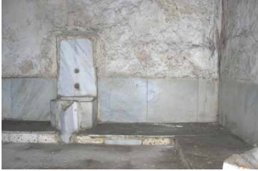
Şekil C.3-151: Z05c; kuzeybatı duvarı ve seki
