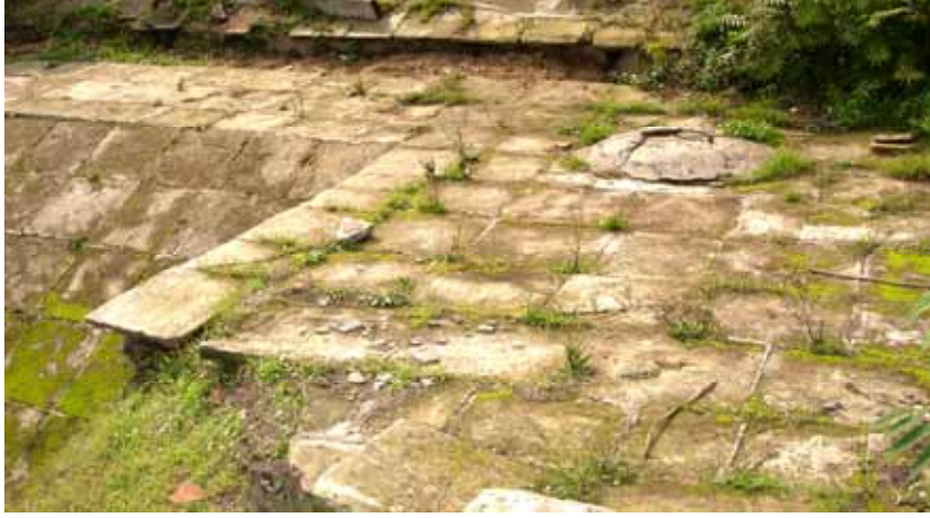
Şekil C.5-102: Z07- odunluk bölümünün yüksek çatılı taş örtüsü
