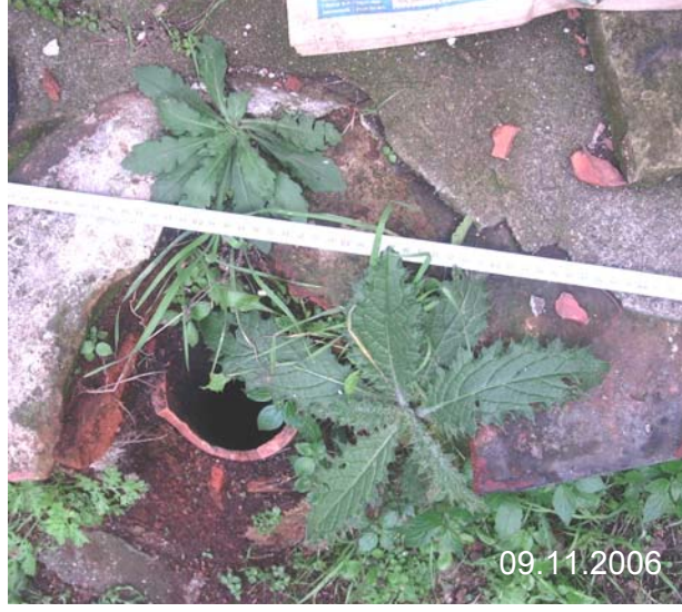
Şekil C.7-22: Bitkilerle üstü kapanan tüteklikler
