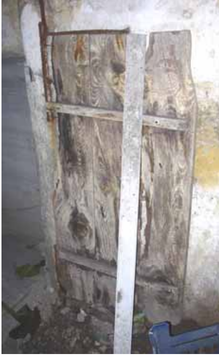
Şekil C.3-106: Z04b; ahşap kapı
