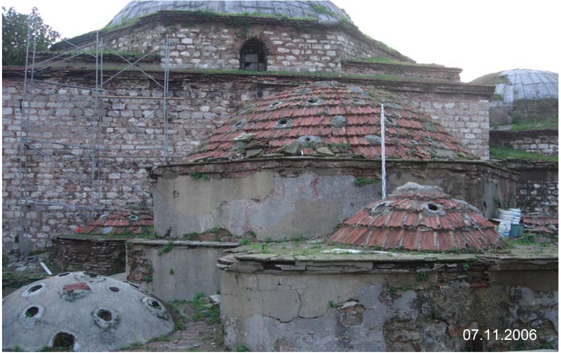
Şekil C.7-1: Çimentolu sıvayla kaplı kasnak duvarları
