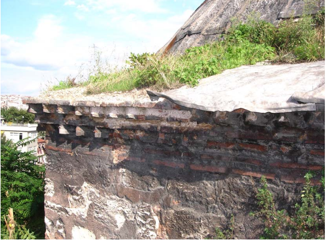
Şekil C.5-146: Kirpi saçak; kasnak batı duvarı (kuzey bölüm)
