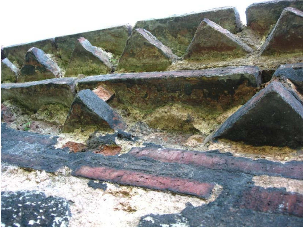
Şekil C.5-140: Kirpi saçak; kasnak kuzeybatı duvarı (korunmuş örgü)
