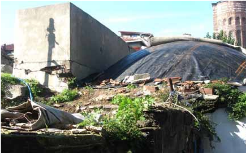
Şekil C.5-103: Z08'in örtüsü yok olmuş kubbesi
