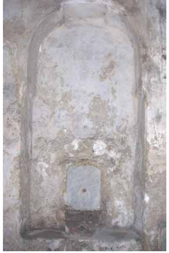
Şekil C.3-84: Z03- kuzeydoğu duvarı; niş
