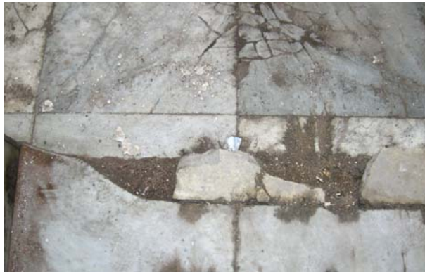
Şekil C.5-3: Z02a; basamaklardaki bozulmalar
