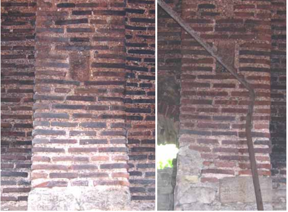
Şekil C.3- 247: Z07; destek kemerlerindeki gergi boşlukları
