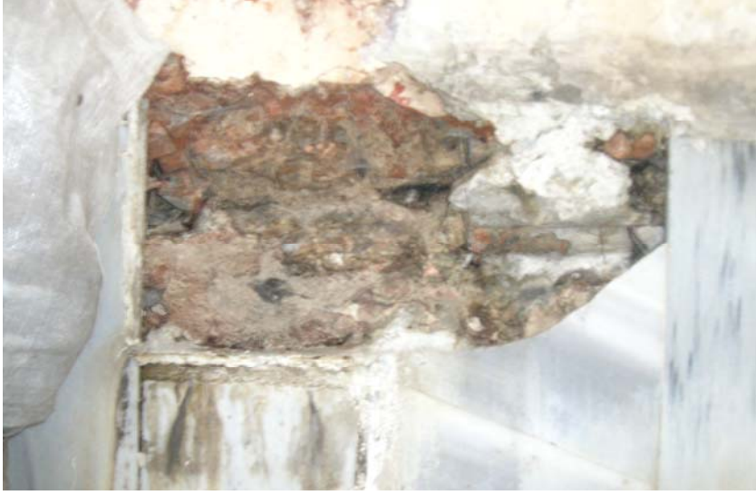
Şekil C.7-15: Sökülen mermer duvar kaplamaları (06.12.2006)
