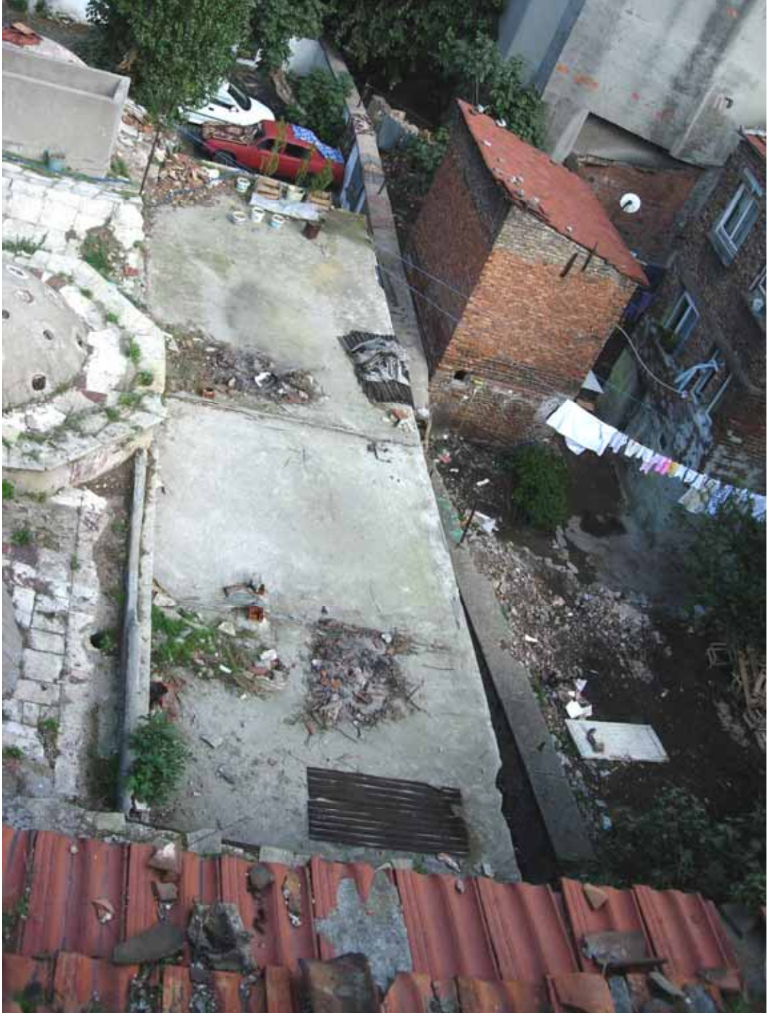
Şekil C.5-104: Hamamın güneydoğusundaki muhdes betonarme çatı
