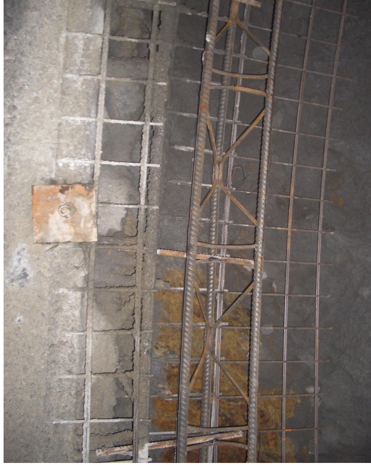
Şekil 2.7: İstanbul Metrosu Çelik (Kafes) İksa
