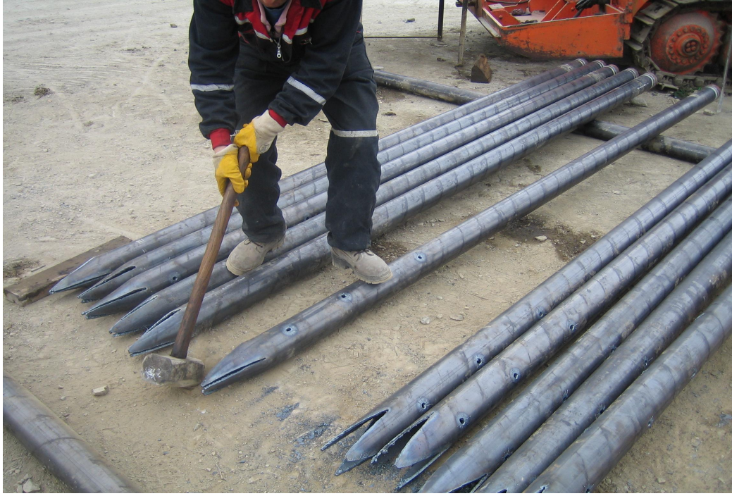
Şekil 4.4: Umbrella Arch Yönteminde Kullanılan Borular
