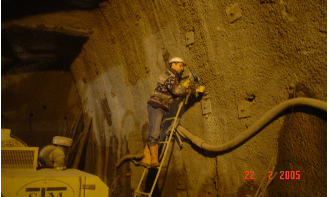
Şekil 2.14: Tünel İçi Deformasyon (Konverjans) Ölçümleri
