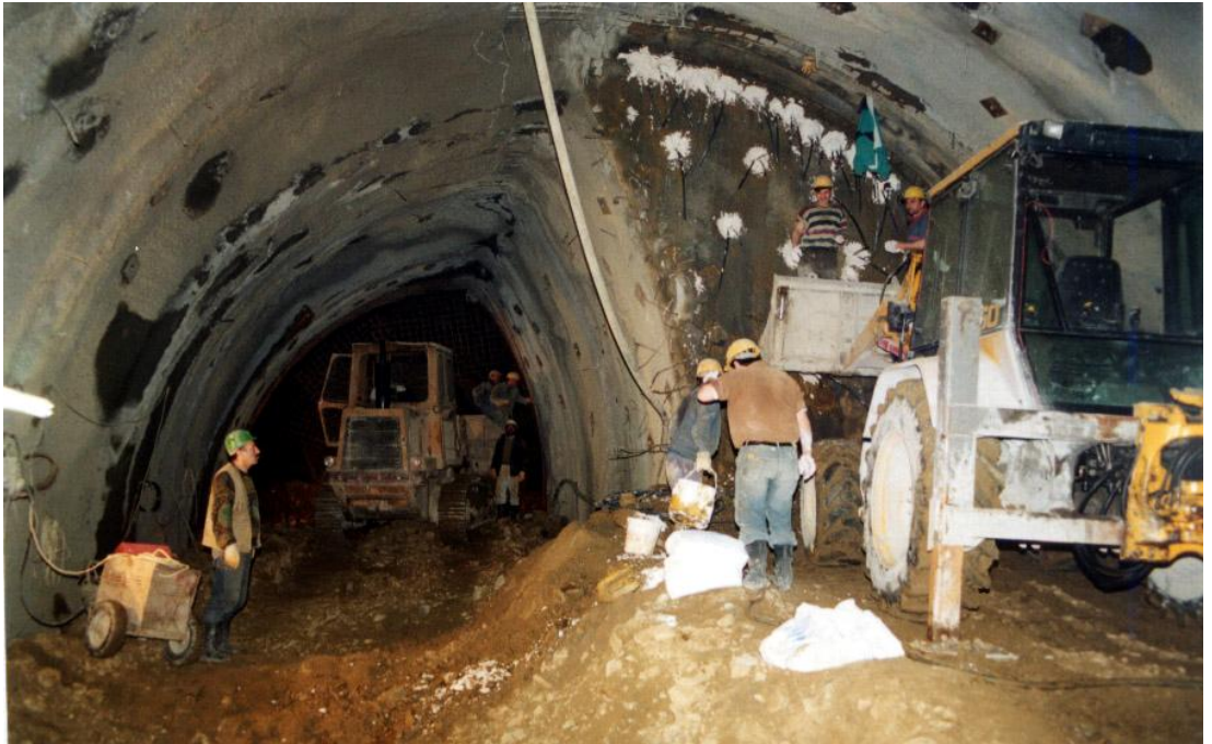
Şekil 2.2: Kademeli Kazı Örneği-1(İstanbul Metrosu Taksim-Yenikapı)
