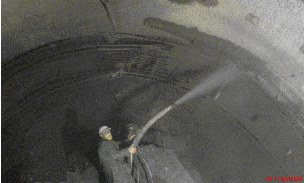
Şekil 2.9: Püskürtme Beton “Shotcrete” İmalatı-Kemer
