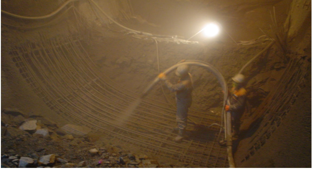
Şekil 2.8: Püskürtme Beton “Shotcrete” İmalatı (İnvert)
