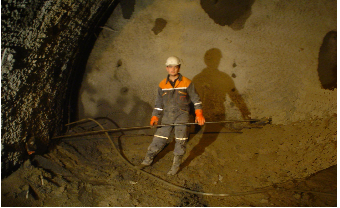
Şekil 2.11: Kaya Bulonu Montajı ve Enjeksiyonu
