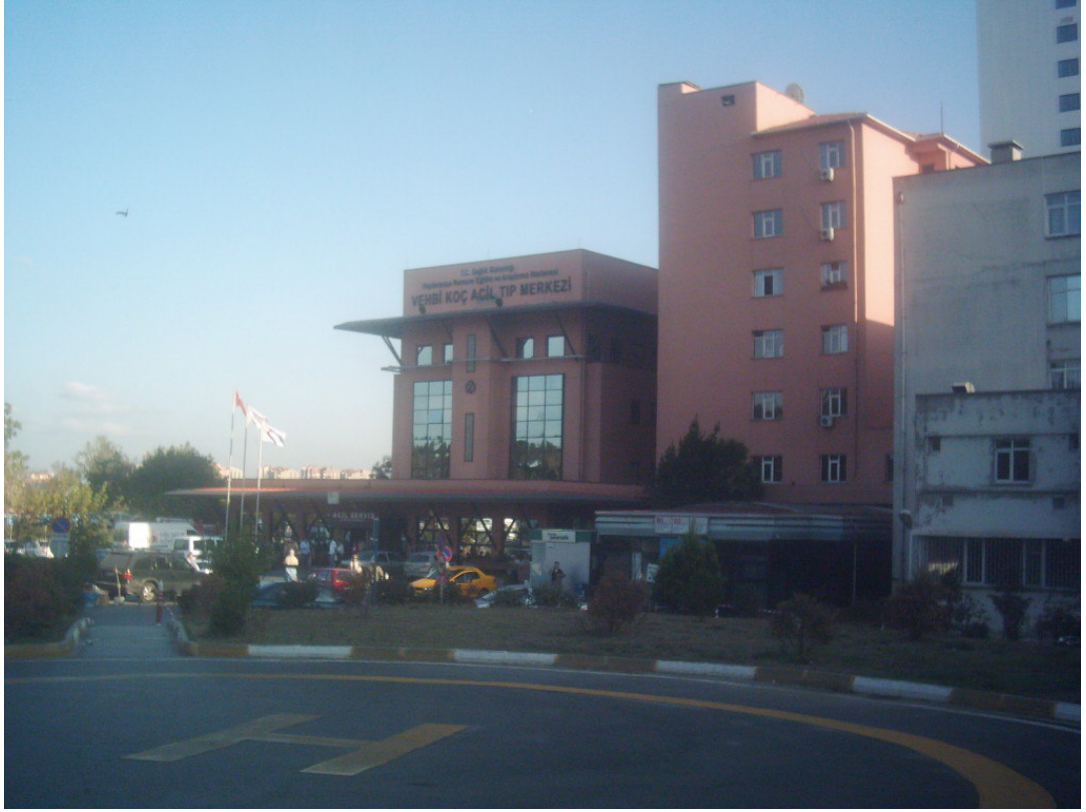
Şekil.5.13. Koç Acil Tıp Merkezi Dışarıdan Görünümü
