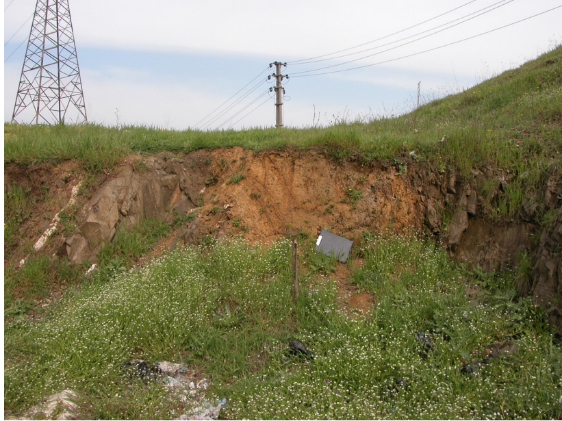
Şekil 4.5: Km 0+300.00'da Ezilme Zonu ve Aşırı Ayrışma
