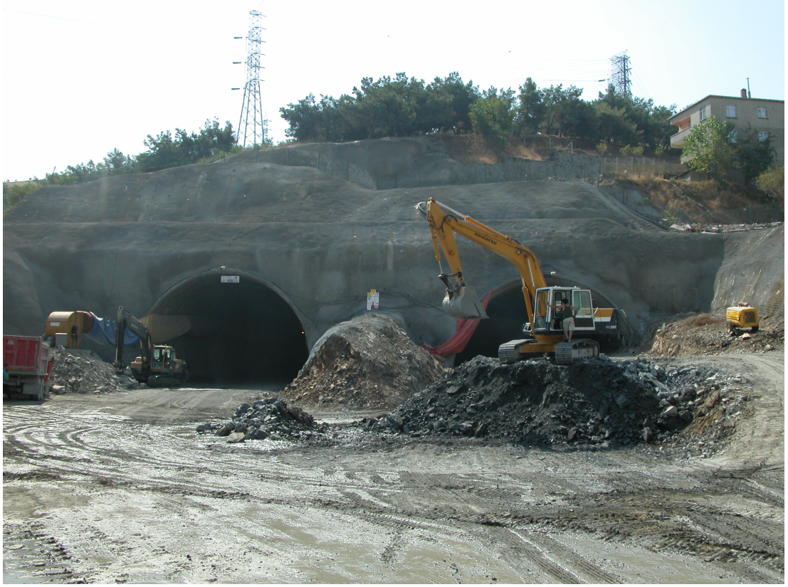
Şekil 3.8: Portal Kazı Aşaması ve Tüneller
