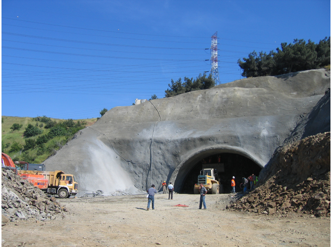
Şekil 3.7: Portal Kazıları Sırasında İlk Şevin Oluşturulması
