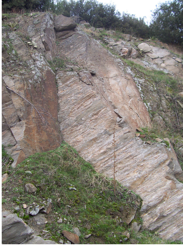
Şekil 2.3: Ülkemizde Bir Otoyol Yarmasında Meydana Gelmiş Kama Tipi Kayma (Alaşehir-Manisa)
