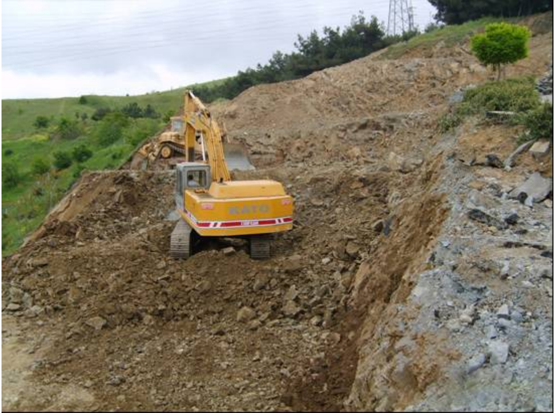
Şekil 3.5: Kağıthane Portali Yaklaşım Kazısı
