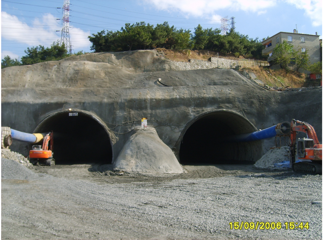
Şekil 3.9: Kazının Tamamlanmasının Ardından Tünel Üzerinde Kalan Şevler
