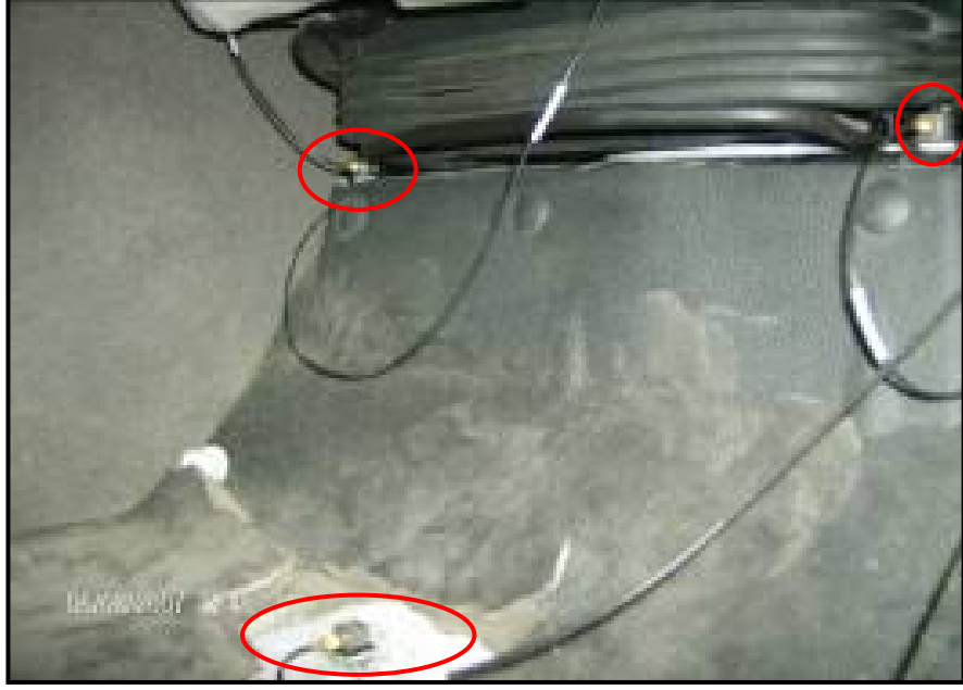
Şekil 4.7: Kabin Üzerinde Yerleştirilen İvme Ölçerler
