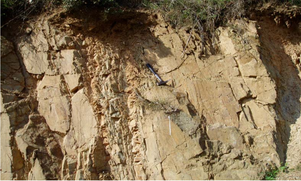
Şekil 3.8: Yayalar Formasyonundaki Çatlak ve Dolgular.
