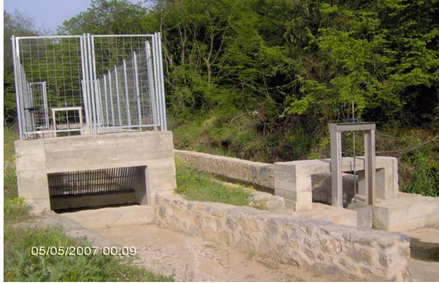
Şekil 4.4: İnceleme Alanı İçerisinde Yer Alan Yüzey Suyu Islah Çalışması.
