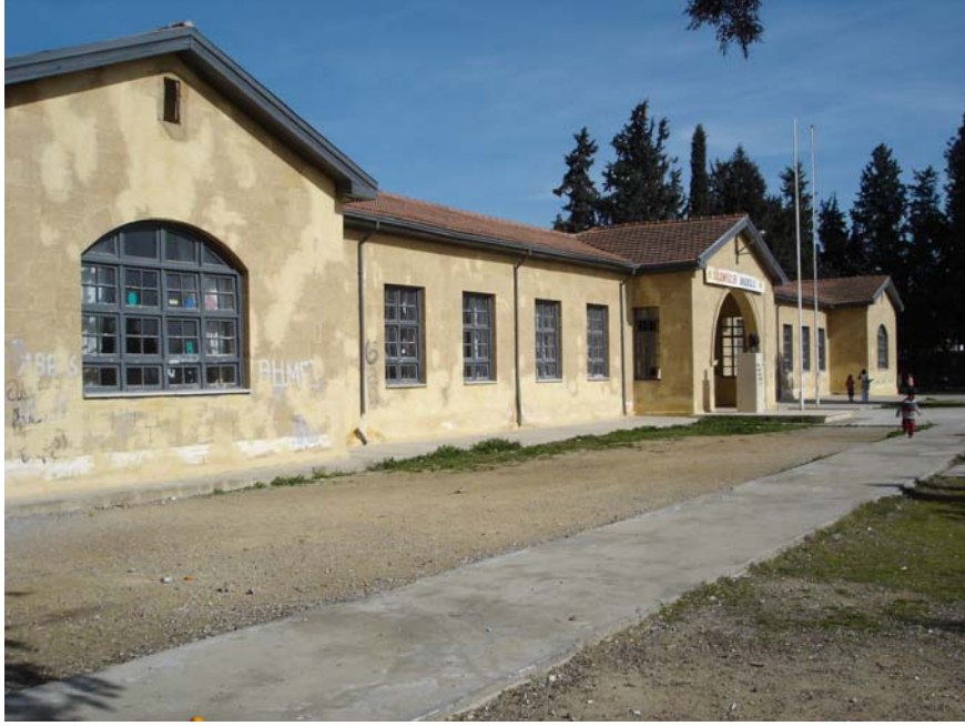
Şekil 3.112: İşçi konutları ve okul binasının günümüzdeki durumu.
