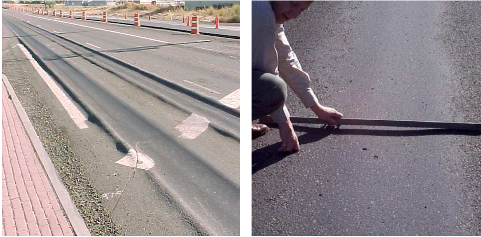
Şekil 3.7: Tekerlek İzi Oluşumunu Gösteren Fotoğraflar
