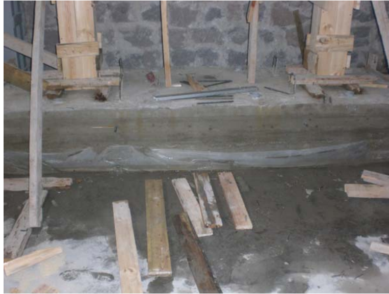
Şekil 3.2 : Kalıpları sökülmüş temel
