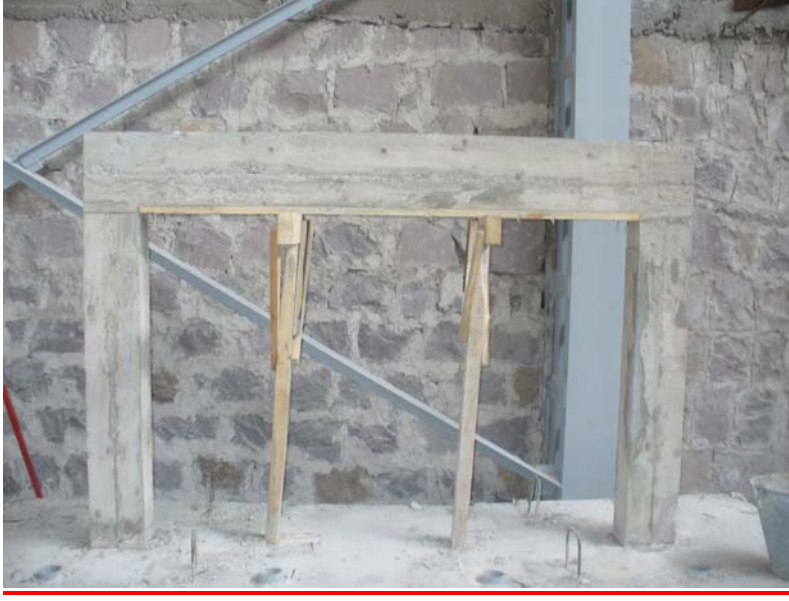
Şekil 3.11 : Çerçeveserin kalıplarının sökümüş şekli
