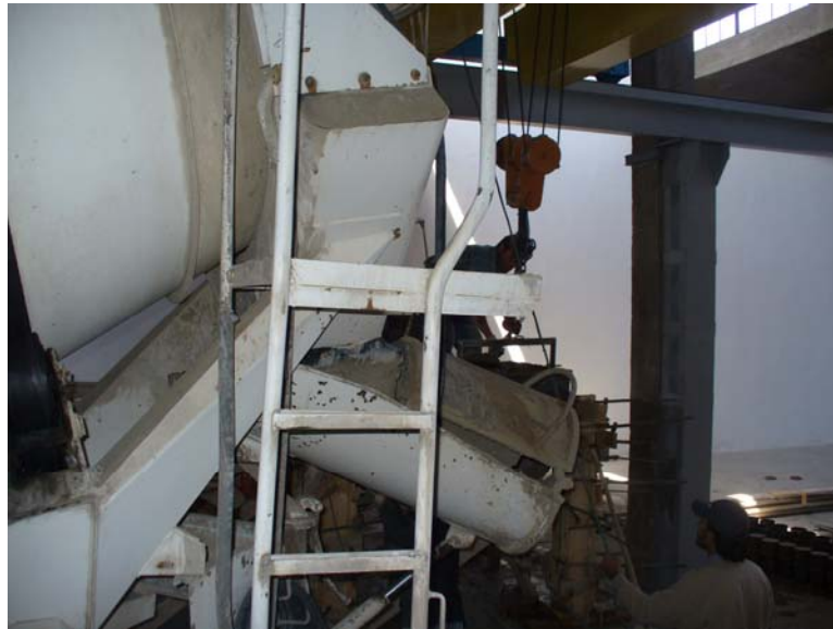
Şekil 3.6 : Çerçeve betonlarının dökümü
