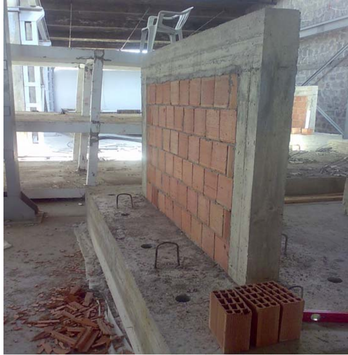
Şekil 3.14 : Bölme duvarının dış yüzeyde sıfır örülmesi
