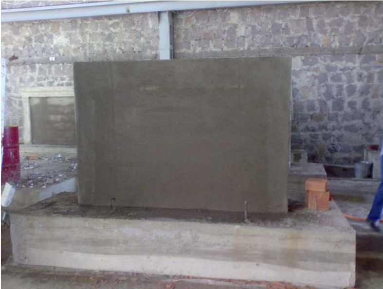
Şekil 3.16 : Bölme duvarlara sıva yapılması dış yüz
