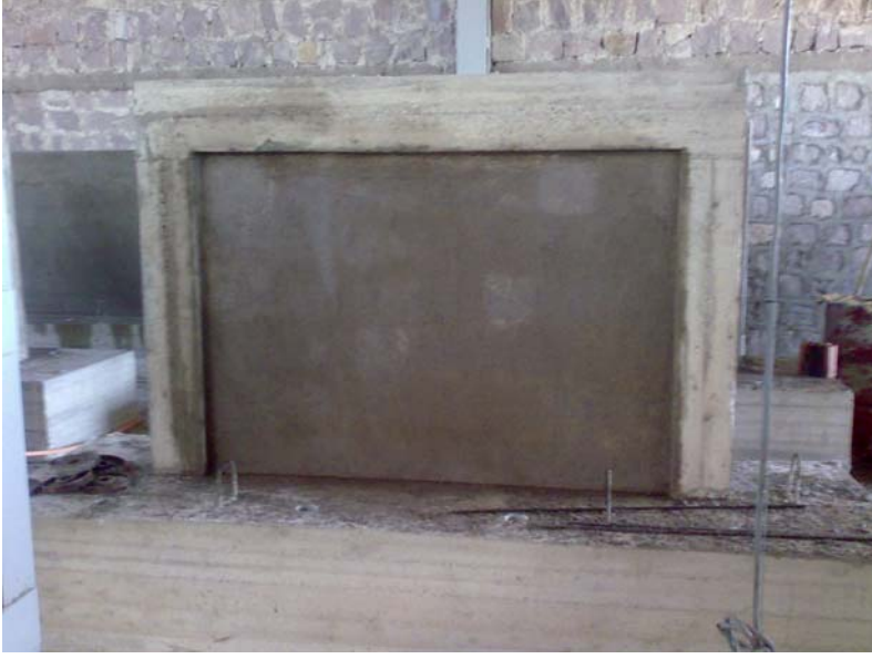
Şekil 3.15 : Bölme duvarlara sıva yapılması iç yüz
