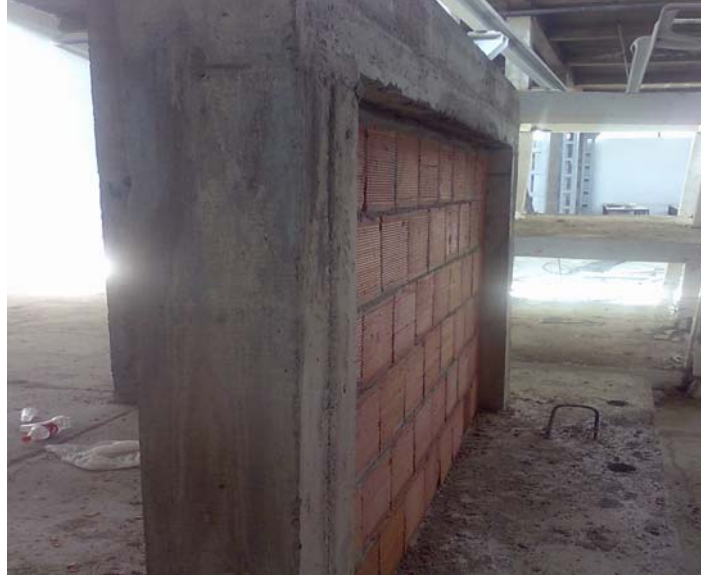
Şekil 3.13 : Güçlendirme için çerçevede bırakılan dış
