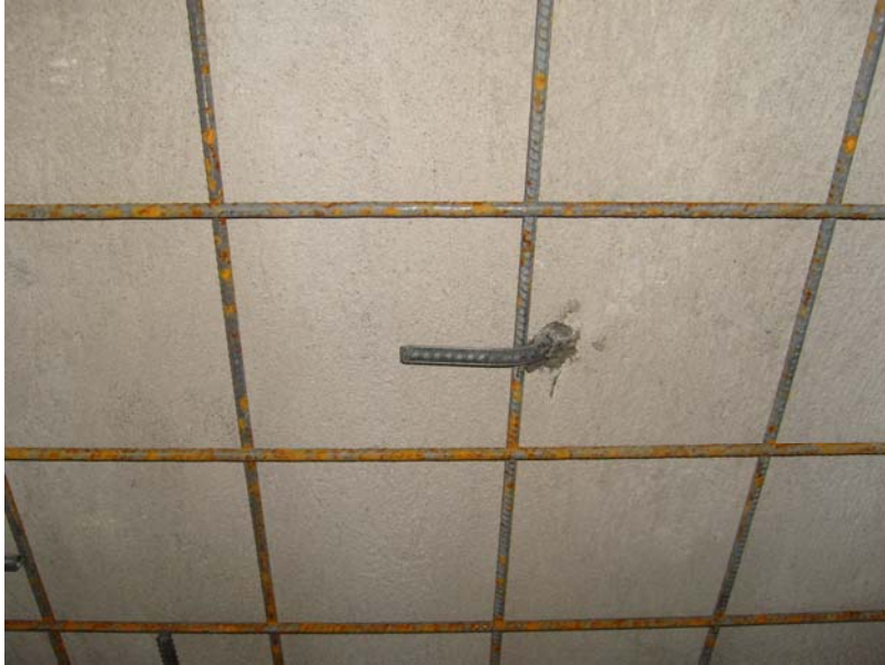
Şekil 3.29 : Duvar düzlemine dik ankraj yapımı
