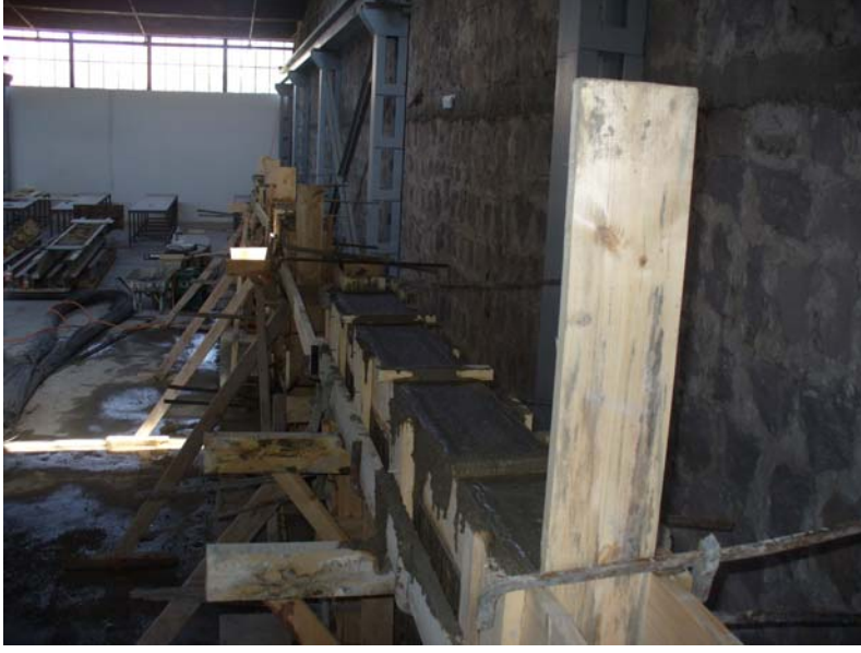
Şekil 3.7 : Beton dökümü tamamlanmış çerçeveler
