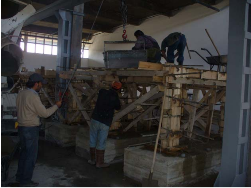
Şekil 3.8 : Çerçeve betonlarının dökümü yapılırken
