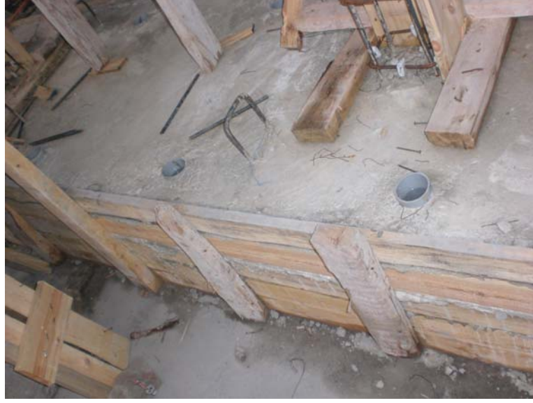
Şekil 3.1 : Temel betonu
