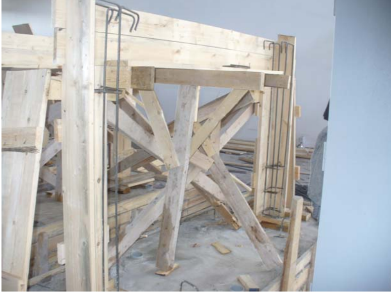
Şekil 3.3 : Çerçeve kalıplarının ve donatıların yapımı
