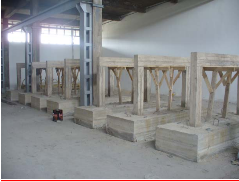
Şekil 3.12: Çerçeveserin kalıplarının sökümüş şekli ve laboratuvar
