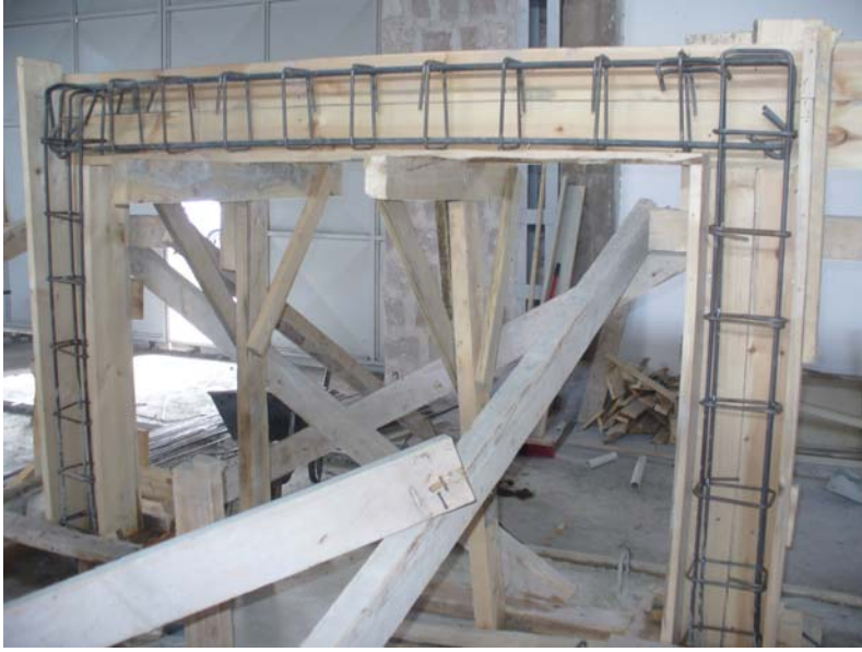
Şekil 3.4 : Donatıları tamamlanmış çerçeve
