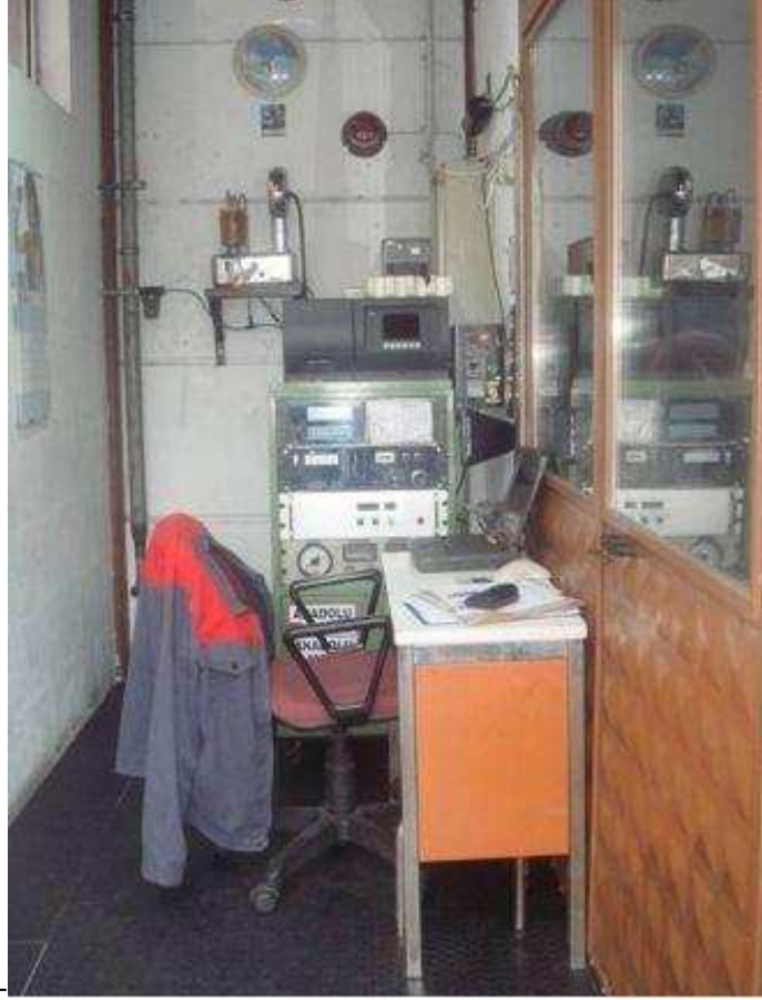
Şekil 5.8 Motor Test Kumanda Odasının Görünüşü
